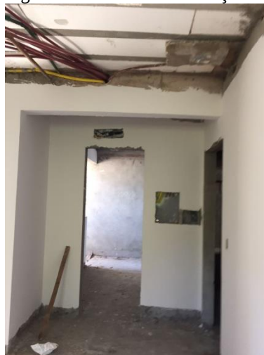
Figura 4 – Caixa de distribuição
