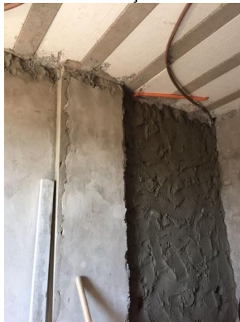
Figura 2- reboco curando X reboco em execução
