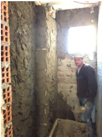
Figura 1 – início do reboco e taliscas
