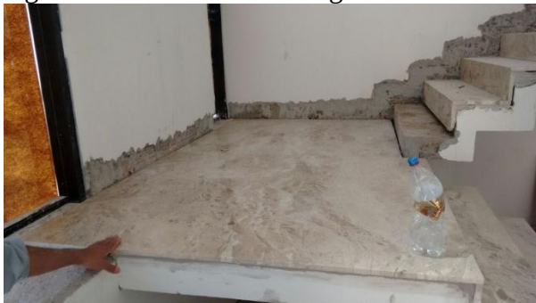
Figura 10: Assentamento de granito em escada
