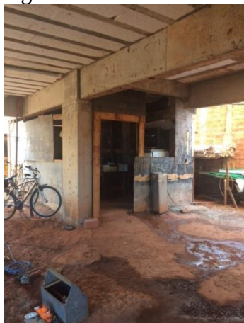
Figura 1: Canteiro de obras
