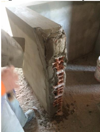
Figura 6: Parede em aplicação do emboço
