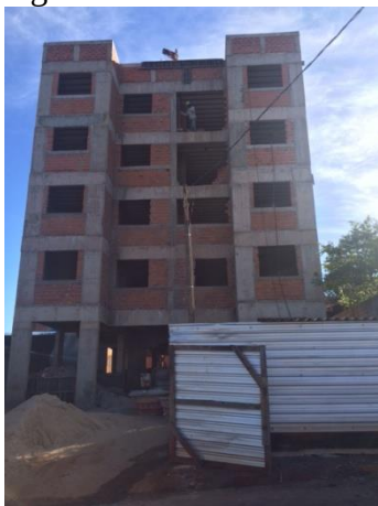
Figura 2: Canteiro de Obras
