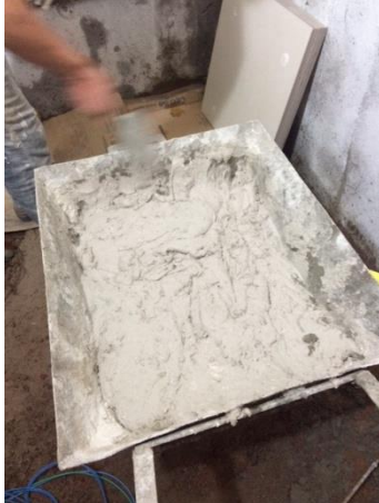
Figura 9: Argamassa AC3 para reboco
