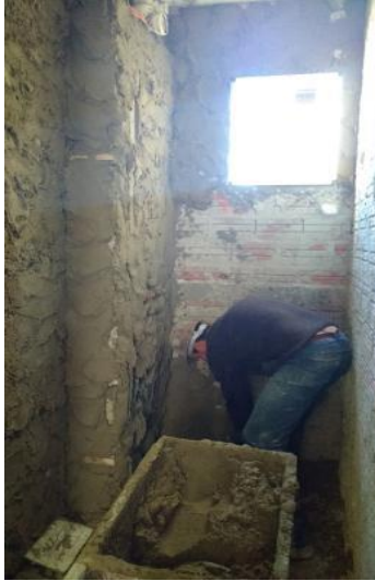
Figura 5: Parede em aplicação do emboço
