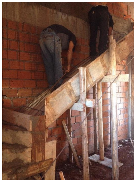
Figura 02 – Instalação da ferragem
