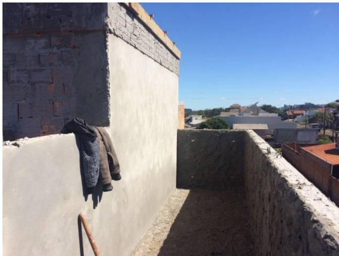
Figura: 13 - Reboco
