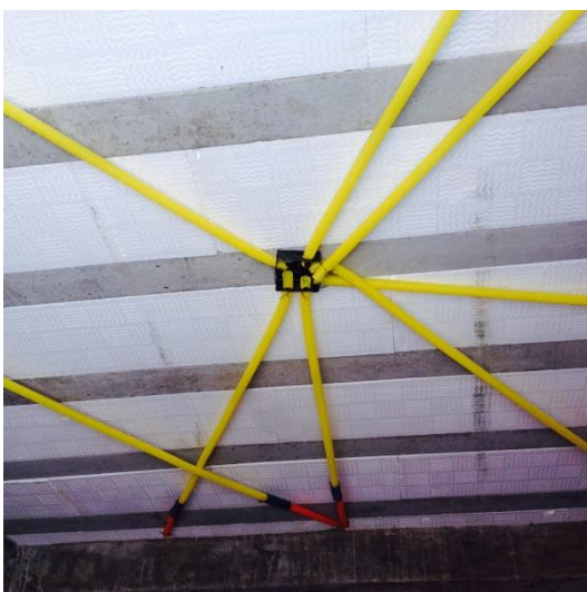
Figura 09 e 10 - Instalação de Eletrodutos
