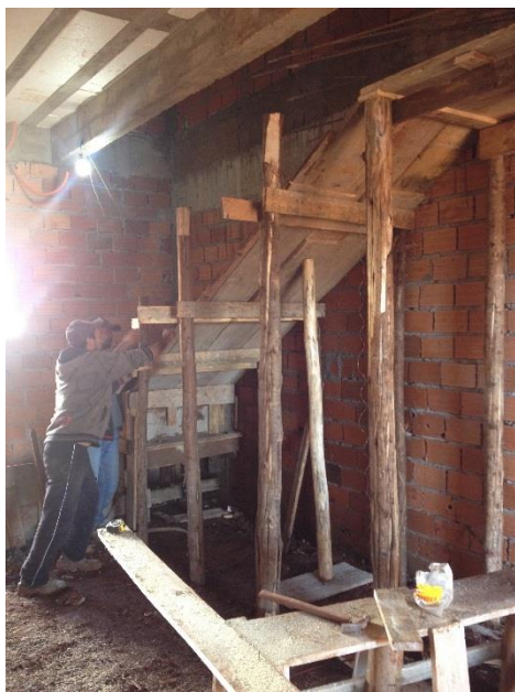
Figura 01 – Montagem da fôrma
