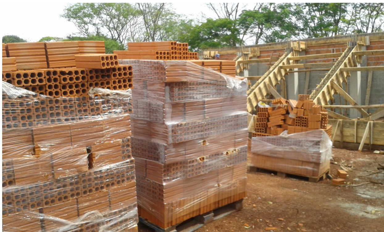
Figura 1 - disposição dos materiais no canteiro
