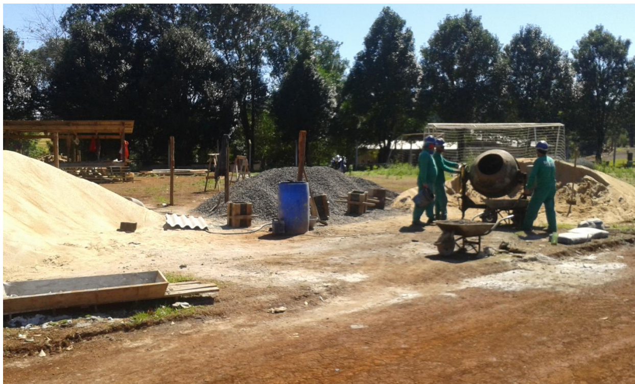
Figura 2 - organização do canteiro de obras
