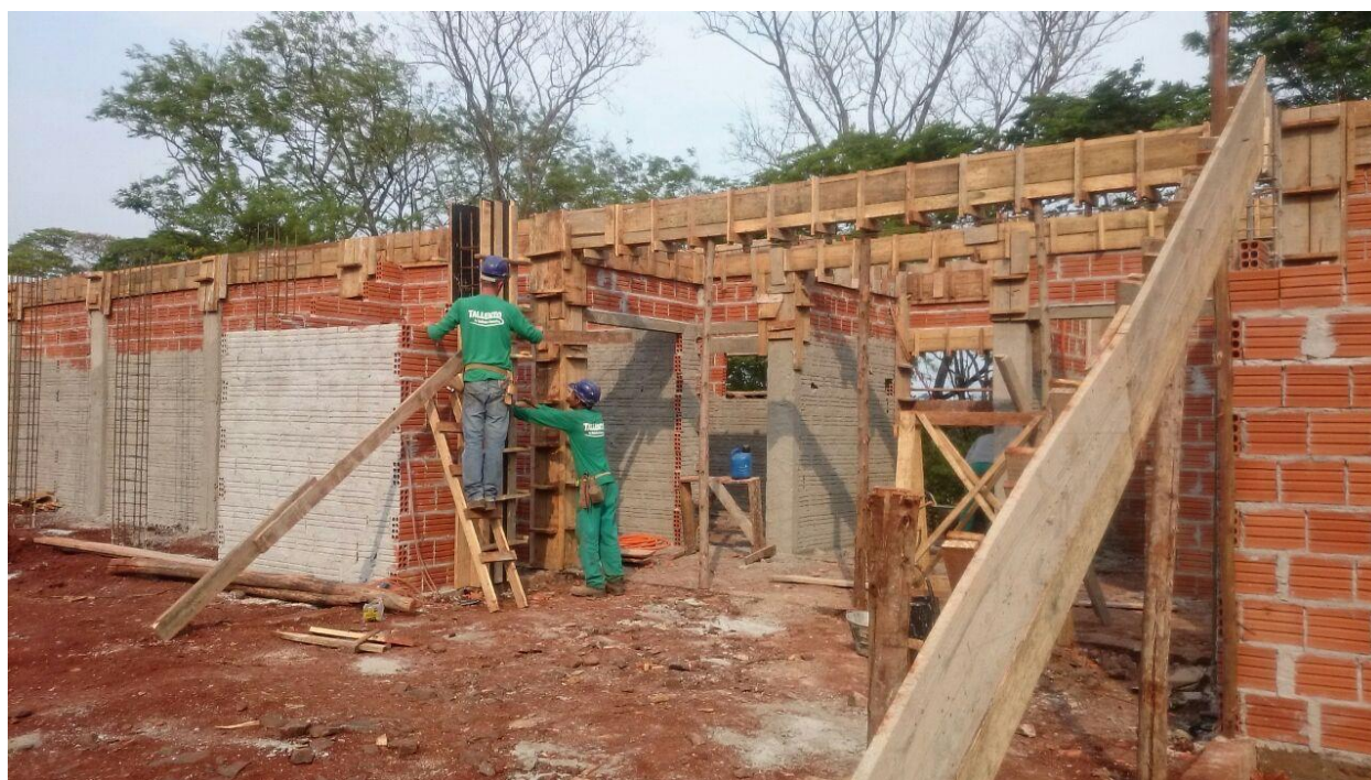
Figura 5 - formas utilizadas para a estrutura de concreto
