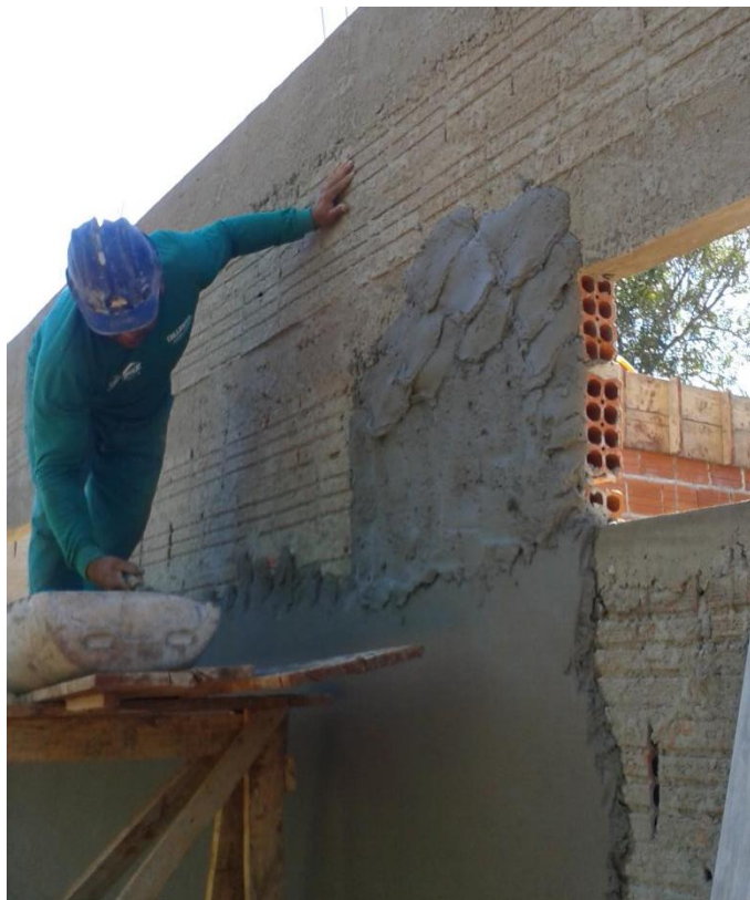
Figura 10 - reboco em parede de alvenaria
