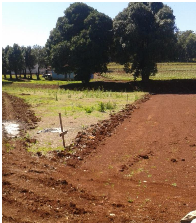
Figura 3 - estacas para a locação do campo
