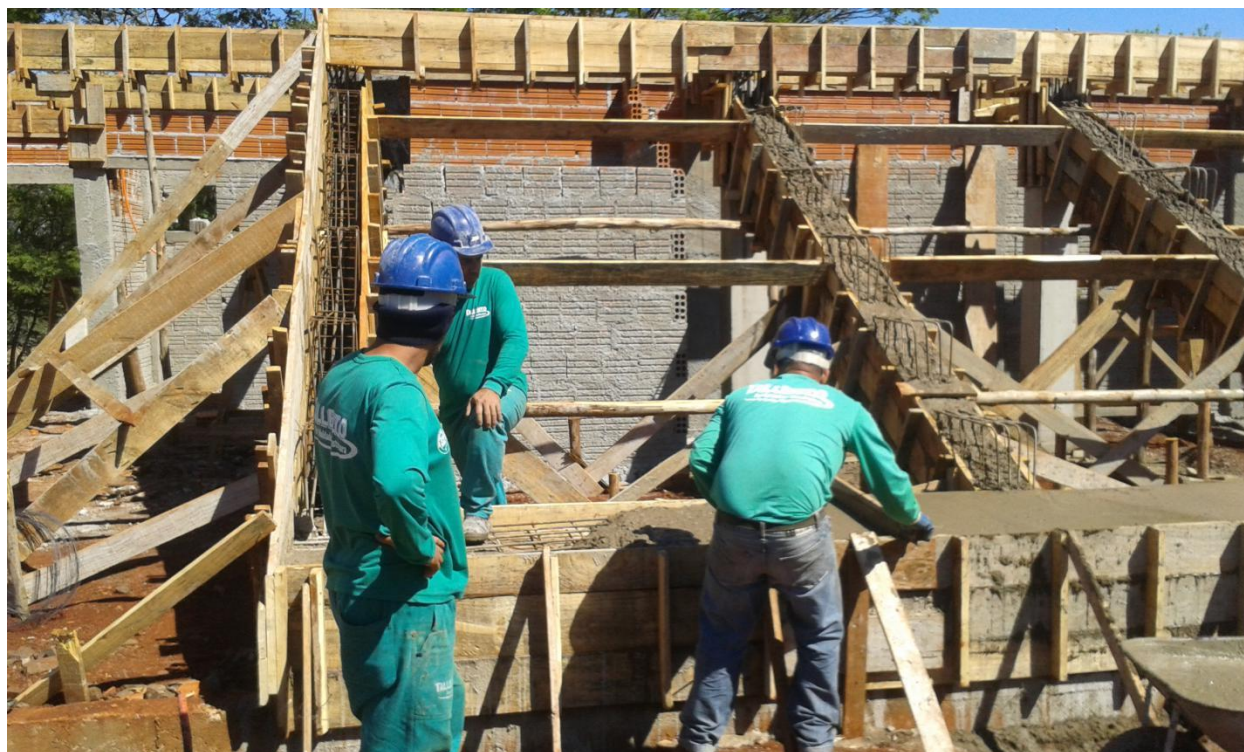
Figura 7 - alisamento do concreto para o piso do primeiro degrau
