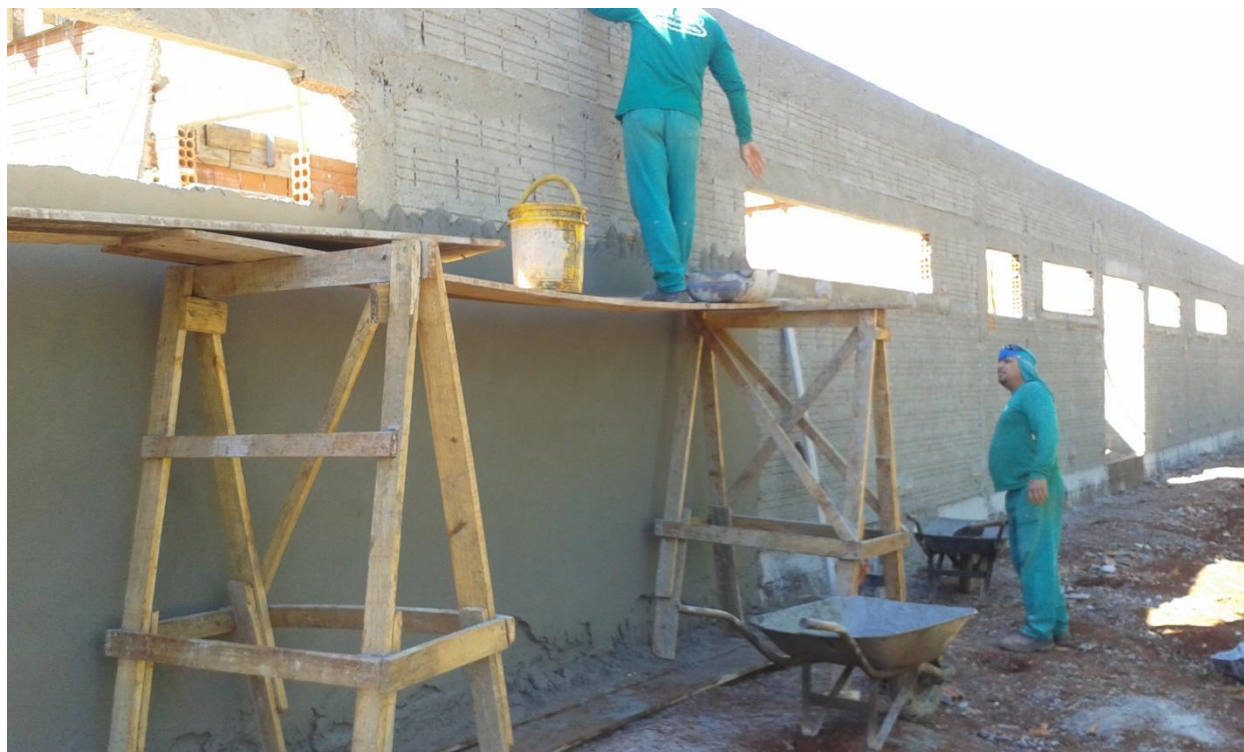
Figura 11 - reboco em parede de alvenaria
