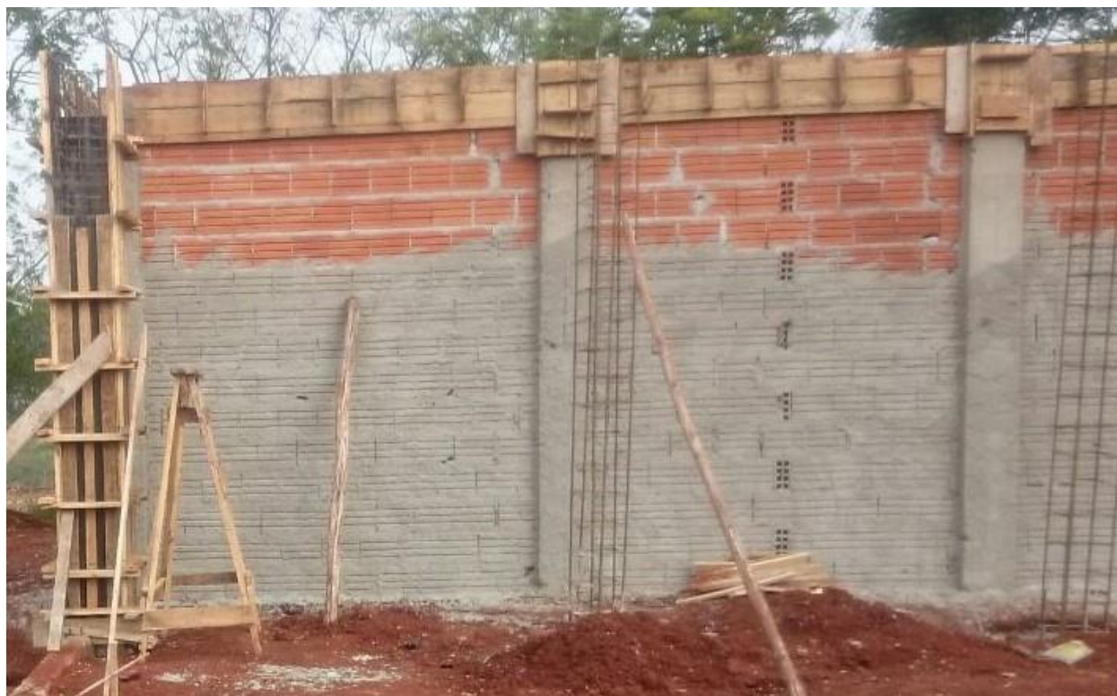
Figura 9 - parede chapiscada
