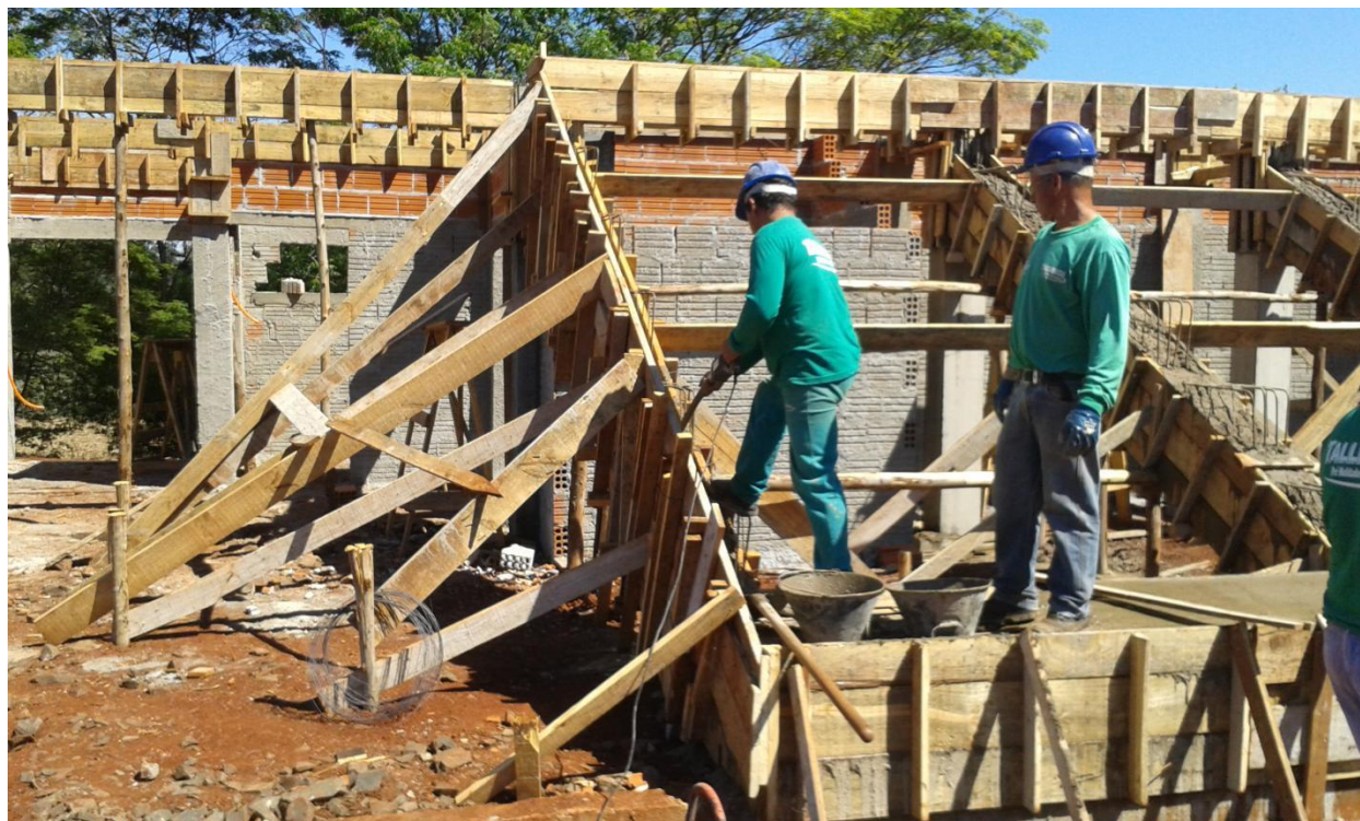
Figura 6 - adensamento do concreto
