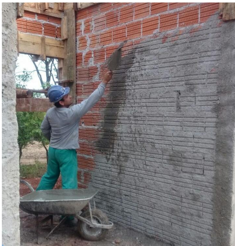
Figura 8 - chapisco em parede de alvenaria
