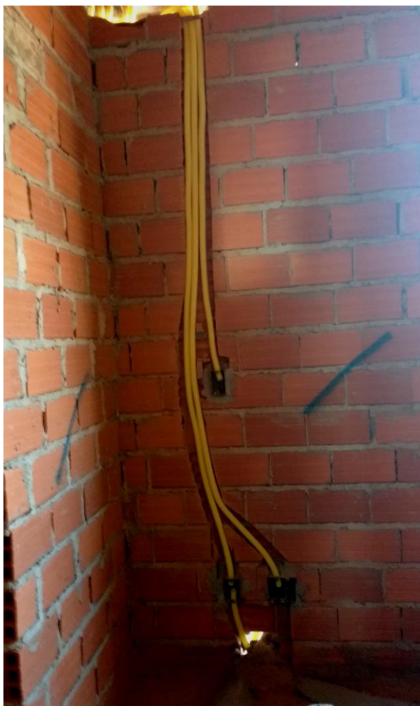
Figura 5 – Eletrodutos e marcações
