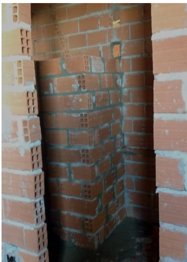
Figura 2 - Execução da alvenaria interna
