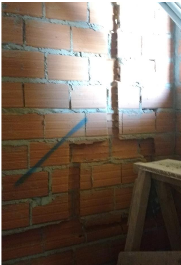
Figura 3 – Corte para colocação da tubulação hidráulica
