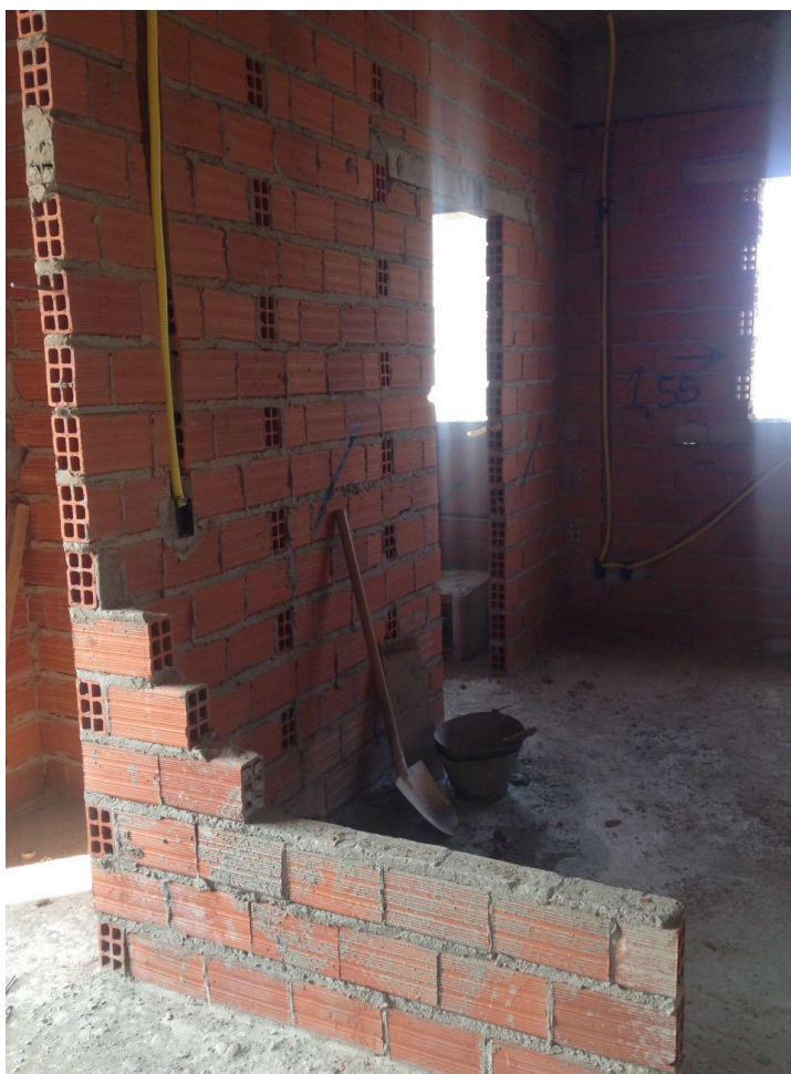
Figura 1 - Execução da alvenaria interna
