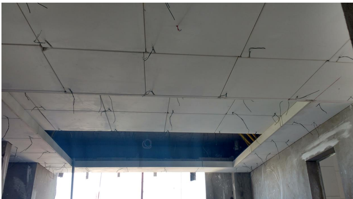
Figura 12 – Colocação placas de gesso
