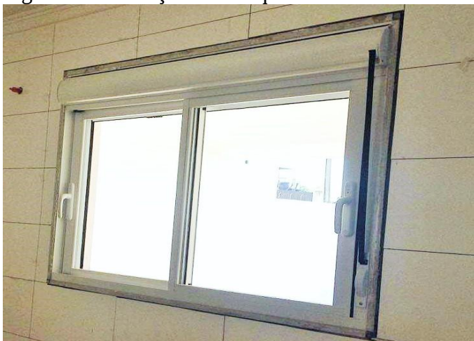
Figura 7 - Instalações das esquadrias de alumínio
