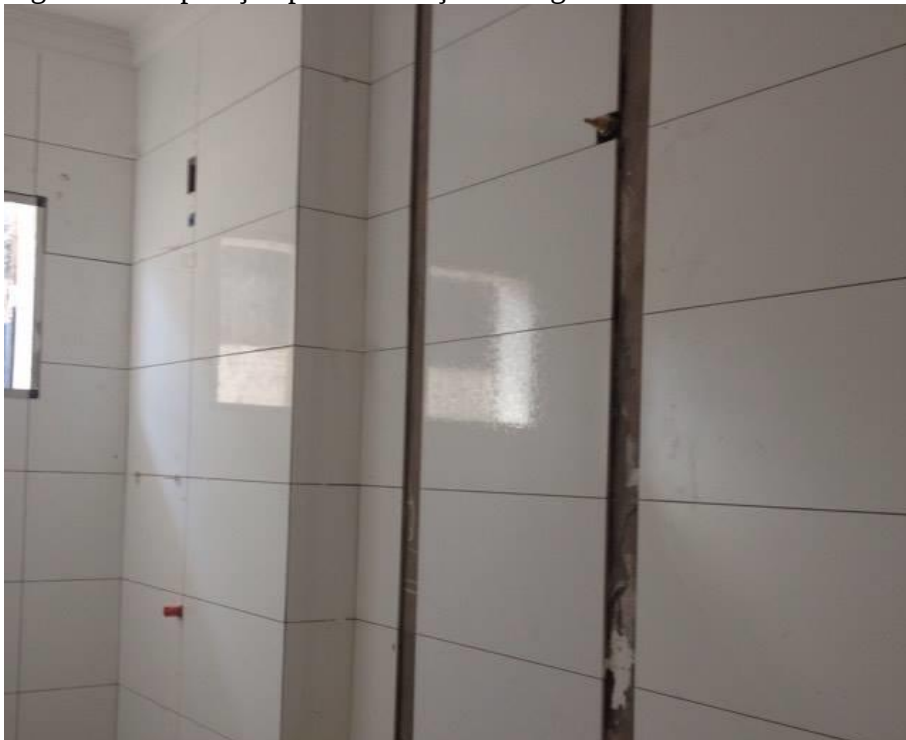
Figura 3 - Preparação para colocação de argamassa
