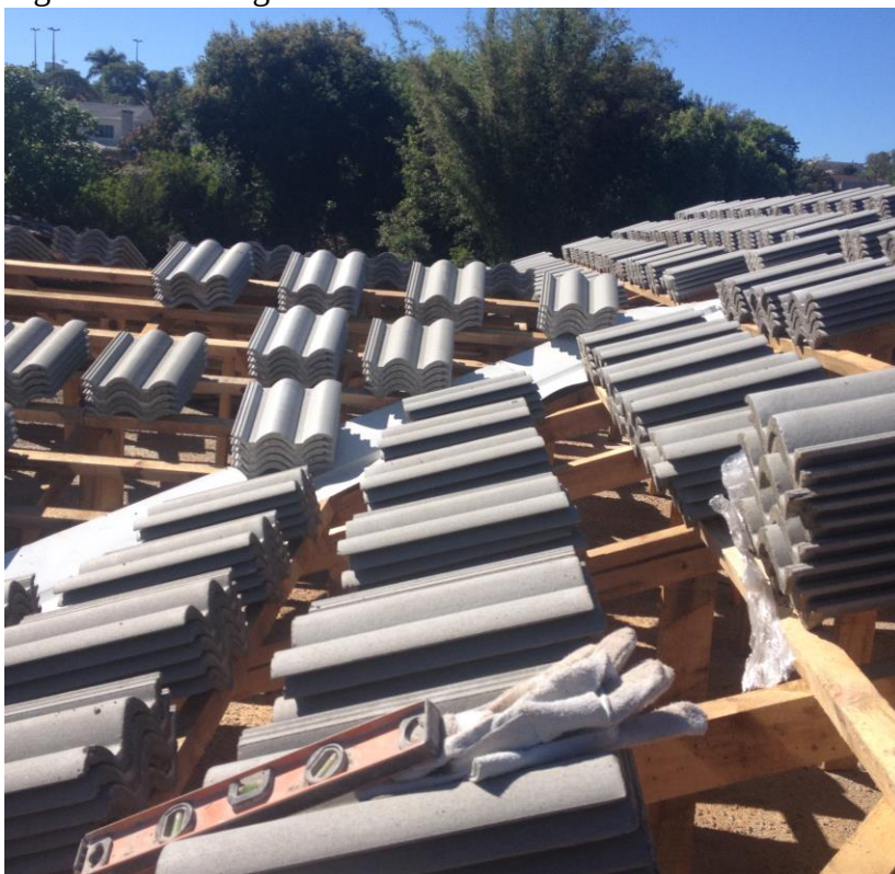
Figura 13 - Contagem e divisão das telhas de cimento
