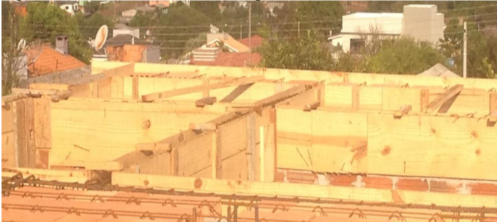
Figura 19 - Caixaria em torno das ferragens
