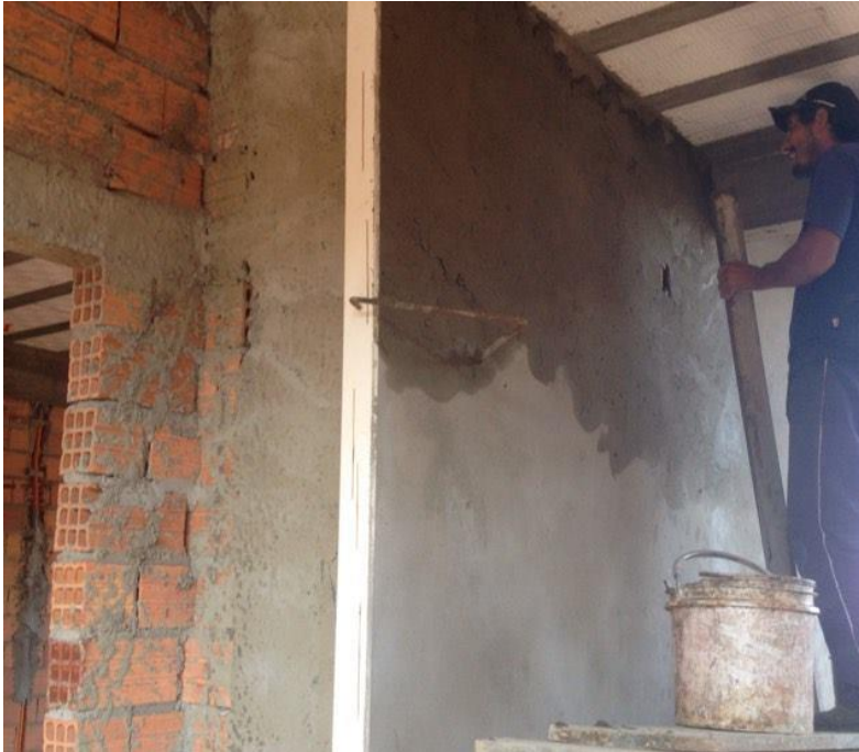
Figura 15 - Parede sarrafeada
