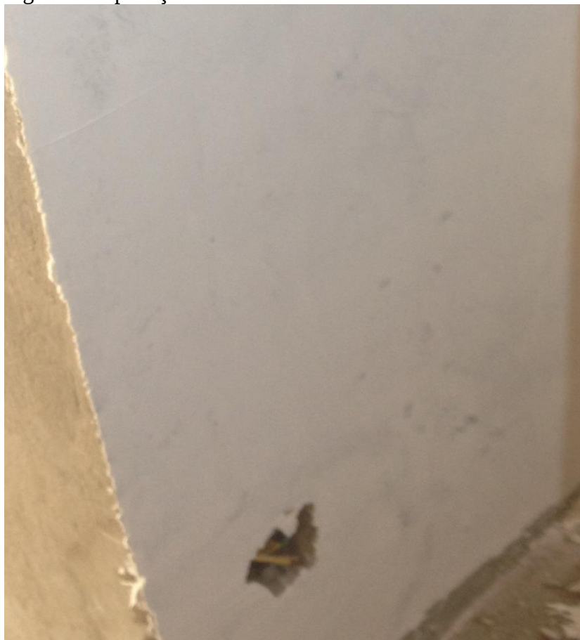
Figura 5 - Aplicação de massa corrida
