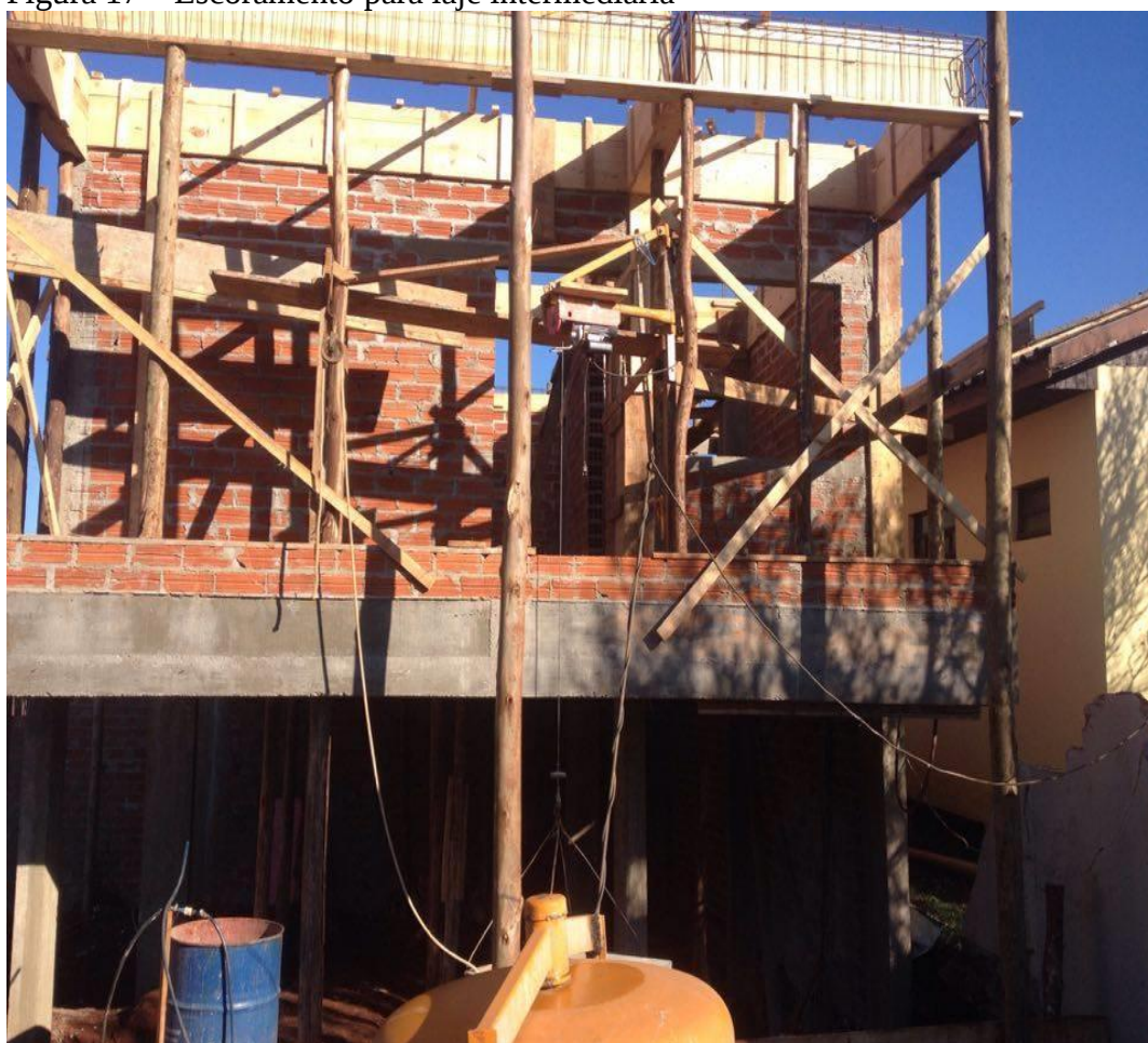
Figura 17 – Escoramento para laje intermediária
