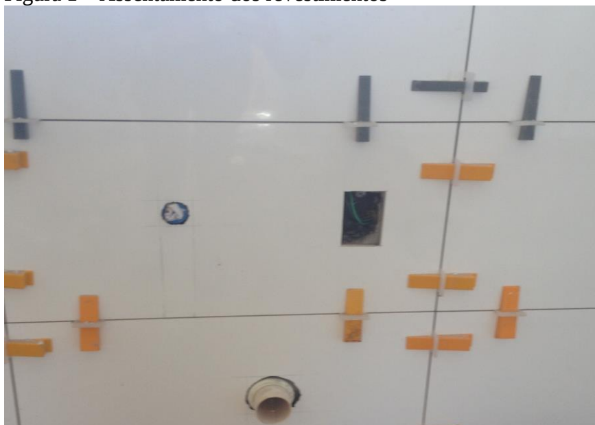
Figura 1 – Assentamento dos revestimentos
