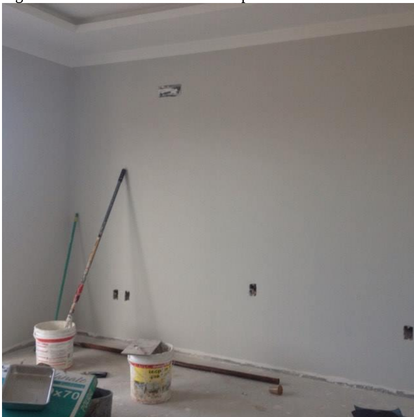
Figura 12 - Primeira demão de tinta aplicada
