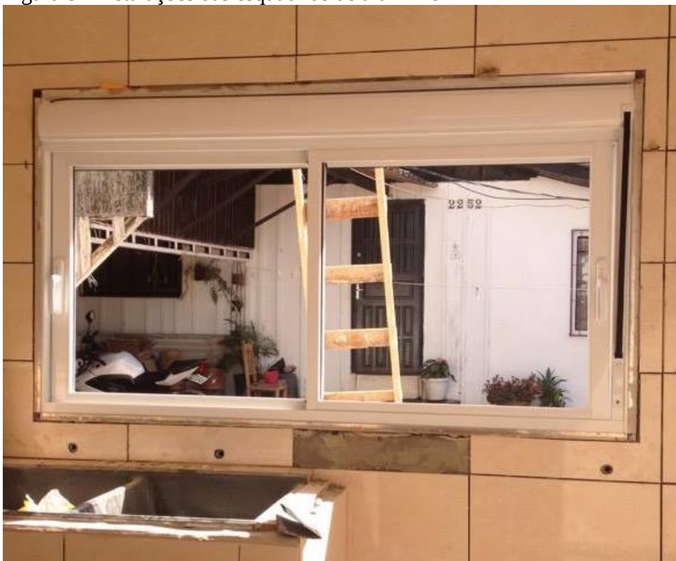
Figura 8 - Instalações das esquadrias de alumínio
