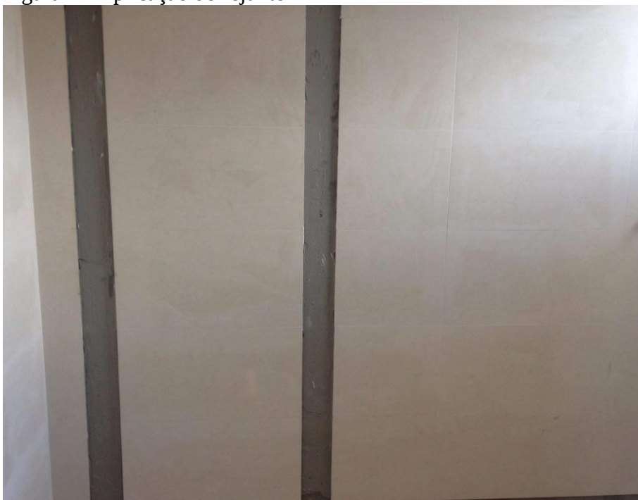
Figura 4 - Aplicação do rejunte
