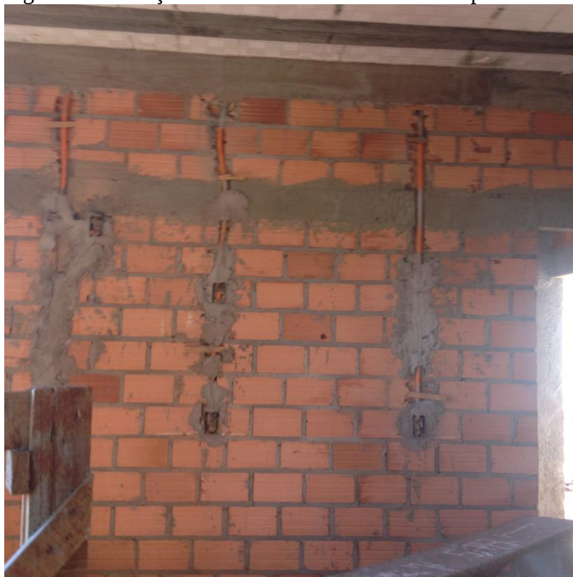
Figura 10 – Fixação com cimento dos conduites na parede
