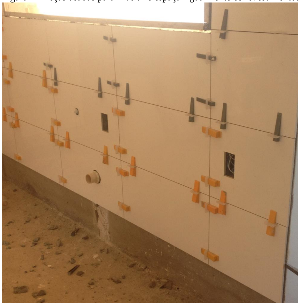
Figura 2 - Peças usadas para nivelar e espaçar igualmente os revestimentos
