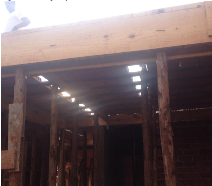
Figura 20 - Preparação da caixaria
