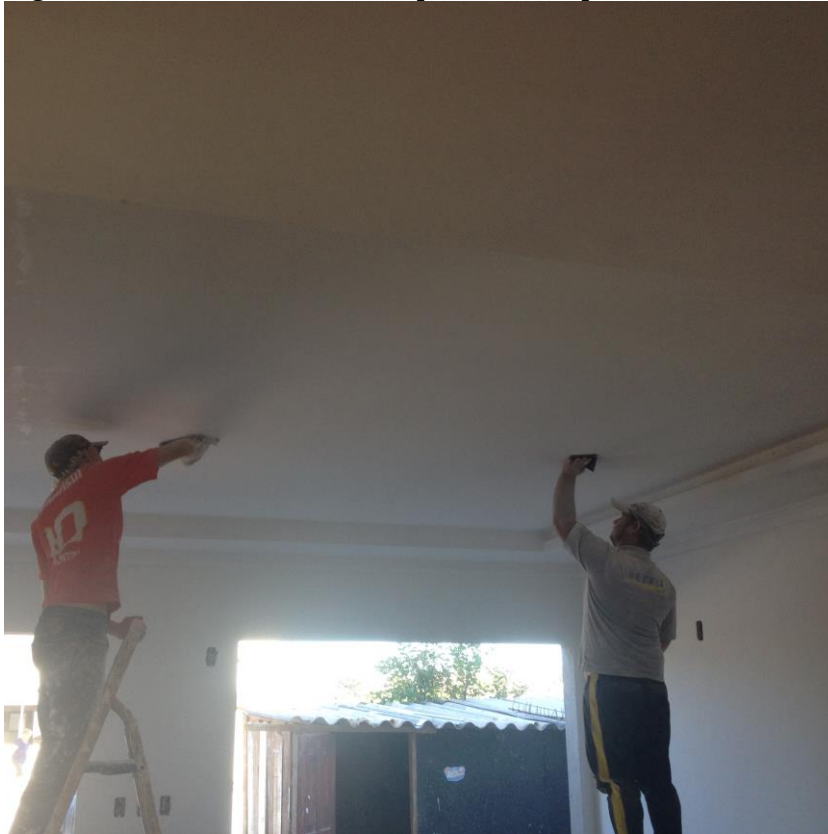
Figura 11 – Gesso sendo lixado para receber pintura
