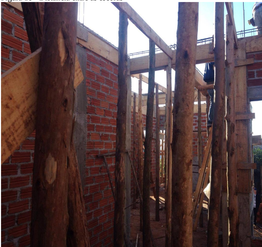
Figura 18 - Distância entre as escoras
