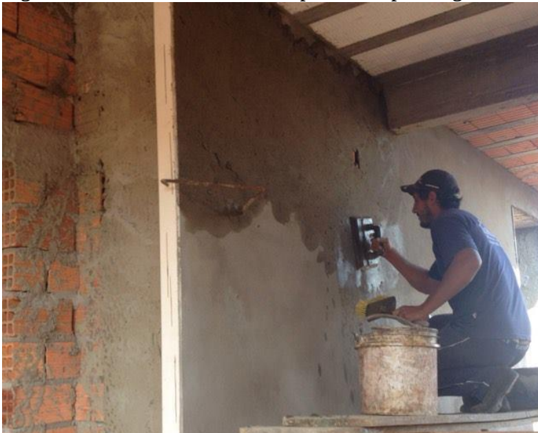
Figura 16 - Uso da broxa e desempenadeira para regularizar a parede
