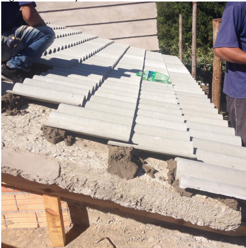
Figura 14 - Colocação das telhas cerâmicas
