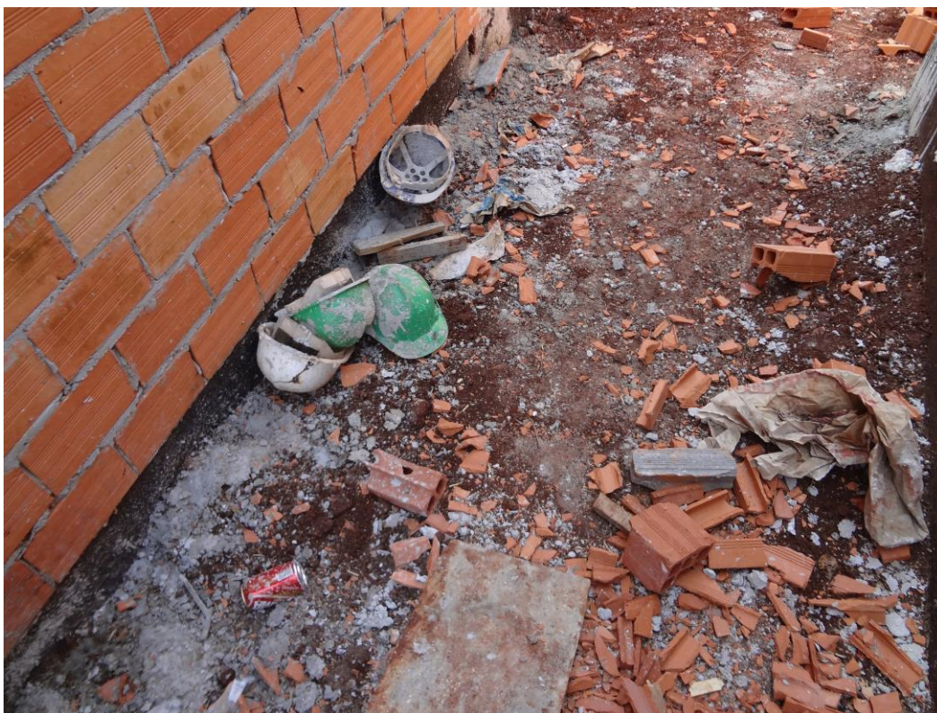
Imagem 7: Equipamentos de segurança – Obra 1
