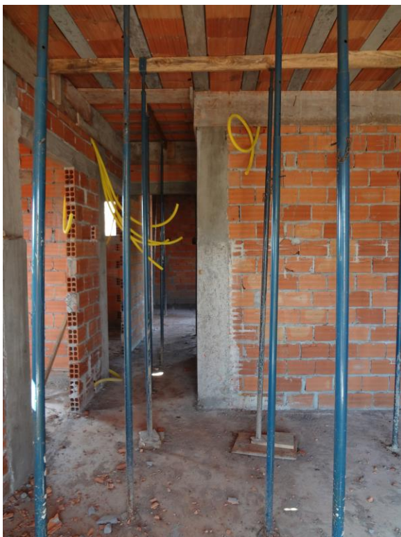
Imagem 9: Escoramento em piso – Obra 1
