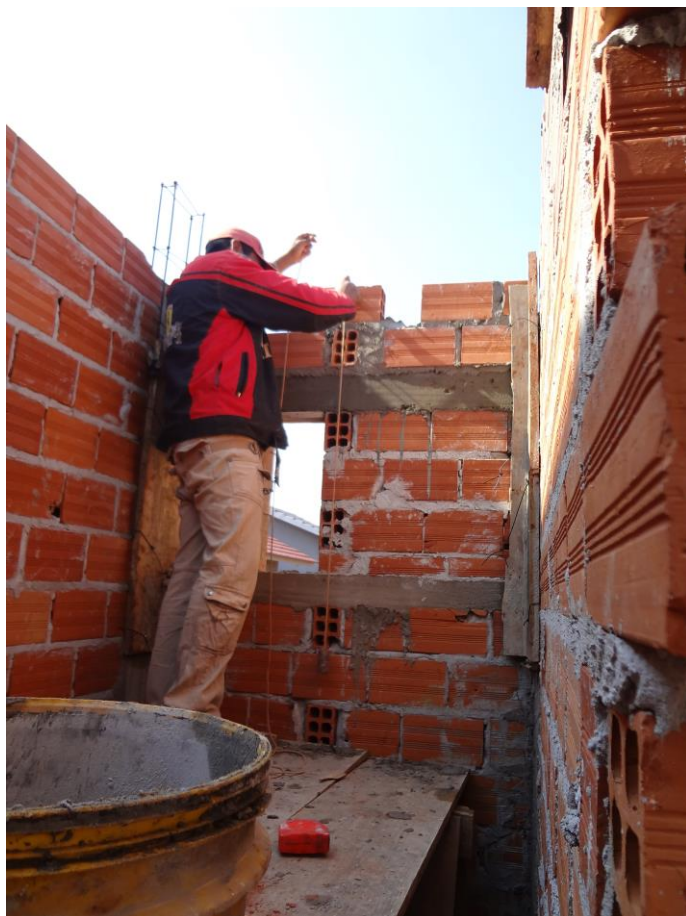
Imagem 8: Levantamento de parede – Obra 1
