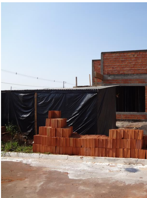
Imagem 1: Locação do depósito – Obra 1.
