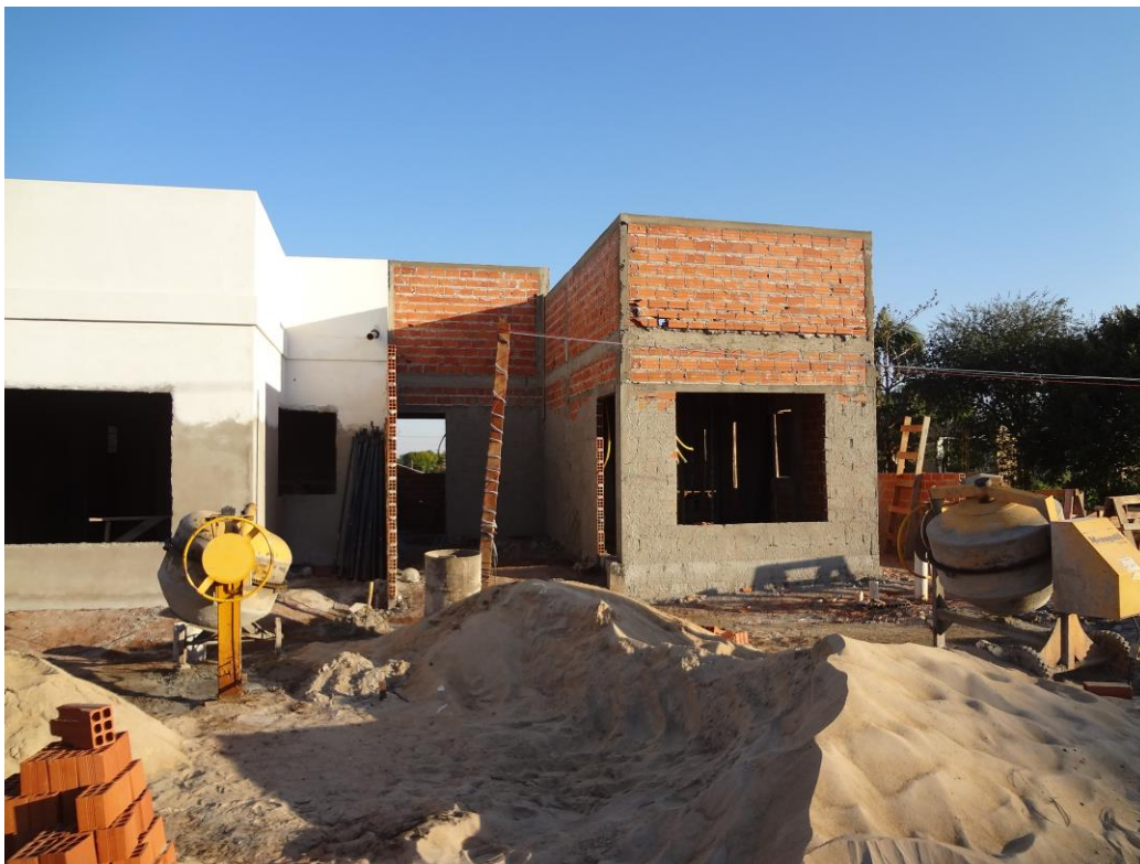
Imagem 20: Obra 1 no fim do estágio
