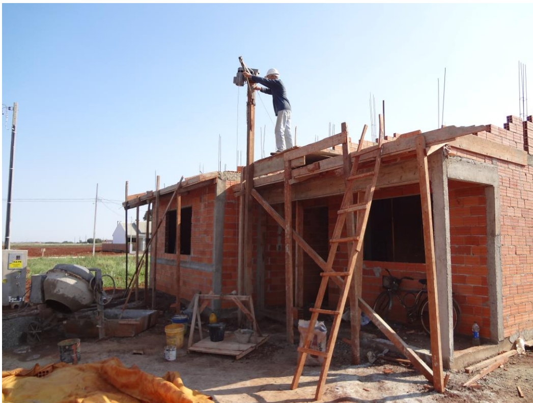
Imagem 5: Capacete como equipamento de segurança para serviço externo – Obra 2
