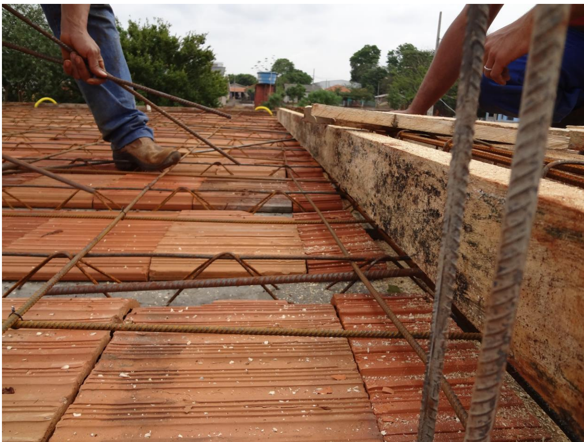
Imagem 11: Preparo para laje – Obra 1
