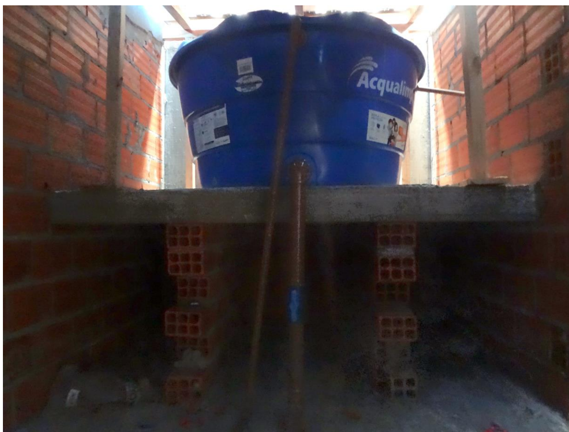
Imagem 14: Locação da caixa d'água – Obra 2
