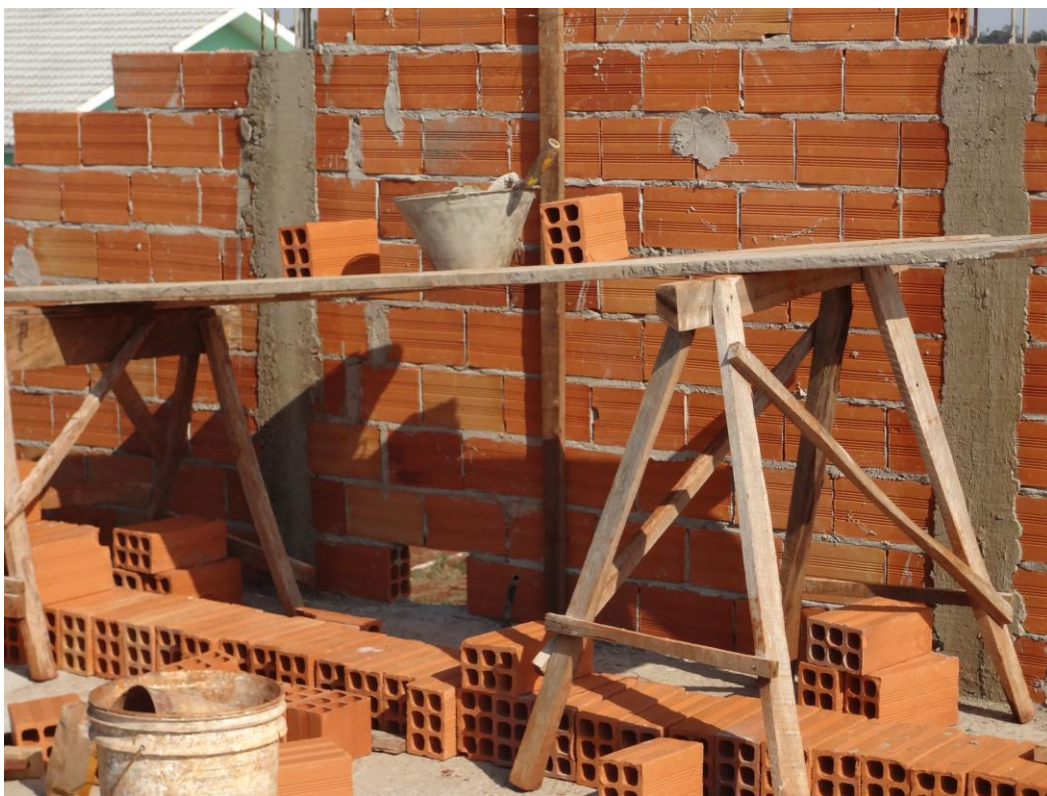
Imagem 6: Andaimos e proteções – Obra 2
