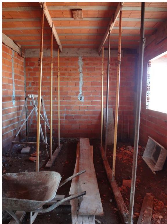
Imagem 10: Escoramento na terra – Obra 2
