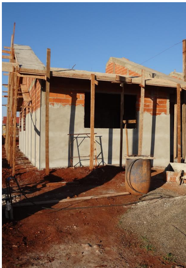
Imagem 16: Emboço aplicado sobre alvenaria – Obra 2
