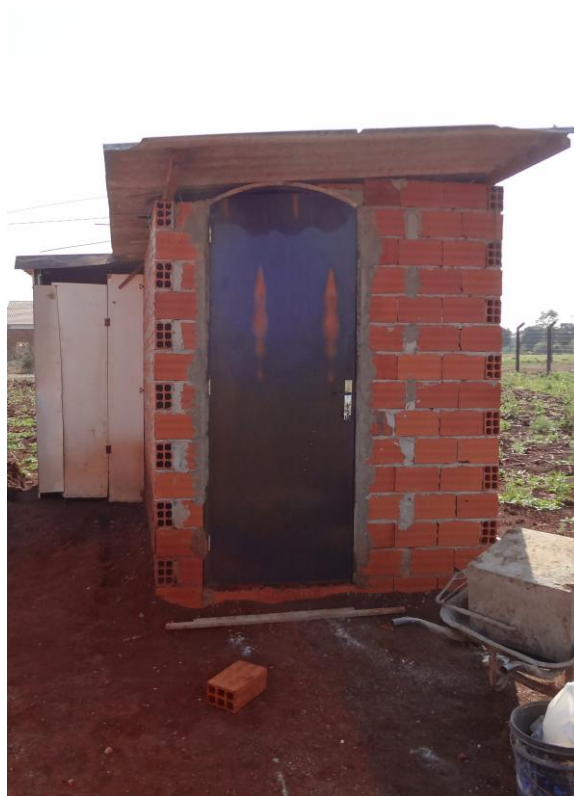
Imagem 2: Locação do depósito – Obra 2.
