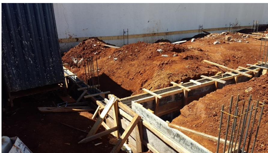
Figura 06 – Armadura e forma do baldrame
