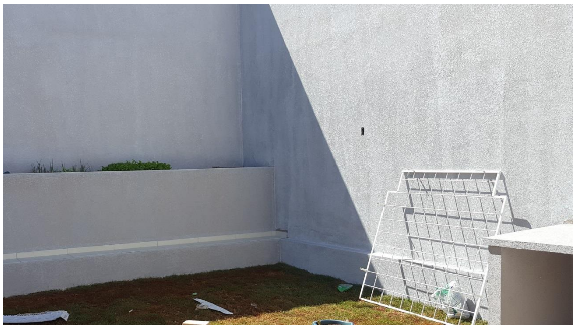
Figura 18 – Textura projetada nos muros
