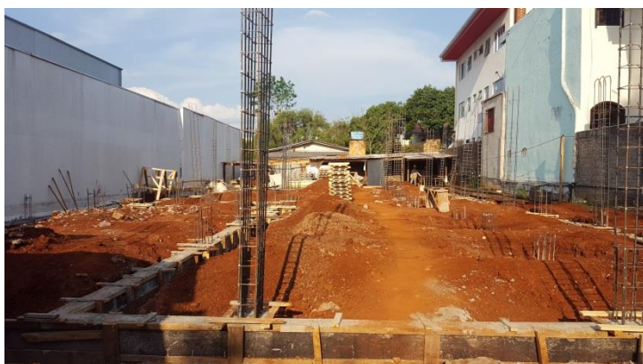
Figura 10 – Armadura dos pilares
