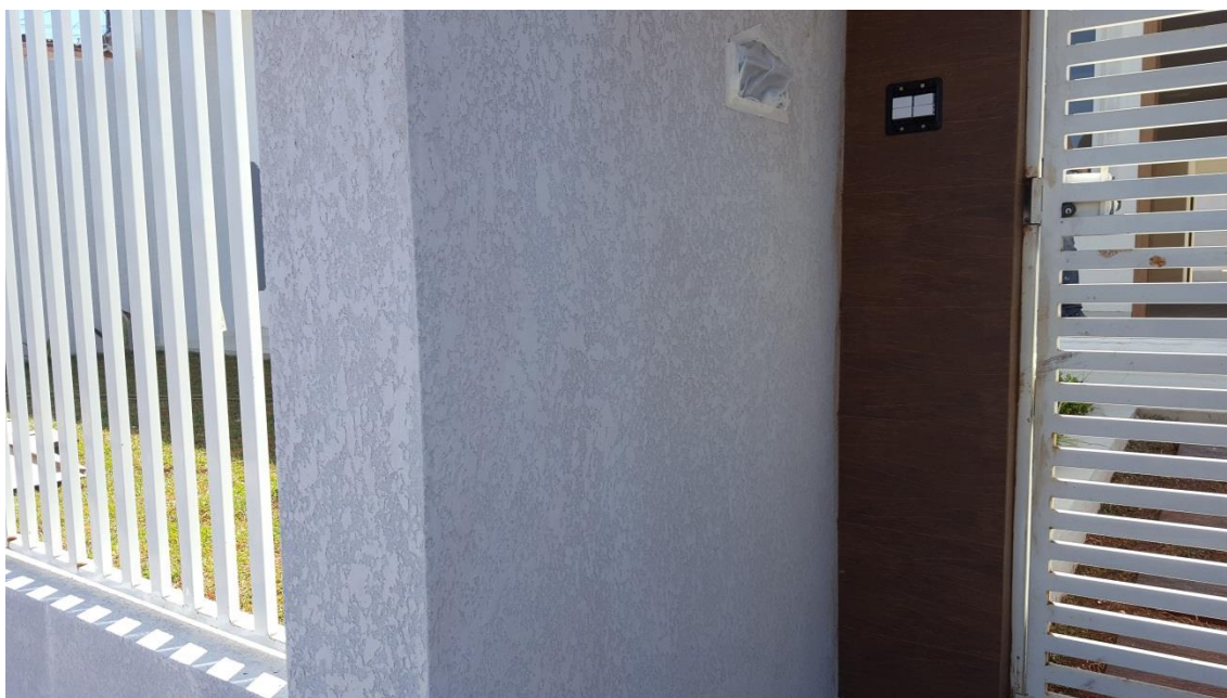
Figura 18 – Textura projetada na fachada
