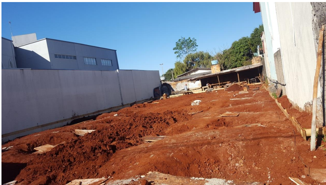
Figura 02 – Escavação da fundação
