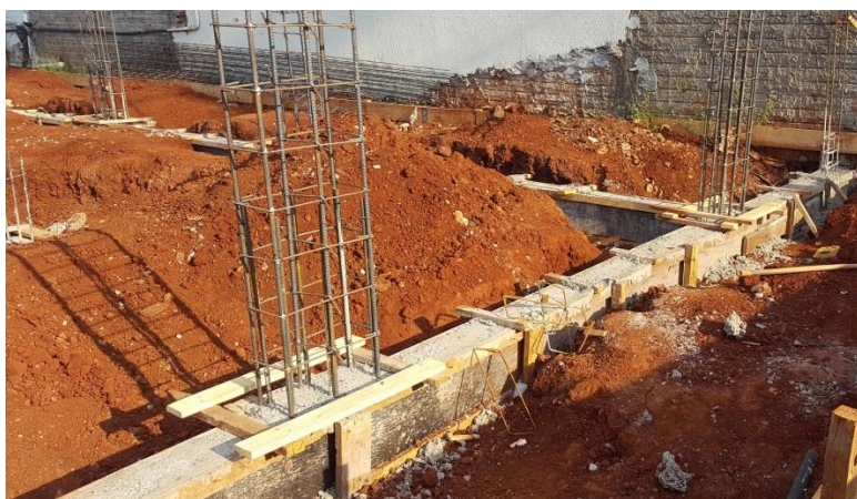
Figura 11 – Armadura dos pilares
