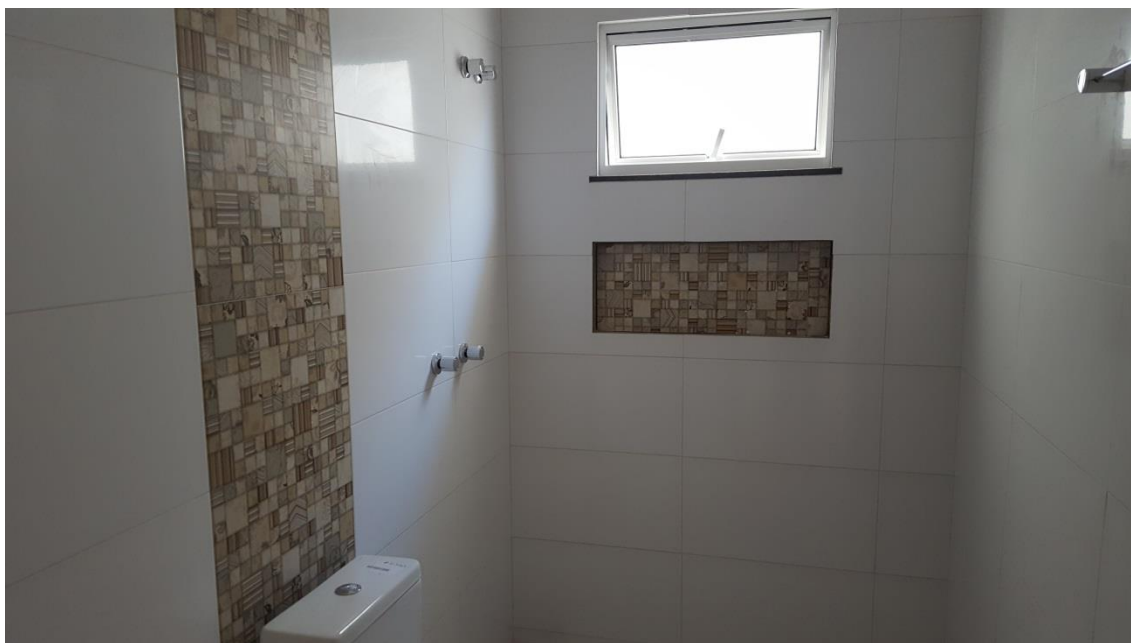
Figura 12 – Revestimento banheiro social
