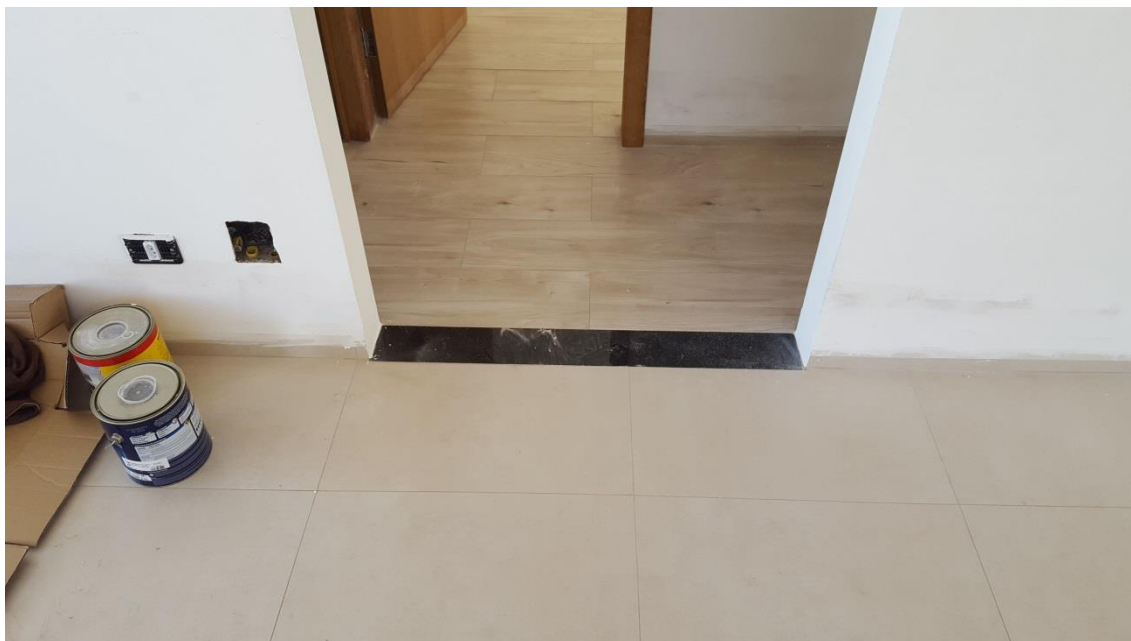
Figura 16 – Acabamentos com massa corrida e selador
