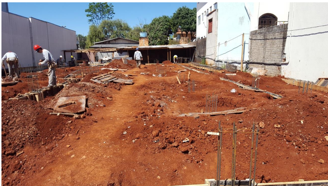
Figura 04 – Armadura da fundação
