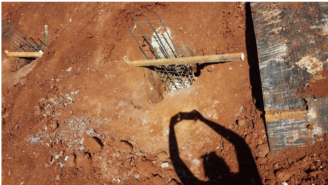
Figura 03 – Armadura da fundação
