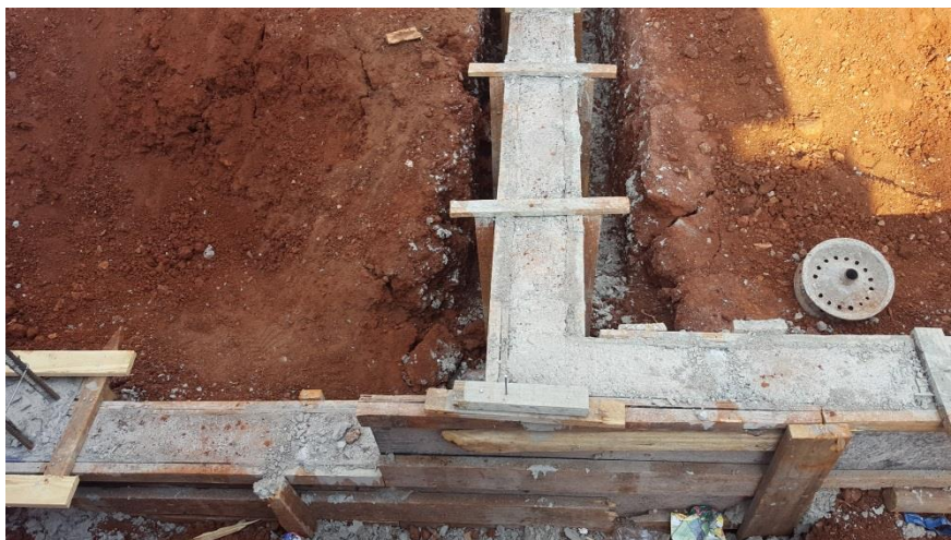
Figura 09 – Concretagem
