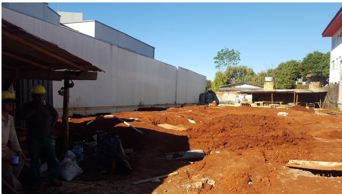
Figura 01 – Escavação da fundação
