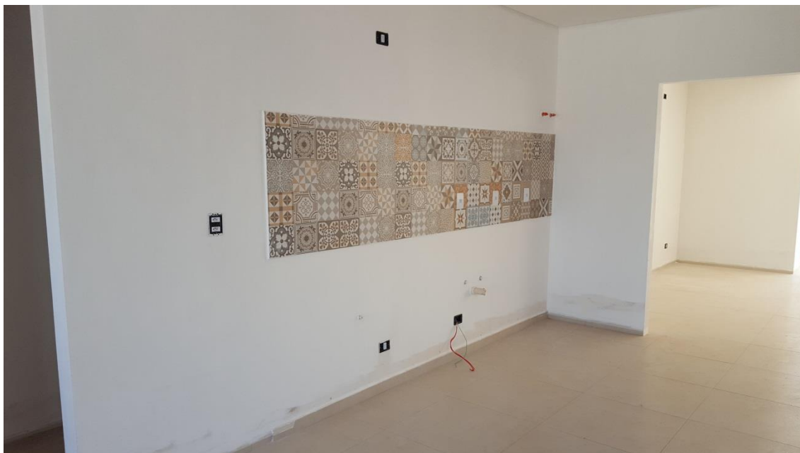
Figura 15 – Revestimento área de festas
