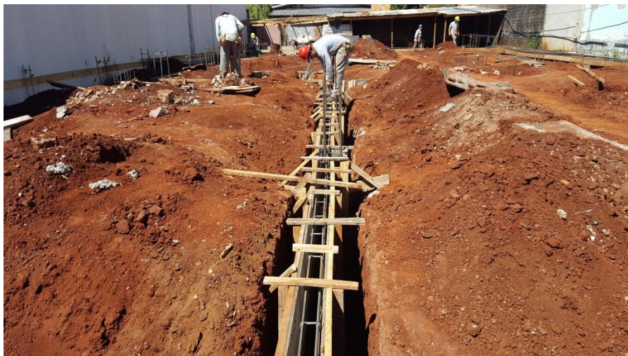
Figura 05 – Armadura e forma do baldrame
