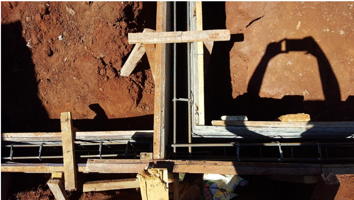
Figura 07 – Armadura e forma do baldrame
