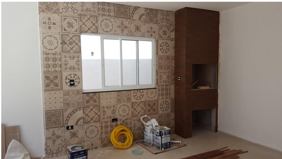
Figura 14 – Revestimento área de festas
