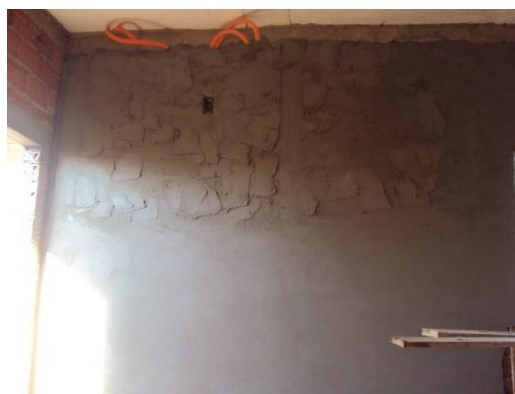
Figura 06: acabamento do reboco
