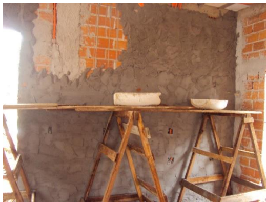
Figura 05: reboco de alvenaria
