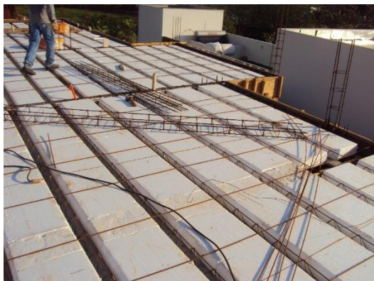
Figura 07: Preparação da laje
