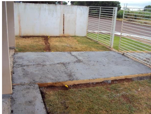
Figura 13: concretagem finalizada
