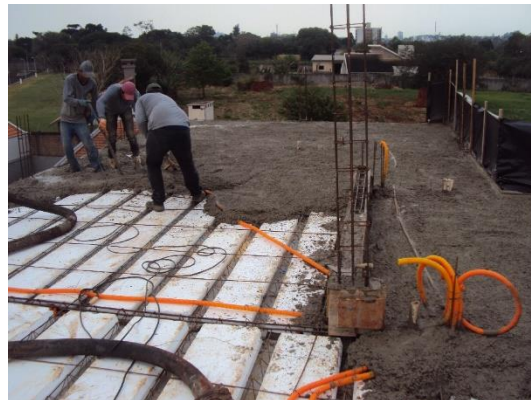
Figura 07: Preparação da laje
