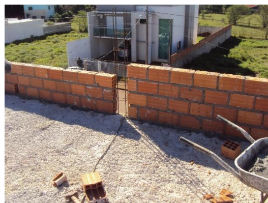
Figura 04: levantamento de paredes
