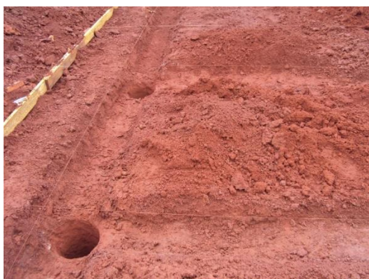
Figura 01: escavação das estacas
