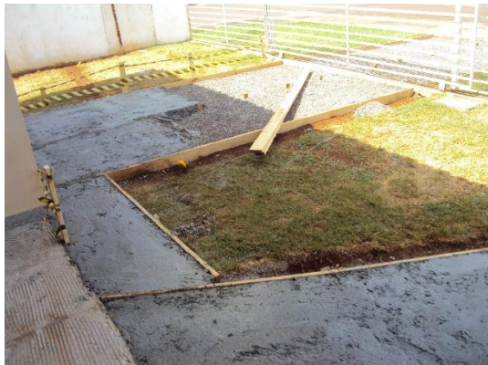
Figura 13: concretagem de contra piso
