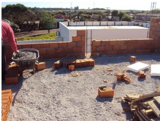
Figura 03: parede de alvenaria
