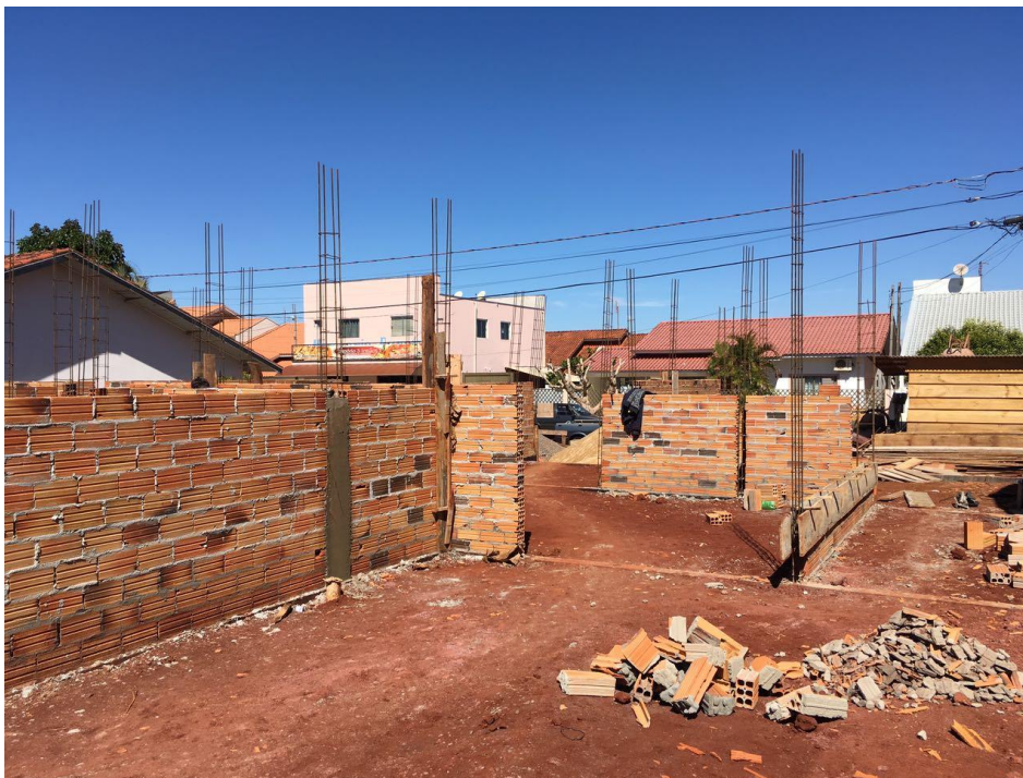
Figura 02 – Execução alvenaria 2ª semana
