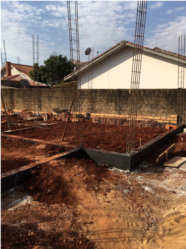
Figura 01 – Execução alvenaria 1º semana
