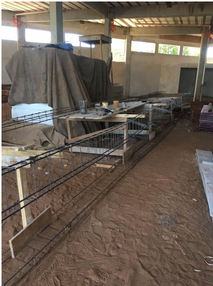
Figura 04 – demonstração amarração ferragem
