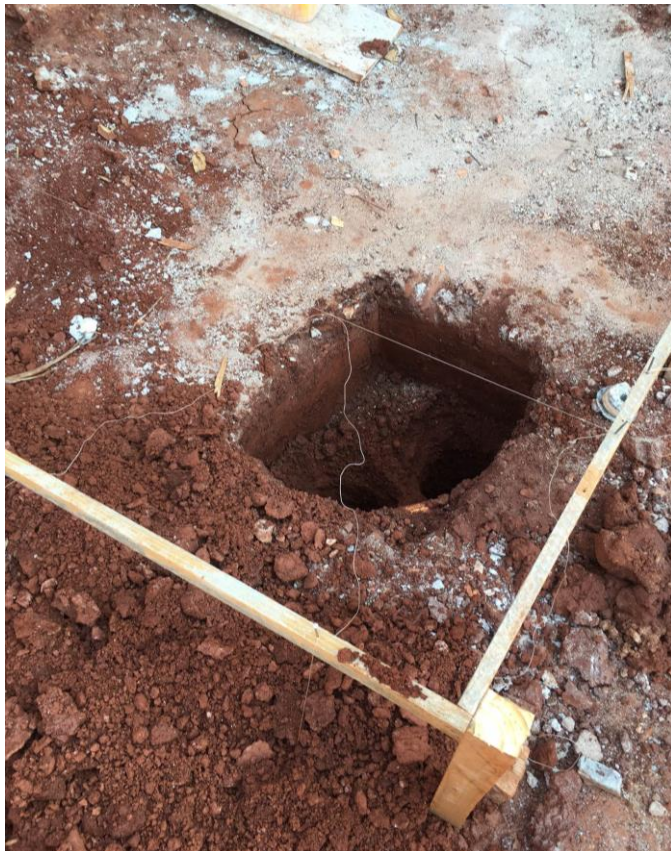
Figura 06 – Reforma ampliação - fundação
