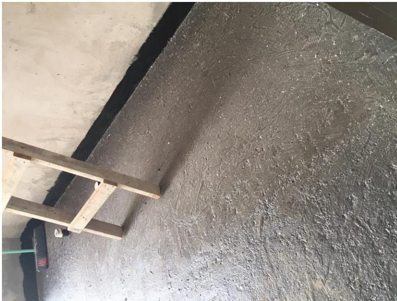
Figura 12 – Utilização do isopor misturado no contra piso
