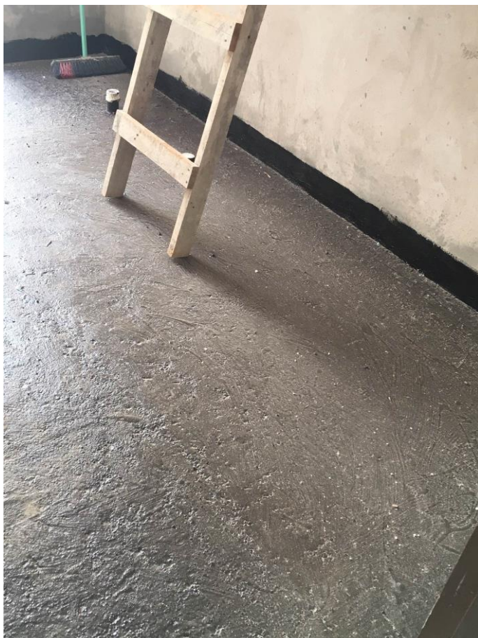
Figura 09 – Utilização Vedapren nas paredes
