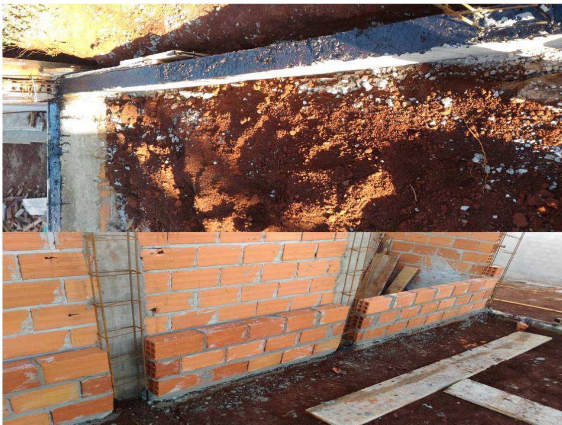
Figura 5. Levantamento das paredes
