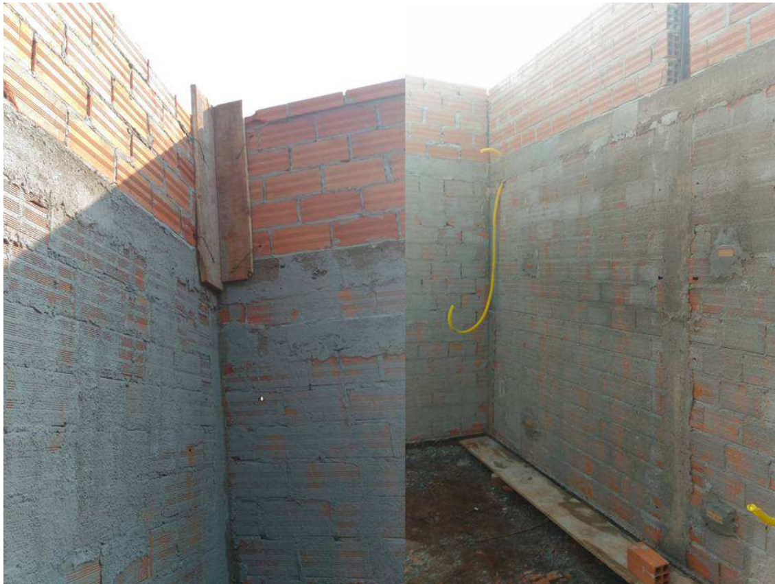
Figura 7. Chapisco das paredes
