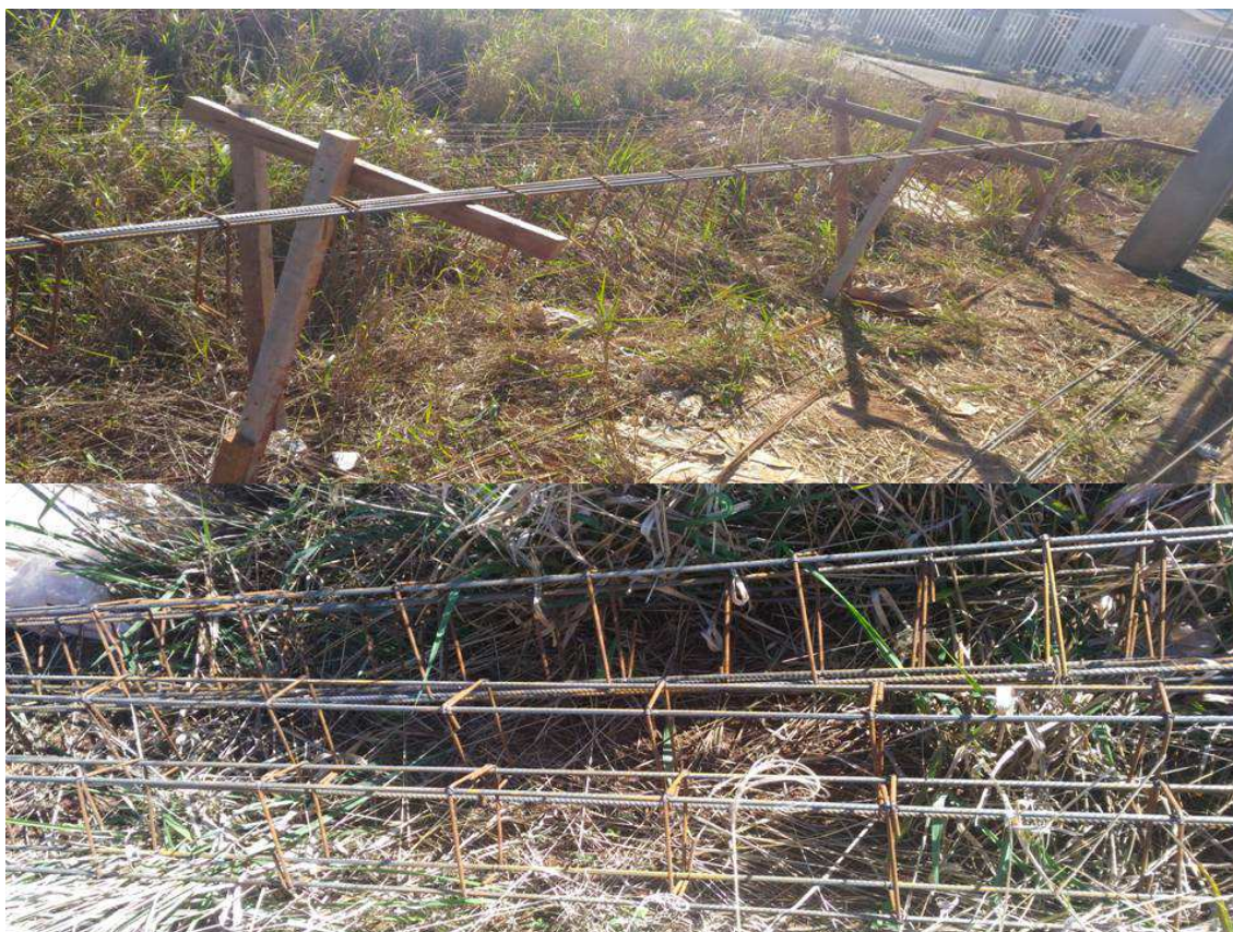
Figura 2. Ferragem do baldrame
