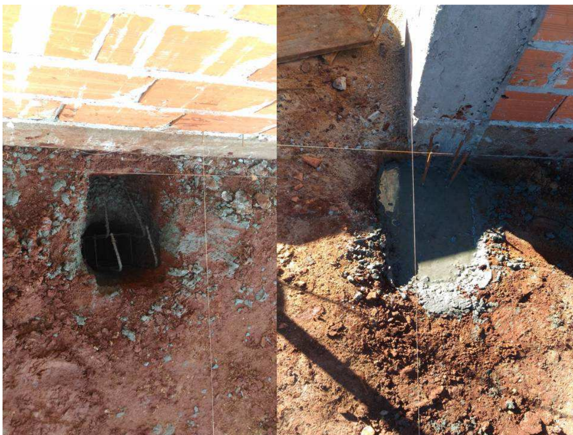
Figura 1. Perfurações e concretagem das estacas
