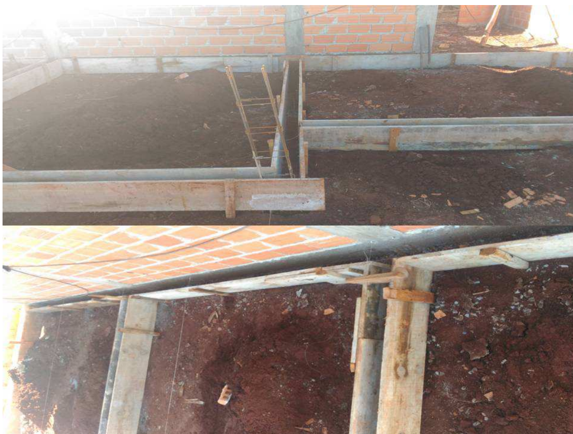
Figura 3. Preparação das caixarias
