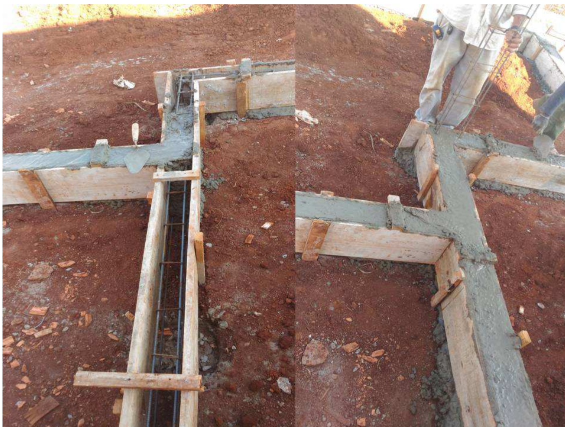
Figura 4. Concretagem da viga baldrame
