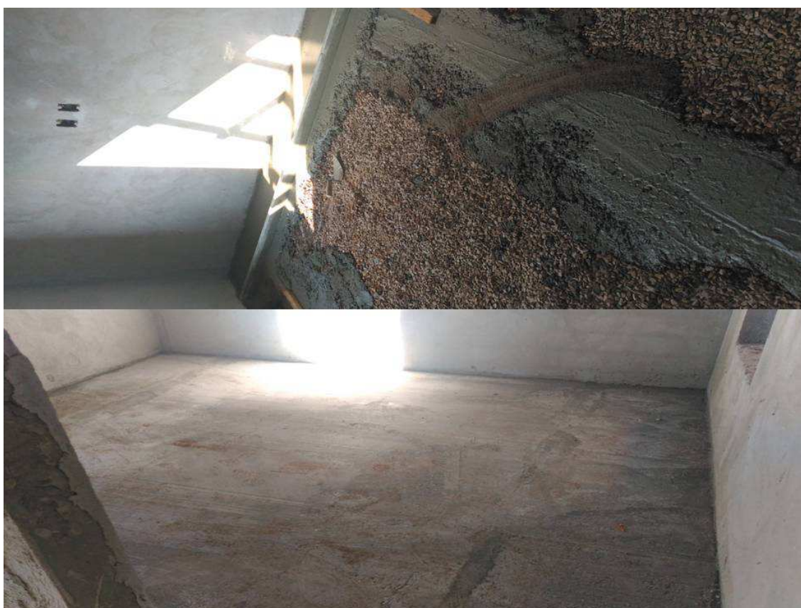
Figura 6. Concretagem do piso
