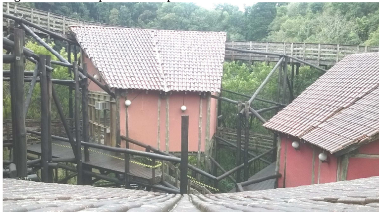
Figura 7 - Vista a partir da rampa
