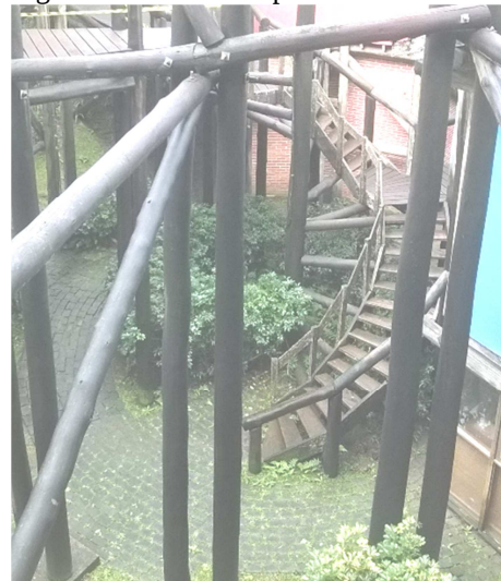
Figura 5 – Estrutura e pátio
