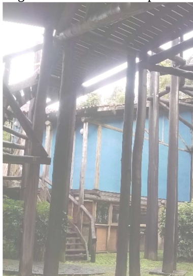
Figura 6 - Vista sob a rampa
