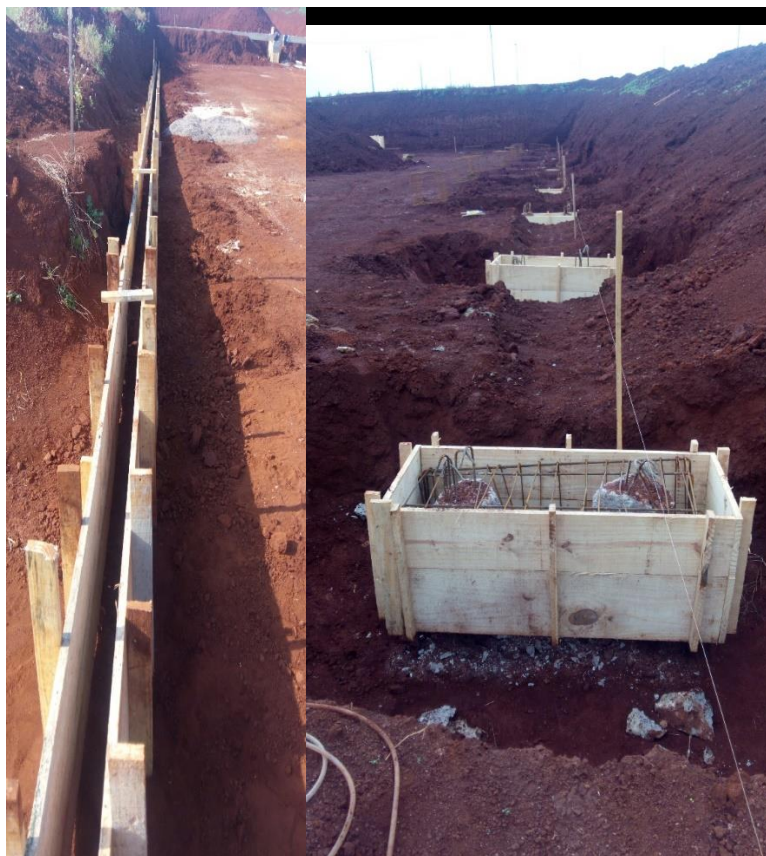
Figura 06-Montagem de Formas dos Blocos
