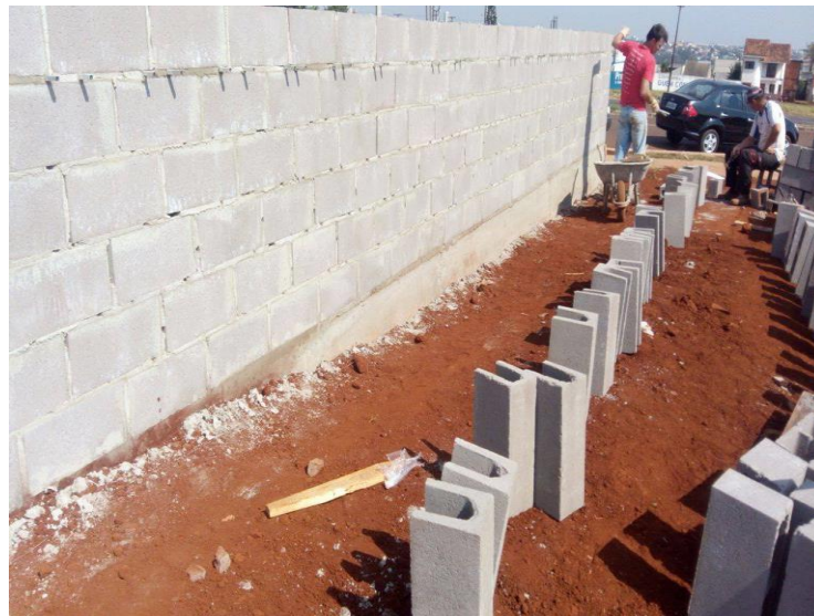
Figura 13- Muro de Blocos de Concreto
