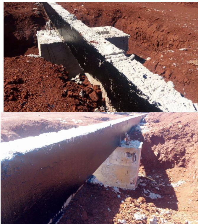
Figura 11-Impermeabilização viga baldrame
