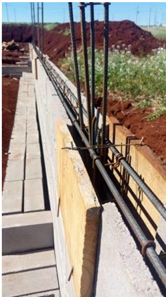
Figura 08-Coluanas de ferro para o Bloco canaleta
