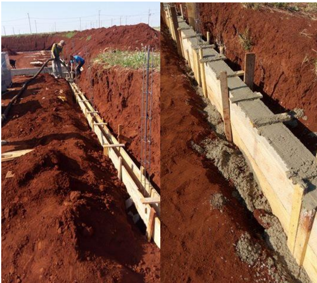
Figura 09-Concretagem Blocos e Baldrame
