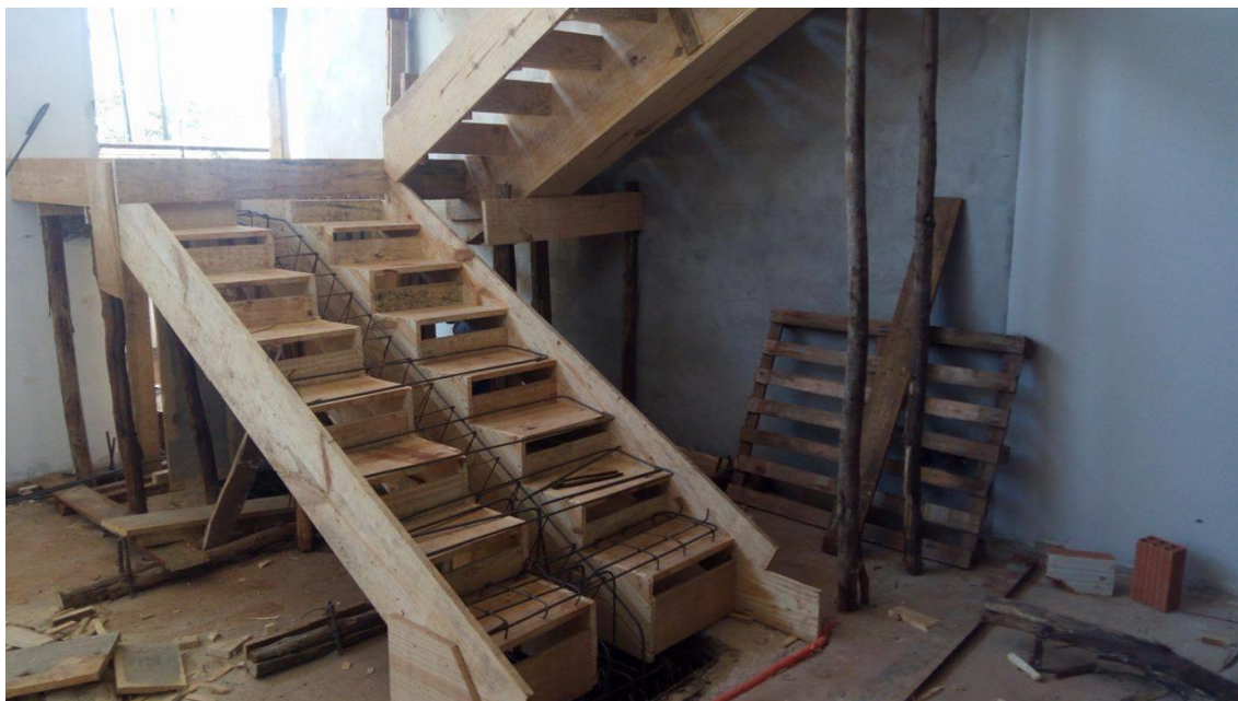
Figura 02-Armação de Ferragens da Escada
