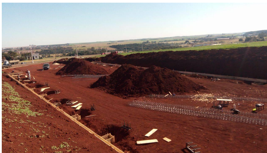
Figura 05-Locação de Obra e montagem de Formas da viga baldrame
