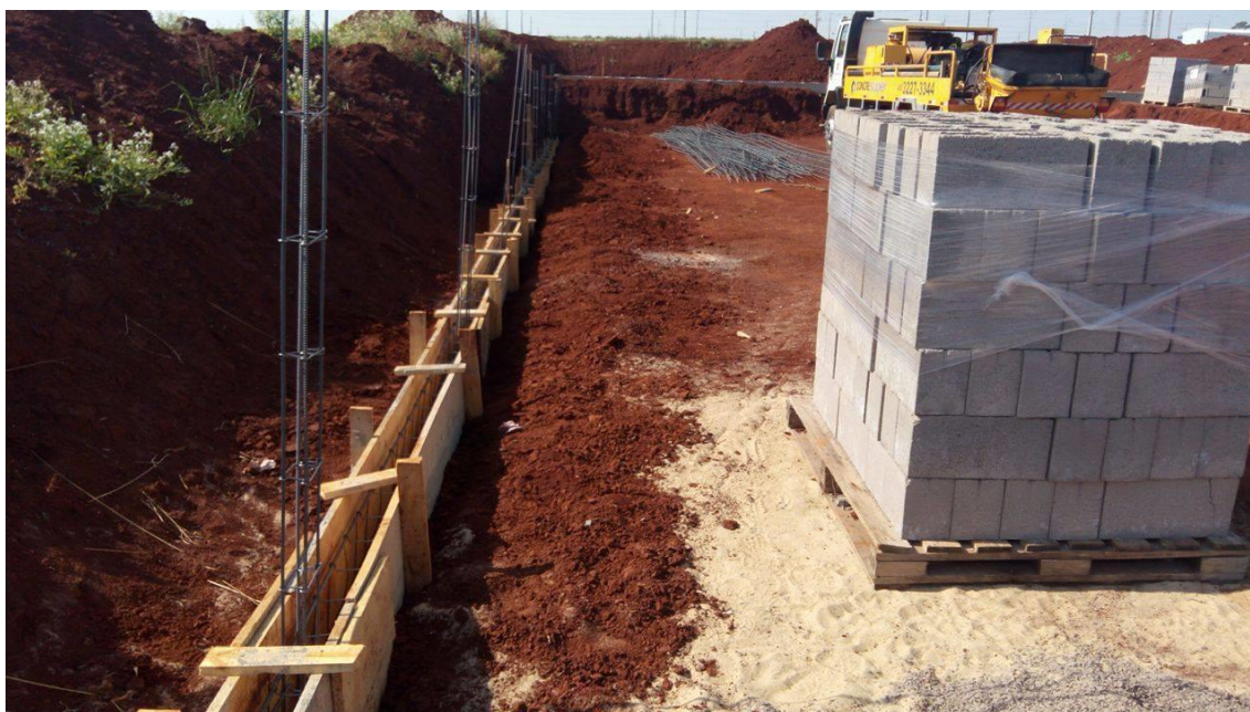
Figura 07-Montagem de Ferragens (colunas prontas)
