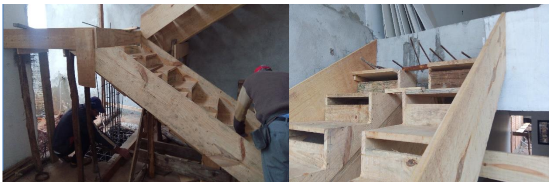
Figura 01-Montagem de Formas Escada
