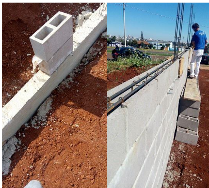
Figura 12-Assentamento de Blocos de Vedação
