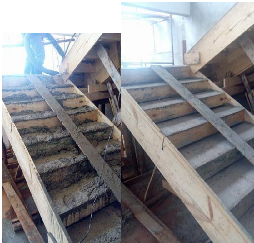
Figura 03-Concretagem Escada
