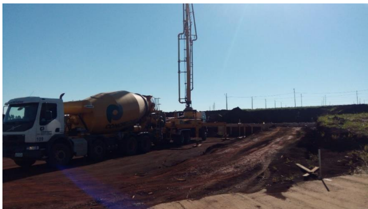
Figura 10-Concretagem com caminhão lança
