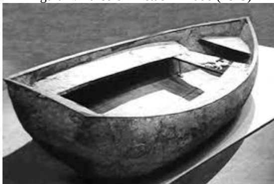
Figura 7: Barco em Betão Armado (1849)
