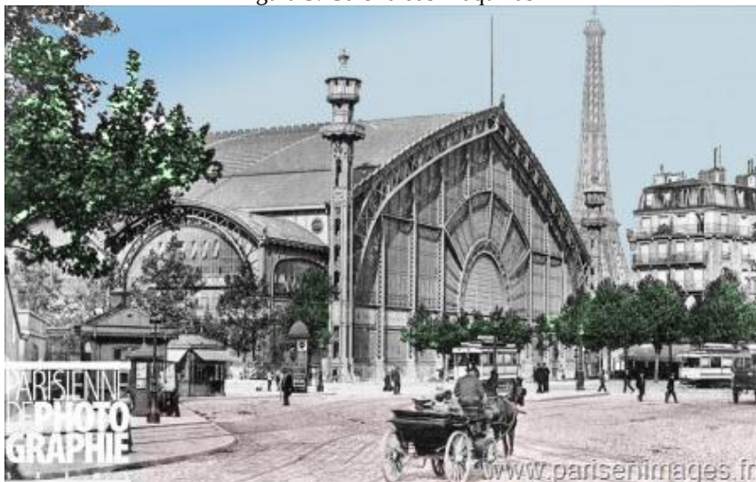
Figura 3: Galeria das Máquinas
