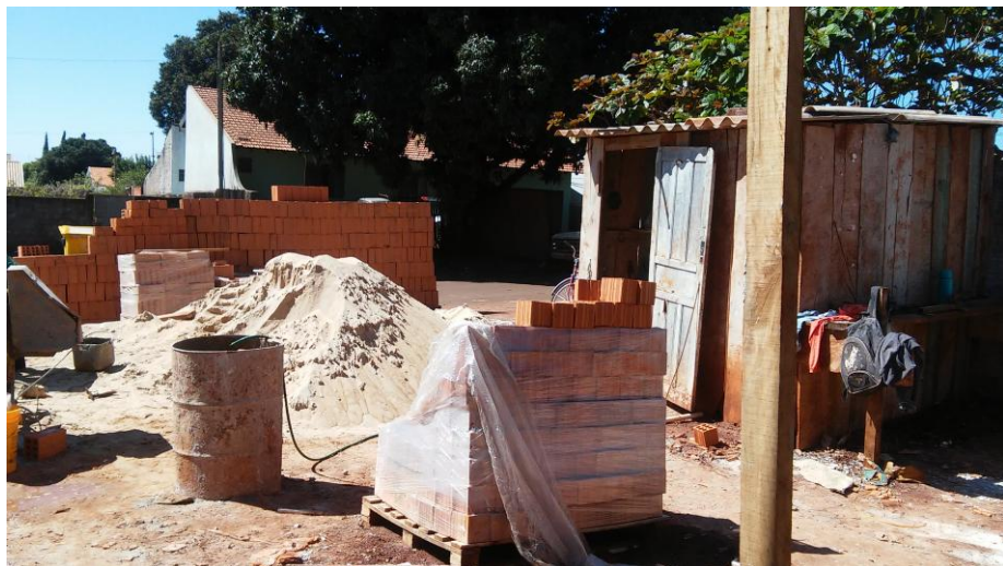
Figura 02: Canteiro de Obra
