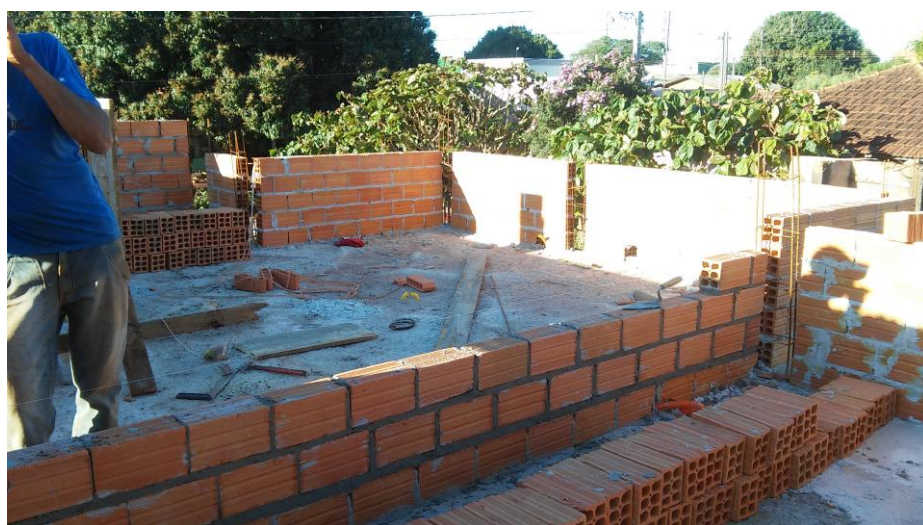
Figura 05: Levantamento de parede Fonte: Autora
