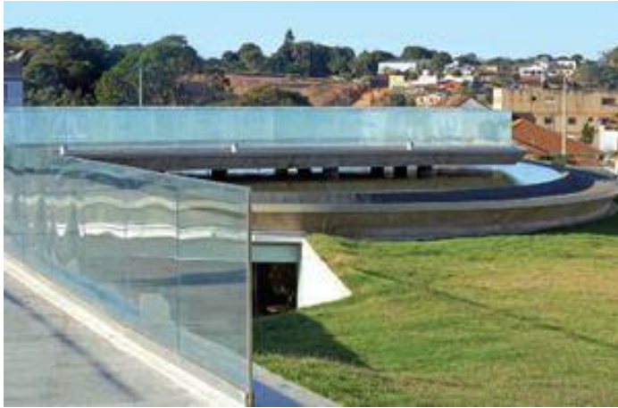
Figura 32- Passarela e Guarda Corps
