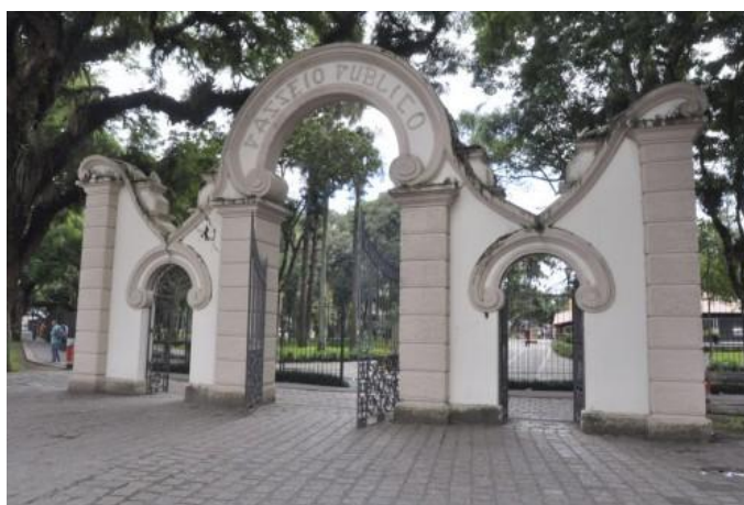
Figura 17 – Portão de ferro
