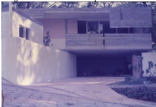
Imagem 07 – Residência Berquó: fachada
