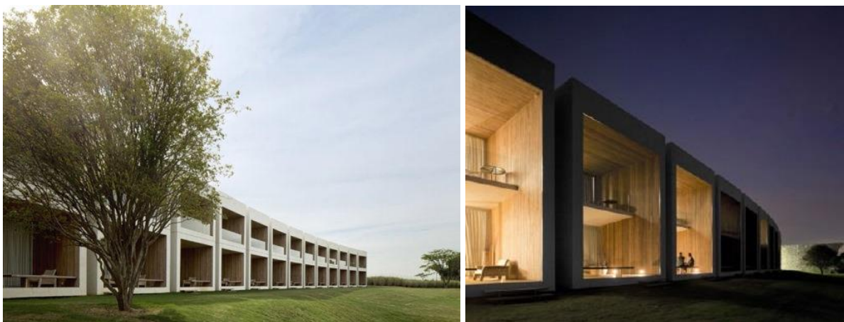
Figura 03: Apartamentos Fasano Hotel Boa Vista
