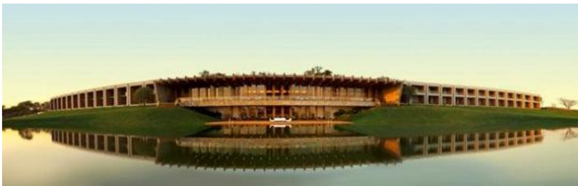
Figura 01: Fachada Panorâmica Fasano Hotel Boa Vista
