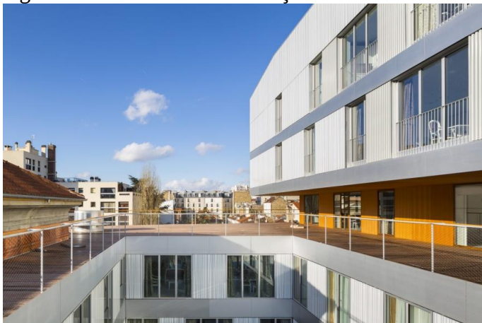
Figura 16- Pátio interno e terraço
