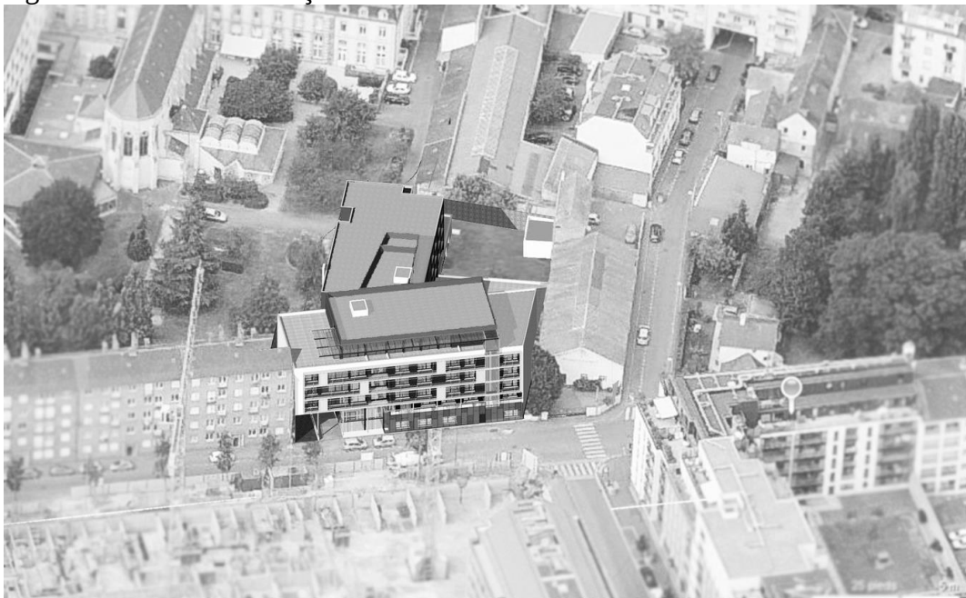
Figura 3- Foto da localização da Creche
