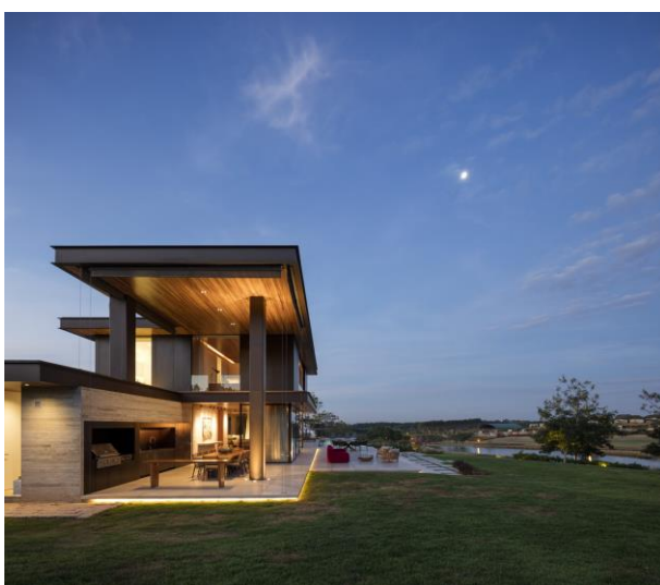
Figura 05 – Vista da estrutura principal
