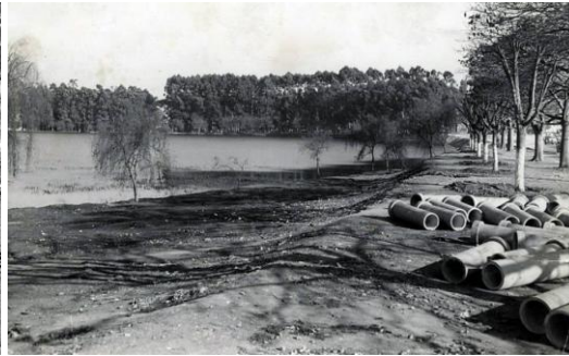
Construção do lago
