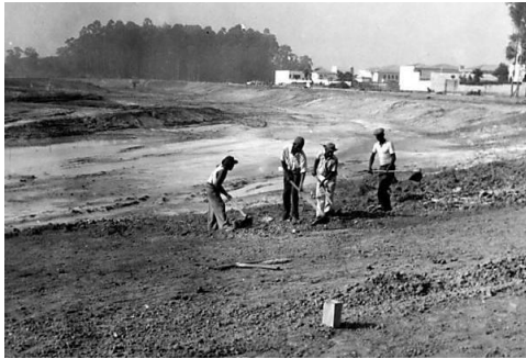
Construção do Parque
