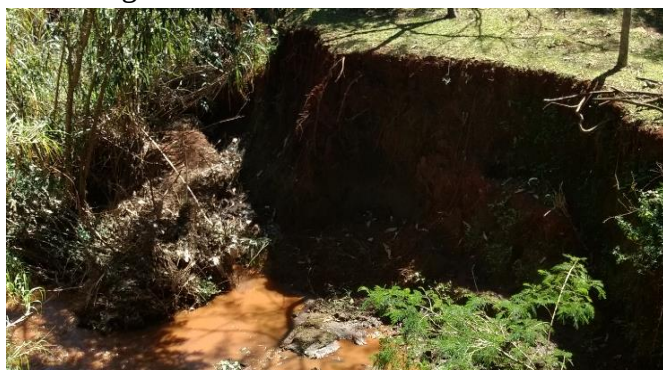
Figura 4 – Erosão do leito do rio
