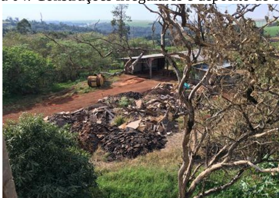
Figura 04: Construções irregulares e depósito de entulho
