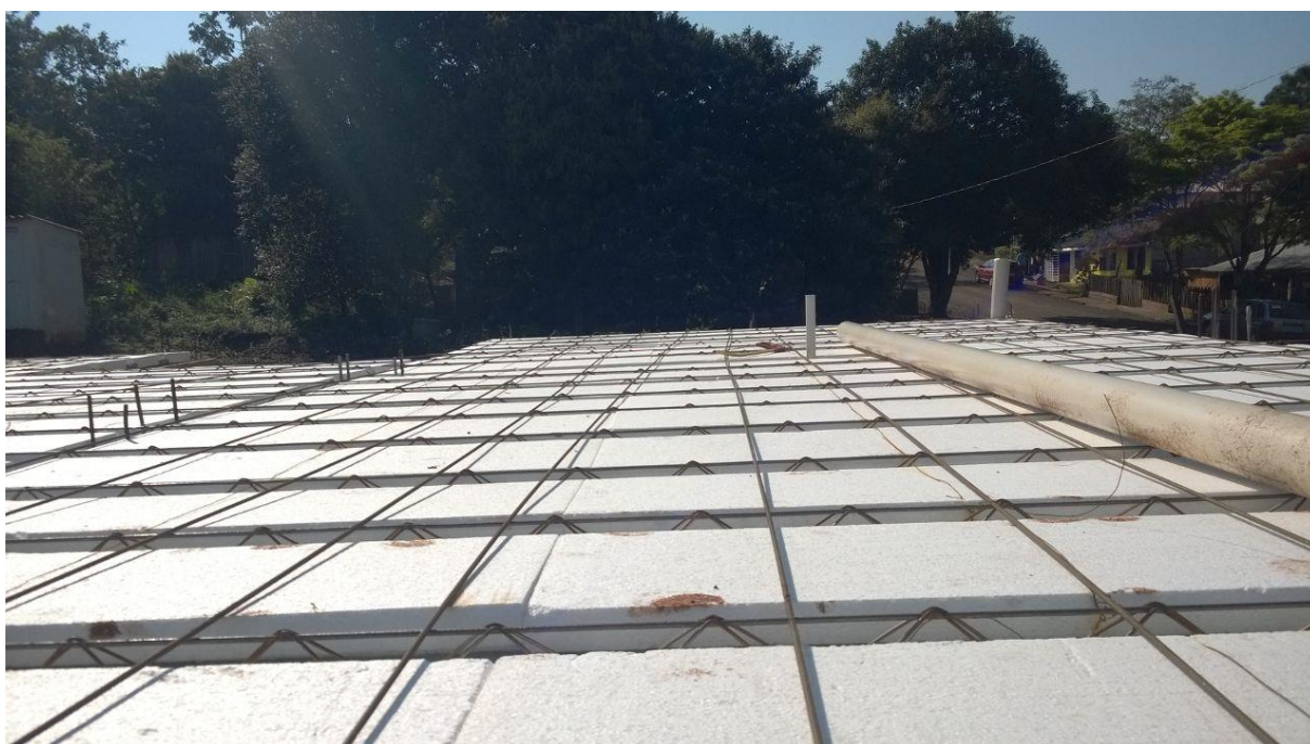
Figura 04 – Colocação de Vigotas Treliçada e Isopor
