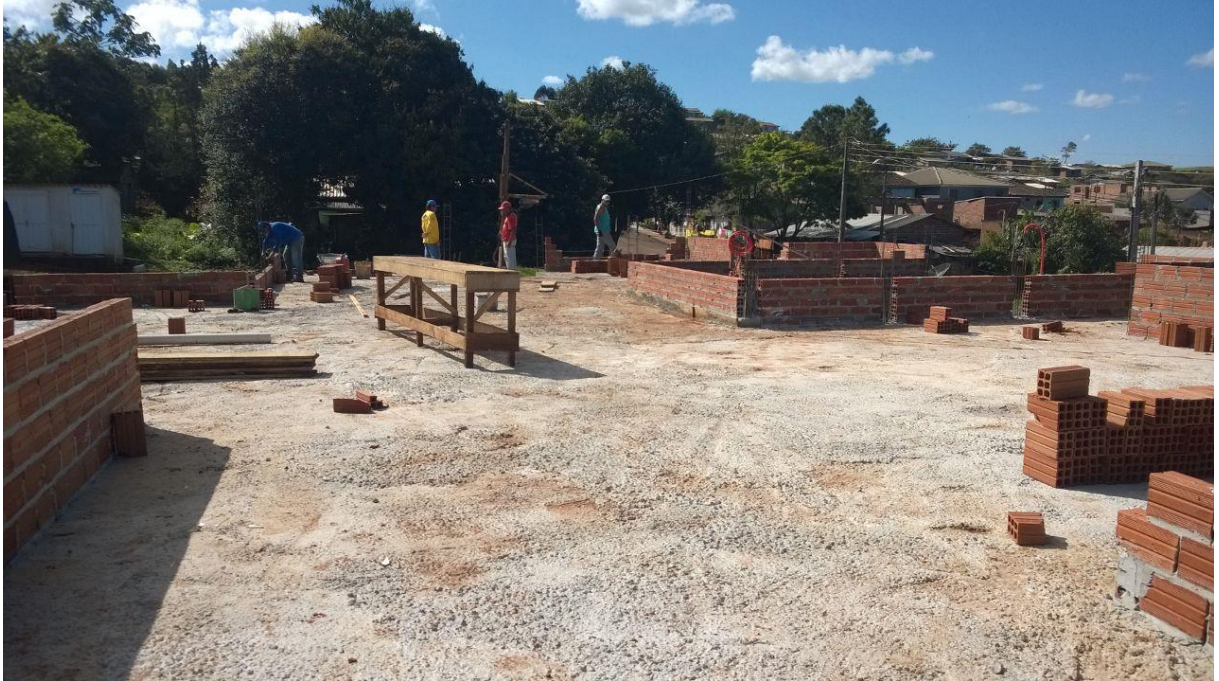
Figura 06 – Laje Concretada
