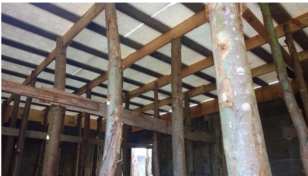
Figura 03 – Escoramento em madeira da laje
