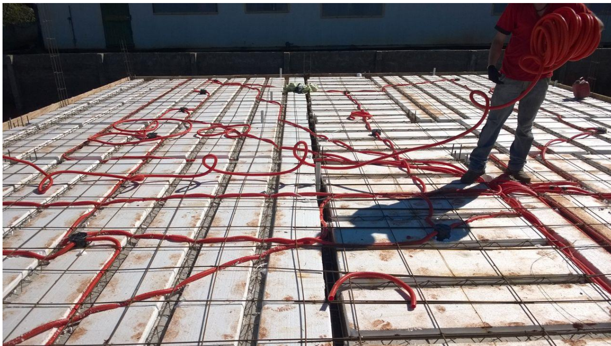
Figura 05 – Passagem dos conduítes e negativos
