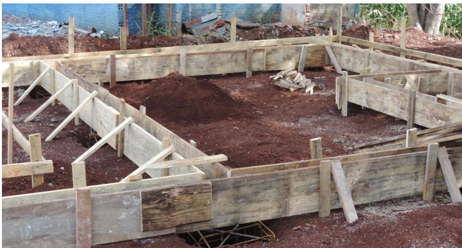
Figura 01 – construção do gabarito em madeira
