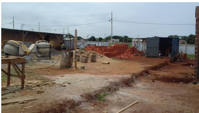
Figura 1. Canteiro de Obras.
