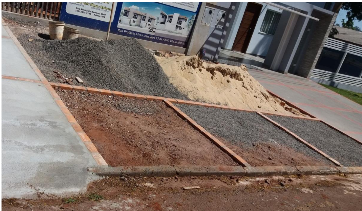
Figura 1 - Execução de passeio público/calçada
