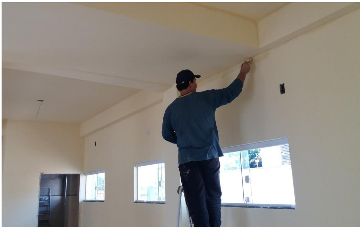
Figura 7 - Pintura sala comercial
