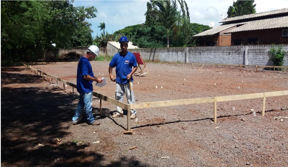
Figura 8 - Locação da obra
