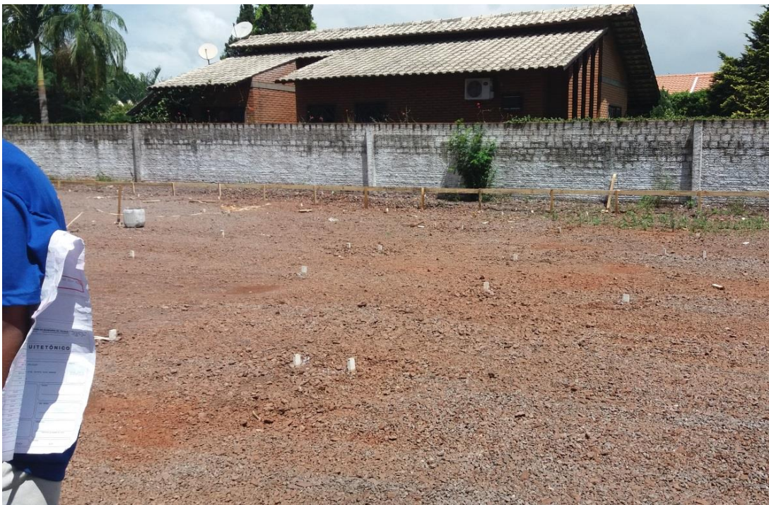
Figura 9 - Locação das estacas
