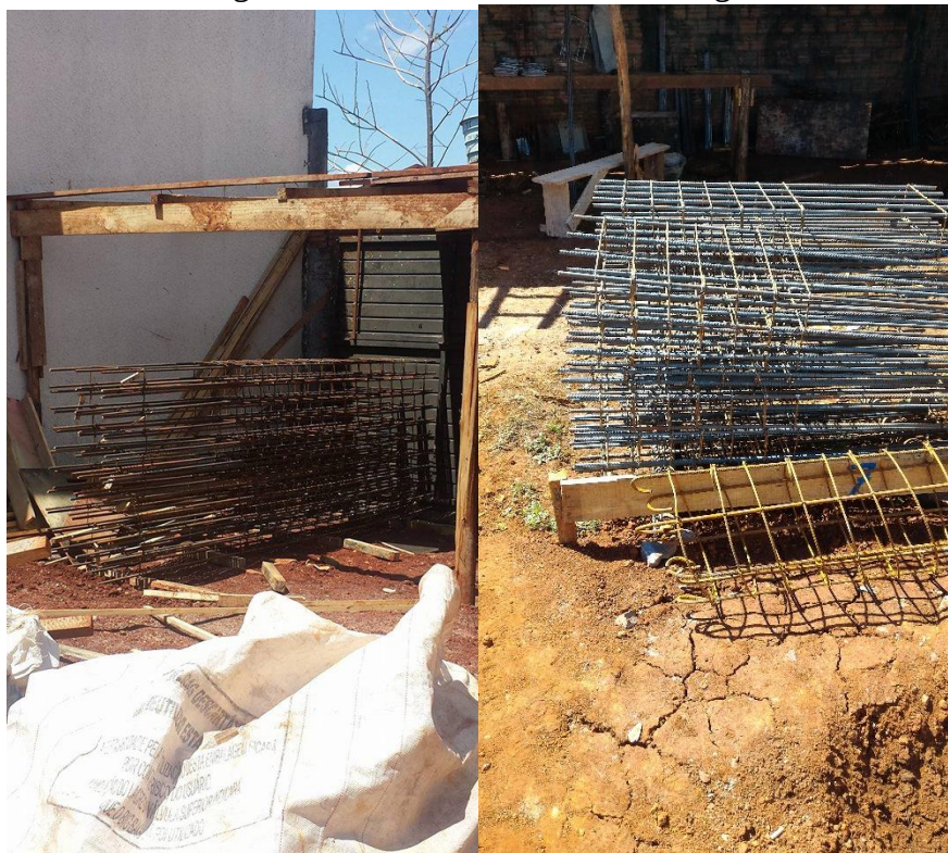
Imagem 06: Armazenamento das ferragens.
