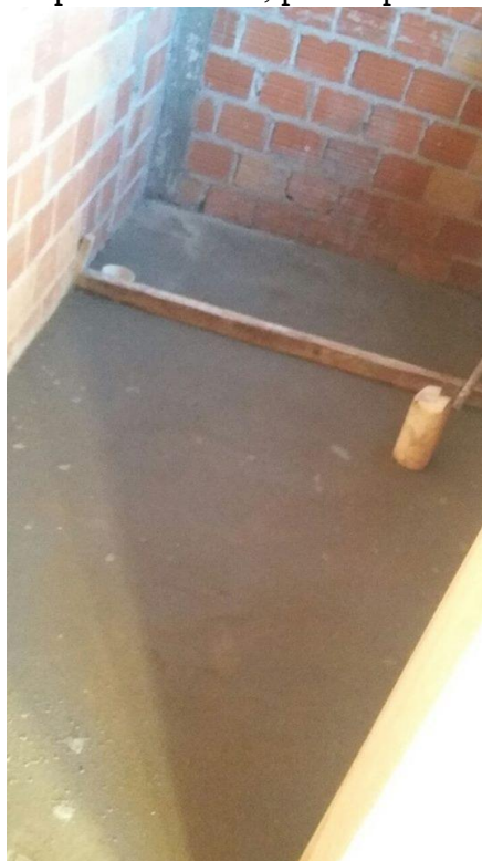
Imagem 11: Contra piso finalizado, pronto para receber a cerâmica.
