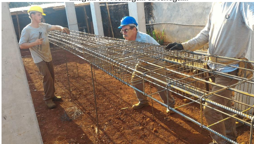
Imagem 07: Montagem da ferragem.
