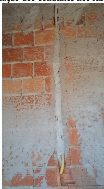
Imagem 13: Fixação dos conduites nos rasgos da alvenaria.
