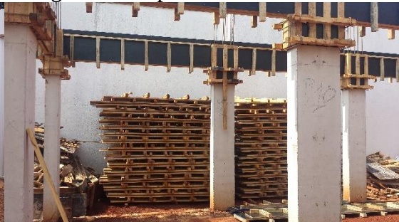
Imagem 03: Depósito de madeira/caixaria
