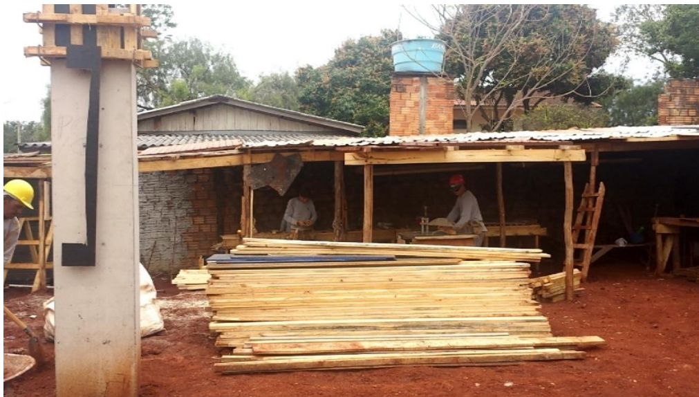
Imagem 05: Abrigo para serragem, soldagem, cortes, moldagem e montagem de materiais.
