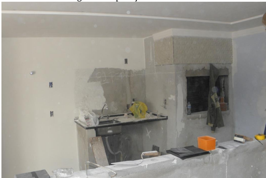
Imagem 14: Aplicação do revestimento
