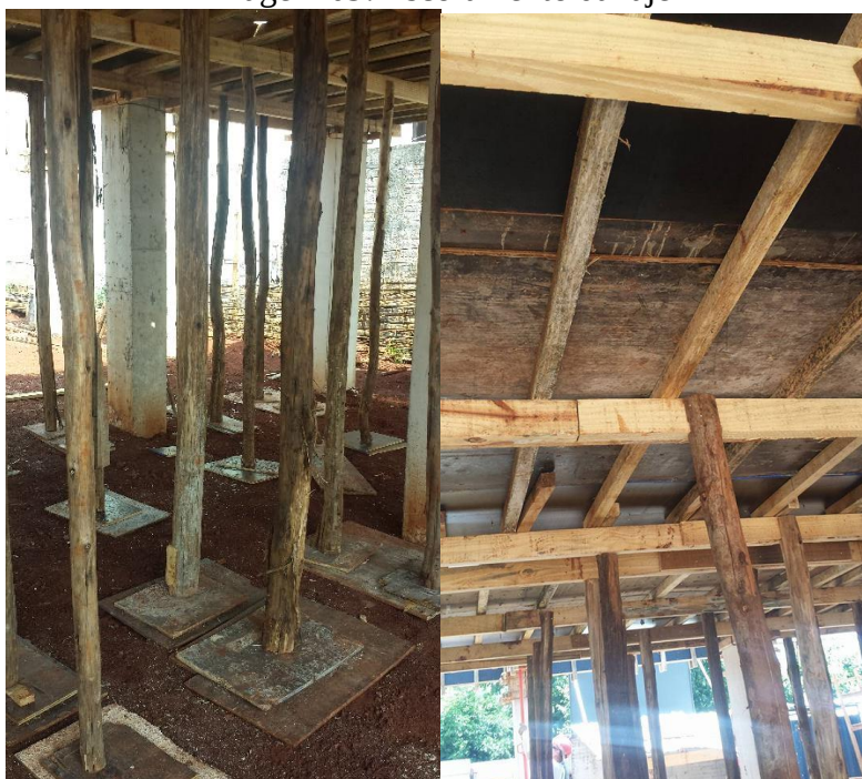
Imagem 09: Escoramento da laje
