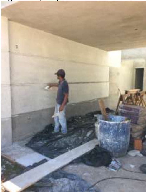
Figura 9: Aplicação de Massa Corrida
