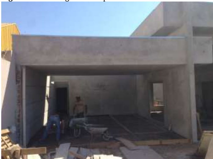
Figura 3: Concretagem Contrapiso
