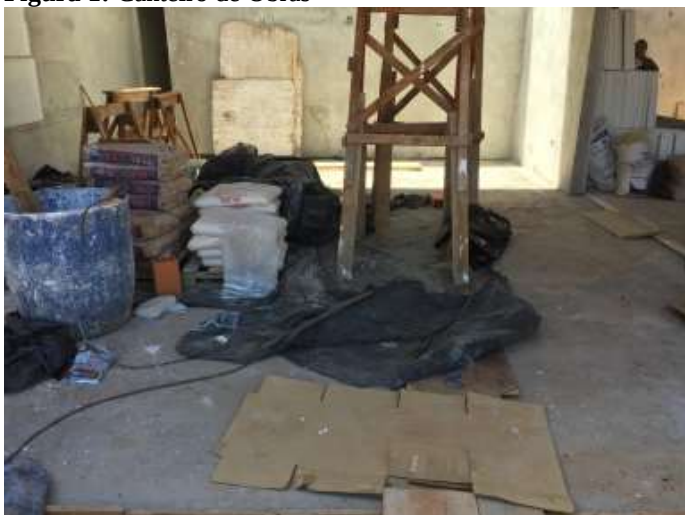
Figura 1: Canteiro de Obras
