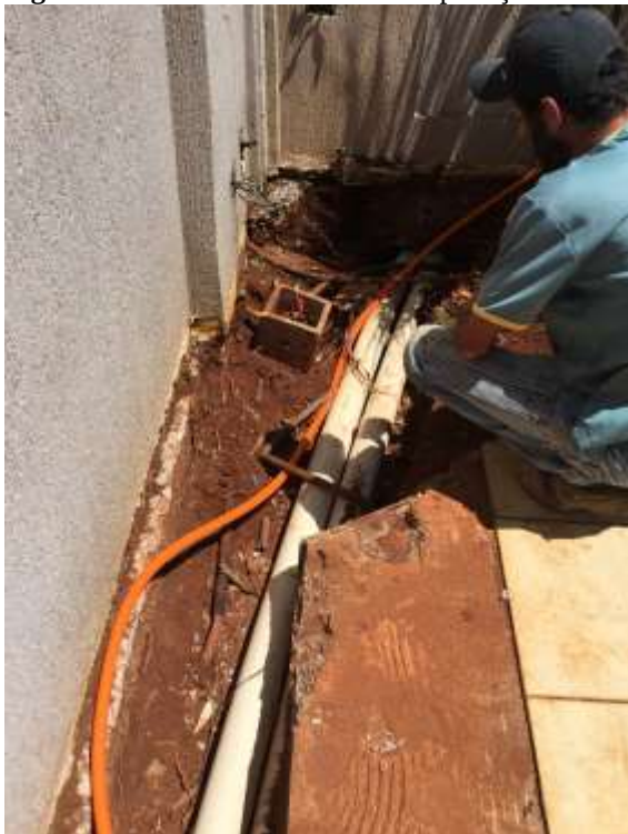
Figura 5: Recorte em Parede com Aplicação de Conduítes
