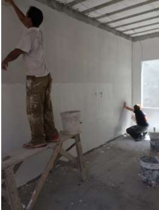
Figura 10: Aplicação de Massa Corrida
