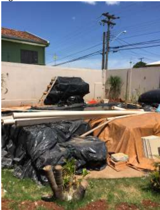
Figura 2: Canteiro de Obras
