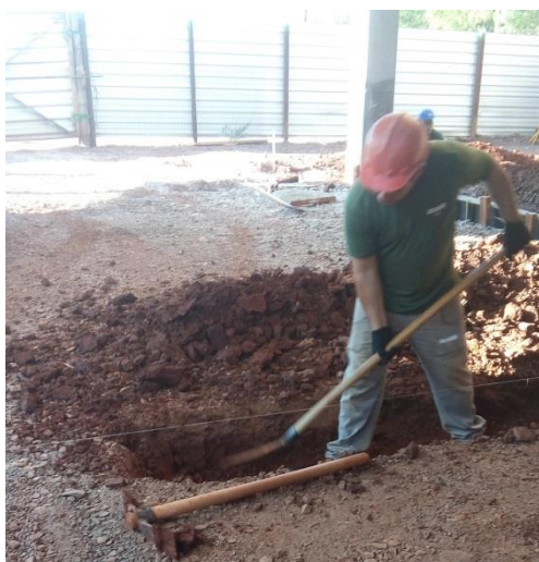
Figura 3. Escavando a baldrame.
