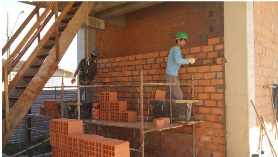
Figura 8. Levantamento da alvenaria.
