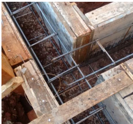
Figura 6. Travamento do baldrame.
