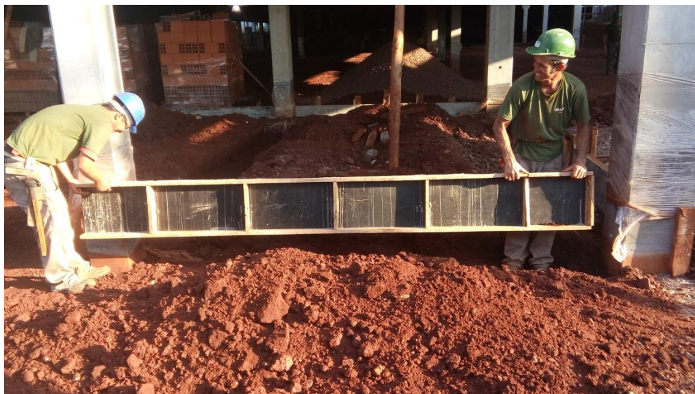
Figura 7. Fôrma sendo colocada na vala da viga baldrame.
