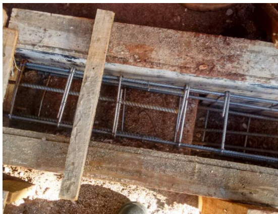
Figura 5. Ferragens das vigas baldrame.
