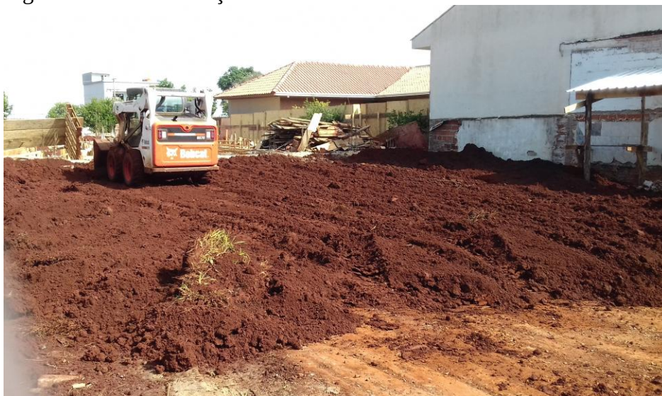
Figura 11 - Movimentação de terra
