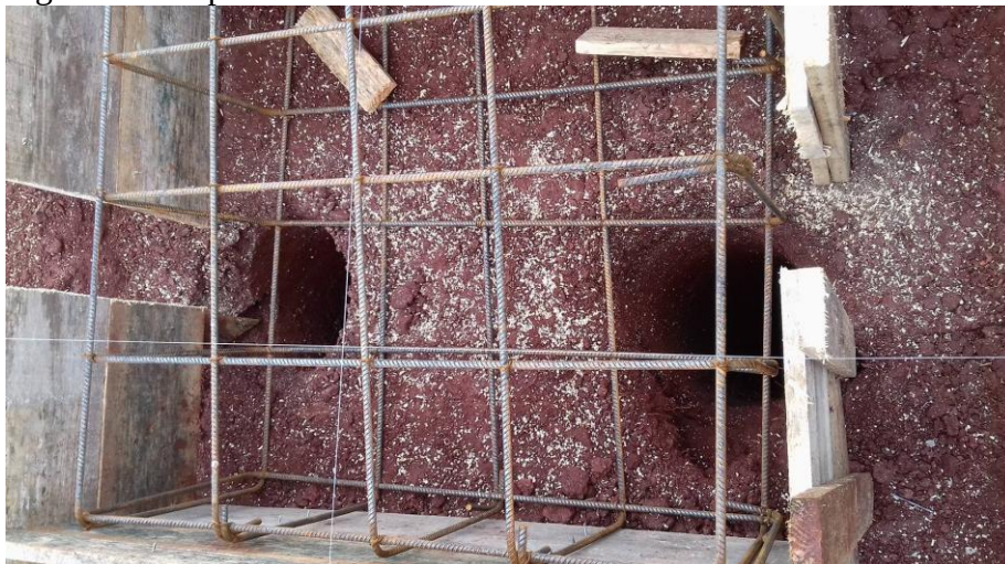
Figura 02 - Sapata com armadura e forma
