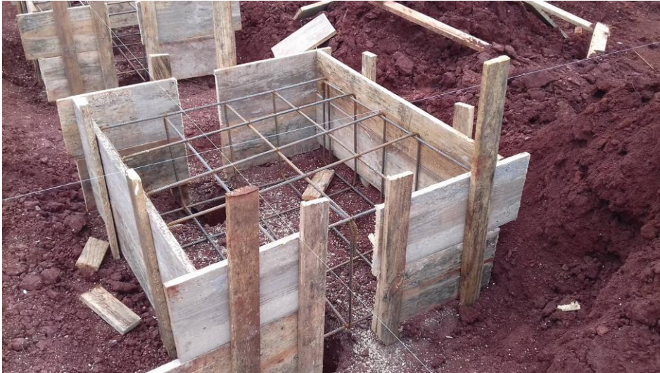
Figura 07 - Sapata com armadura e forma
