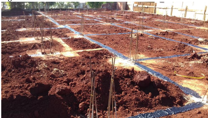
Figura 13 - Baldrames com terra nivelada
