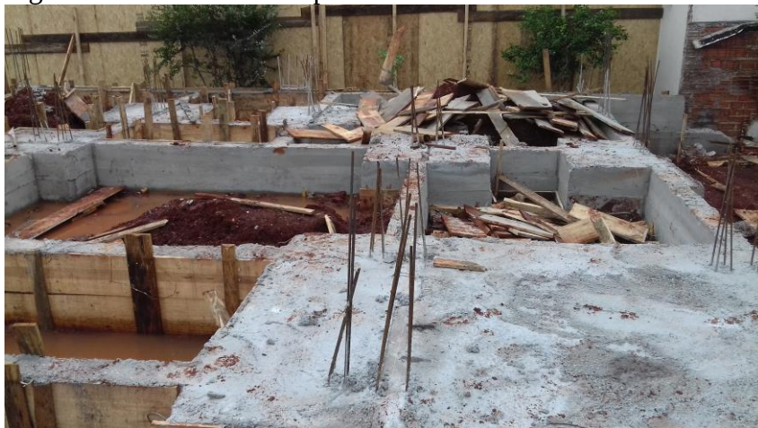
Figura 10 - Baldrames e sapatas concretadas
