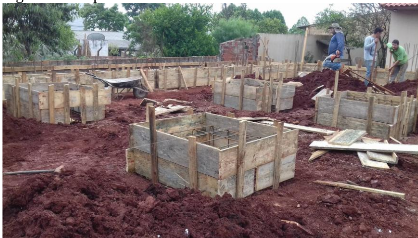
Figura 05 - Sapatas e baldrames com armaduras e formas
