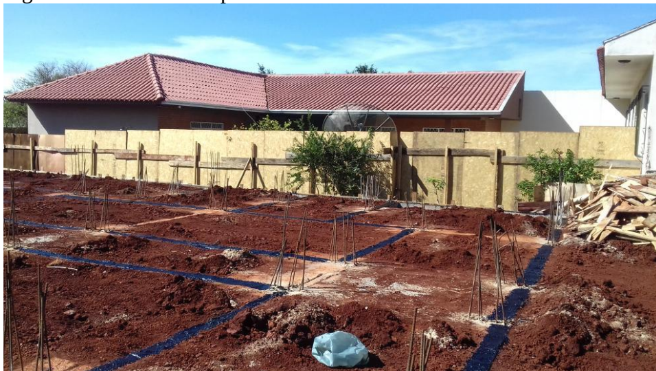
Figura 15 - Baldrame impermeabilizado
