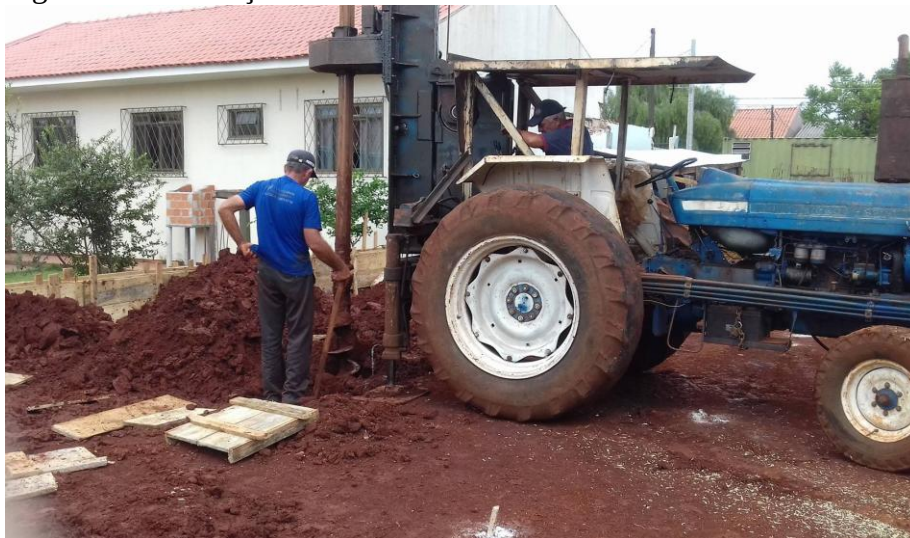
Figura 01- Perfuração através da estaca-broca
