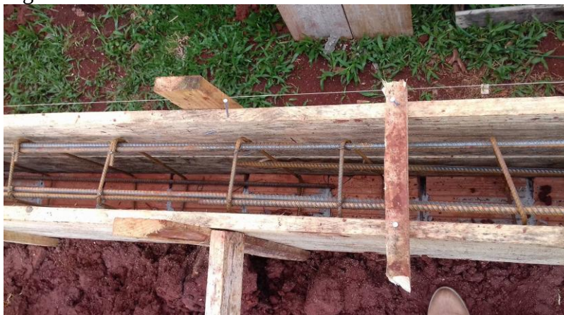
Figura 04 - Baldrame com armadura e forma
