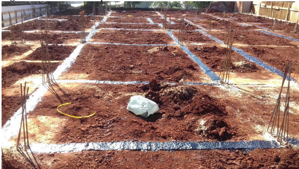
Figura 14 - Baldrame impermeabilizado
