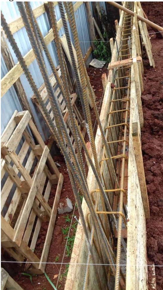
Figura 08 - Baldrame com armadura e forma
