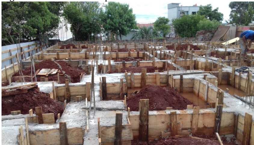
Figura 09 - Baldrames e sapatas concretadas
