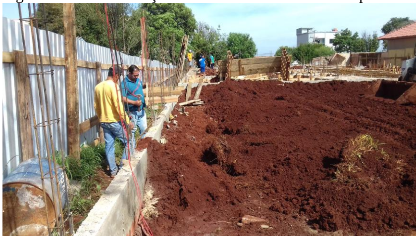
Figura 12 - Movimentação de terra e baldrame do muro pronto
