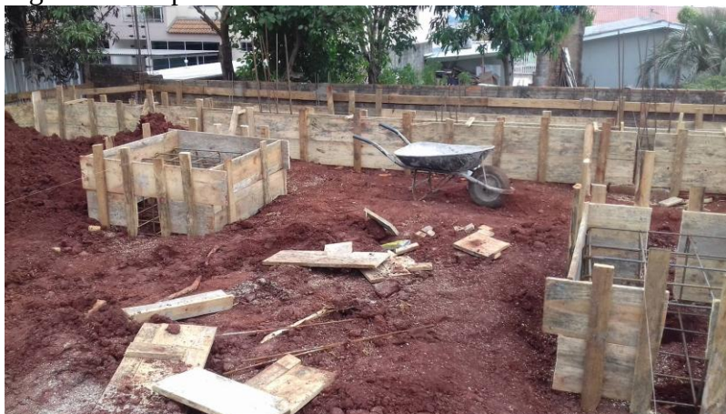
Figura 03 - Sapatas e baldrame com armaduras e formas
