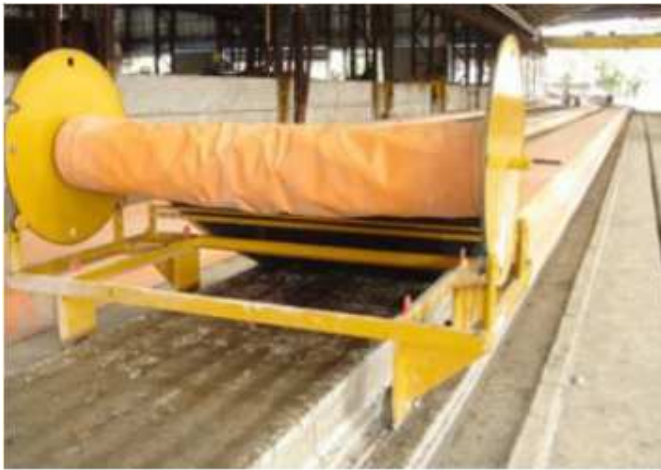
Figura 8 – Cura do concreto
