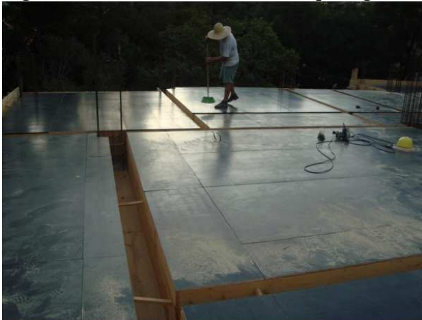
Figura 15 – Fôrmas colocadas e limpeza geral
