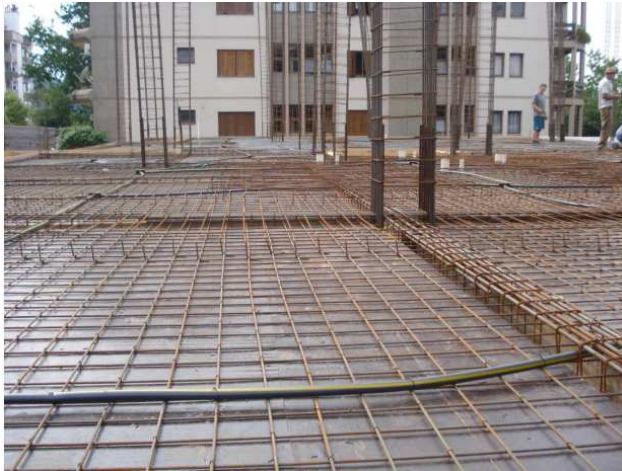
Figura 16 – Armaduras da laje e vigas
