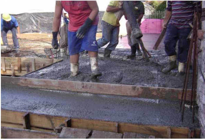
Figura 17 – Concretagem da laje maciça
