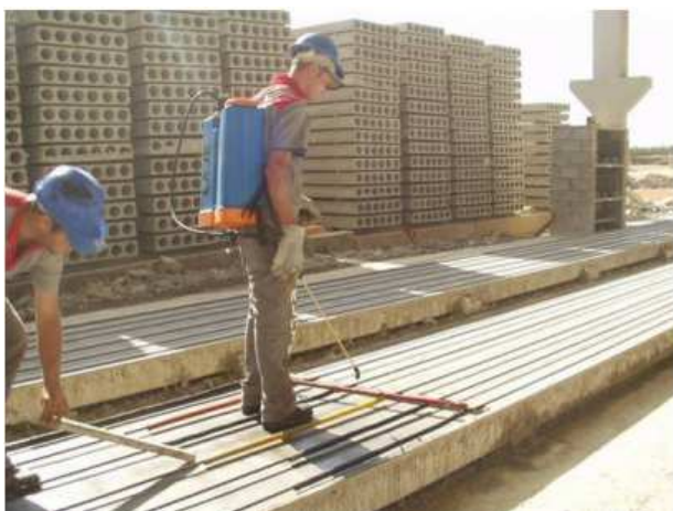
Figura 6 – Aplicação de desmoldante com pulverizador
