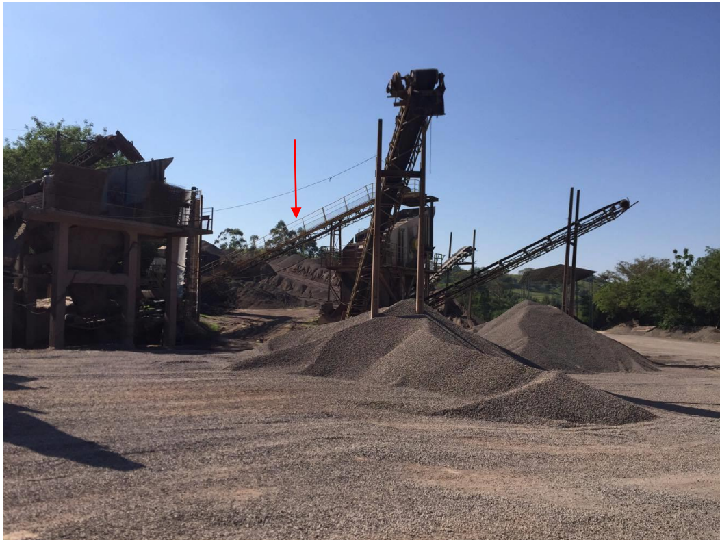
Figura 4 - Passarela fixada na correia transportadora.
