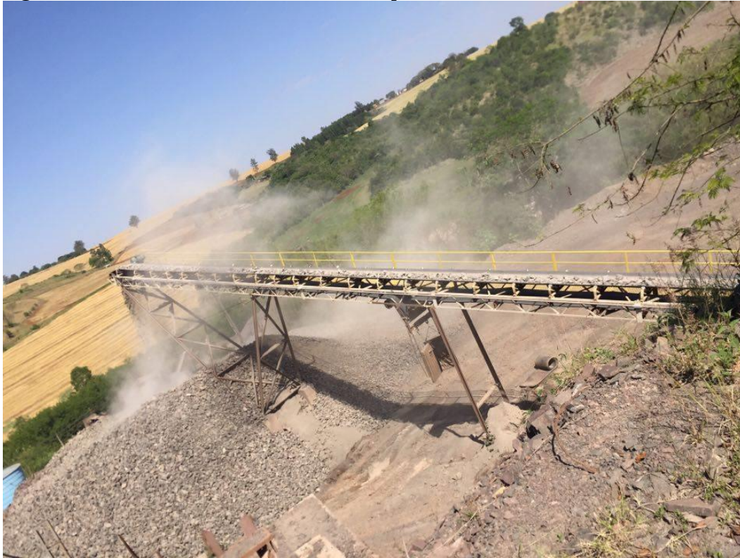
Figura 3 - Passarela fixada na correia transportadora.
