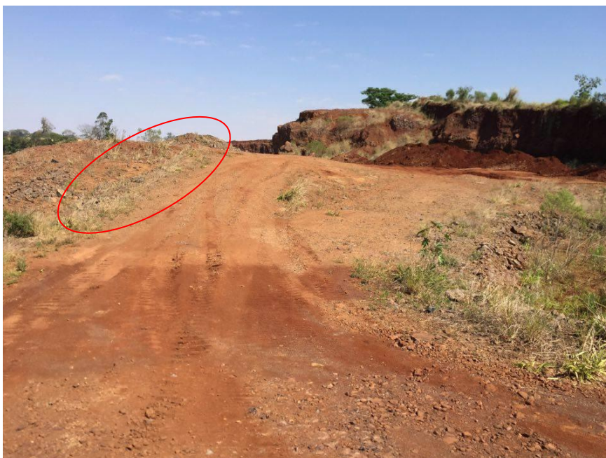
Figura 18 - Estrada de acesso à bancada e leira no limite.
