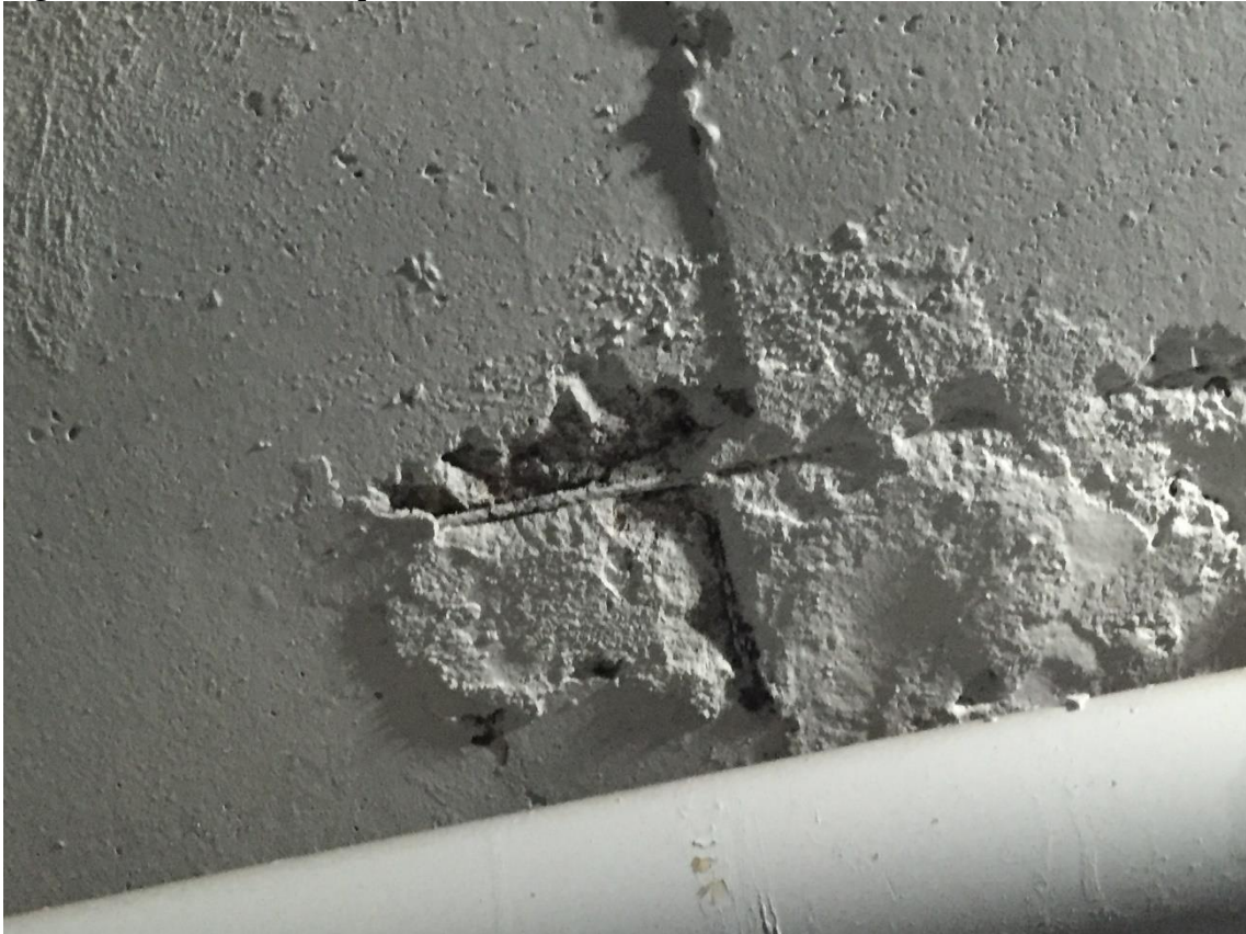
Figura 20 – Armadura exposta.
