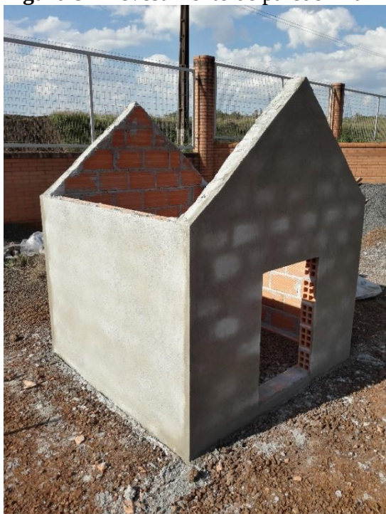
Figura 9 - Revestimento de parede finalizado.
