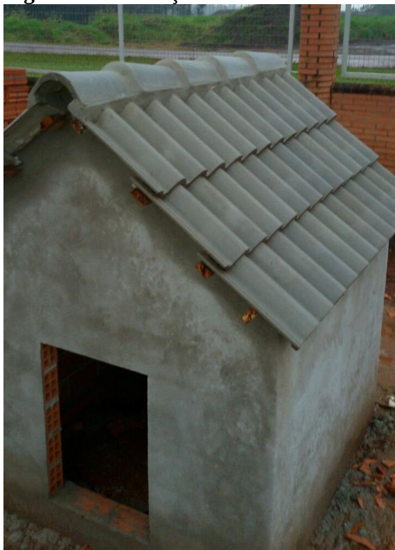
Figura 13 - Execução da cobertura em Telha Coppo Veneto.
