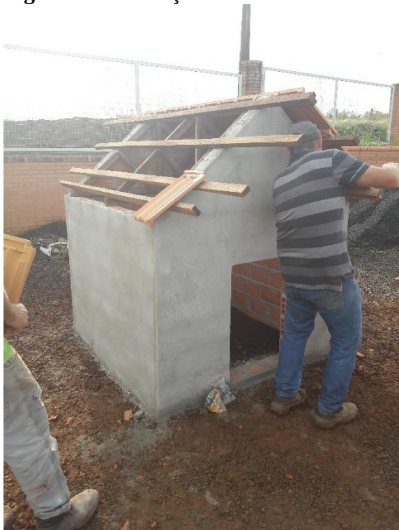
Figura 12 - Execução da cobertura em Telha Francesa.
