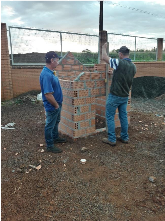
Figura 7 - Execução da alvenaria.
