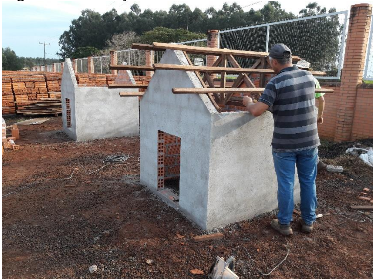
Figura 10 - Execução da cobertura em Telha Francesa.
