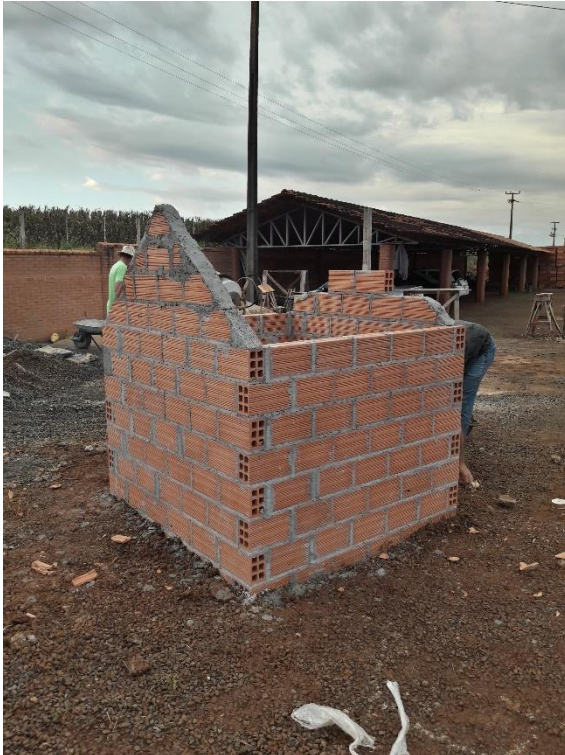
Figura 6 - Execução da alvenaria.
