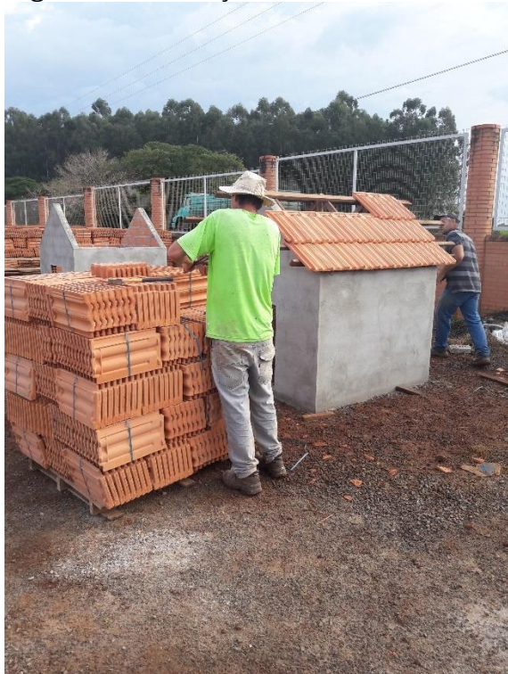
Figura 11 - Execução da cobertura em Telha Francesa.
