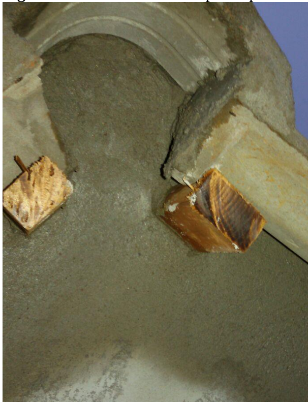
Figura 15 - Preenchimento no protótipo de telha de concreto.
