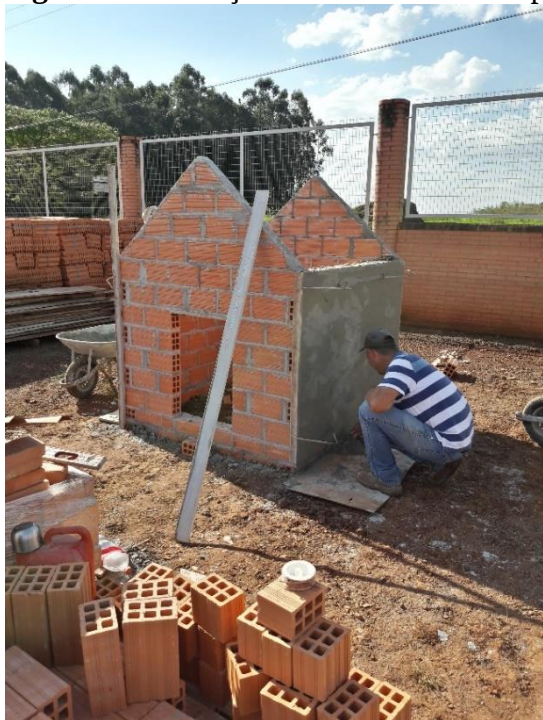
Figura 8 - Execução do revestimento de parede.
