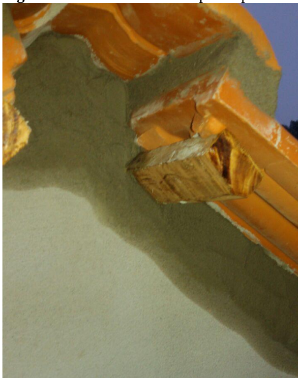
Figura 14 - Preenchimento no protótipo de telha de cerâmica.
