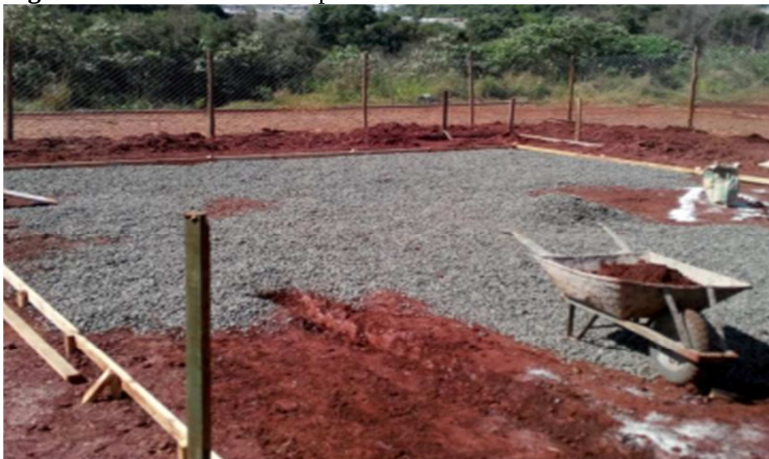
Figura 19 - Camada de brita para recebimento do concreto
