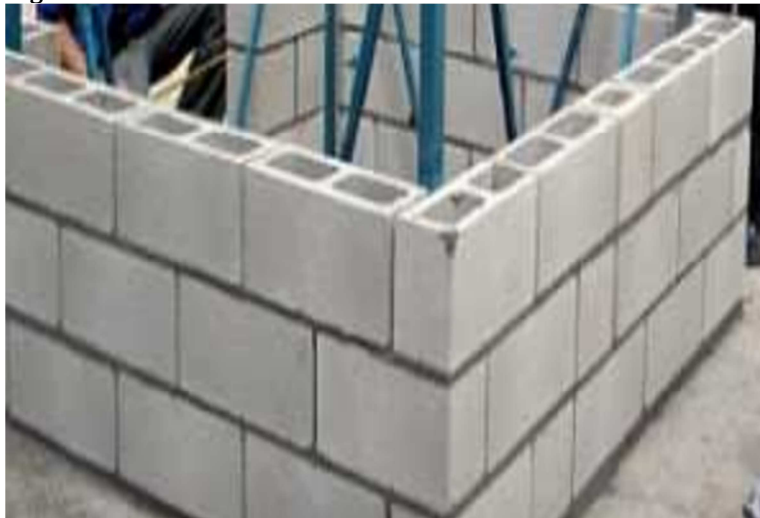
Figura 6 - Fechamento com bloco estrutural
