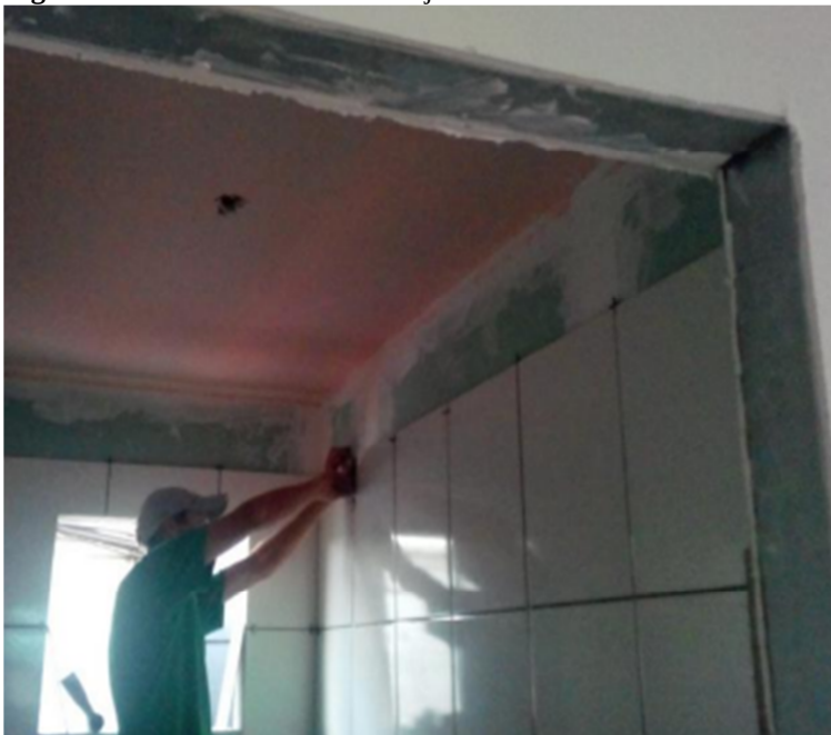
Figura 30 - Assentamento de azulejo
