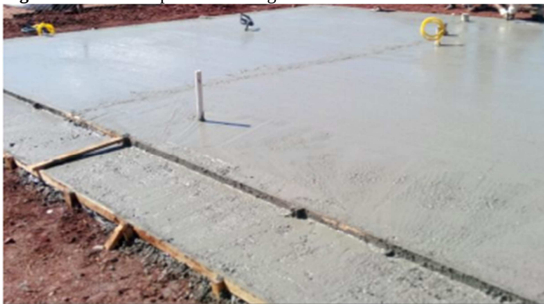
Figura 21 - Radier após a concretagem
