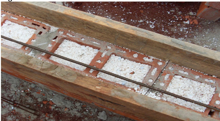
Figura 10 - Preenchimento de resíduos de EPS nos vãos dos blocos
