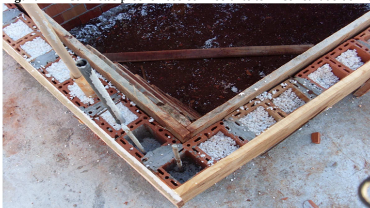
Figura 22 - Canaletas preenchidas com isolante térmico retirado do meio ambiente
