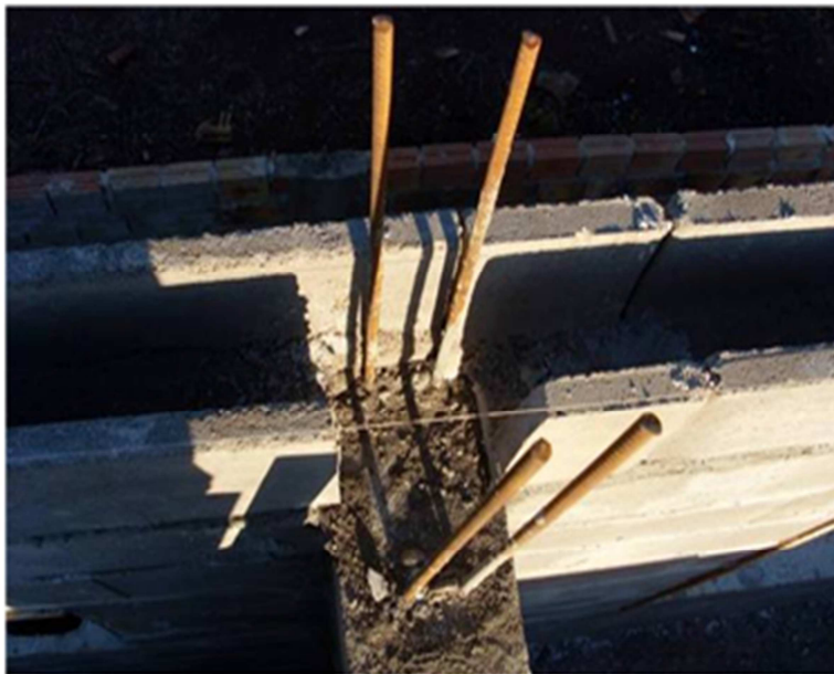
Figura 27 - Pilar pós concretagem sem utilização de formas de madeira
