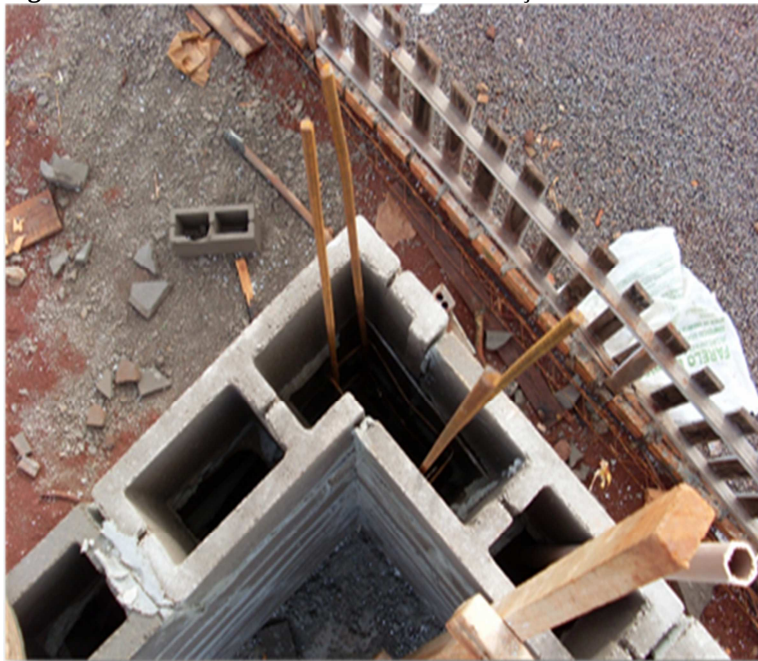
Figura 26 - Fechamento das colunas sem utilização de formas de madeira
