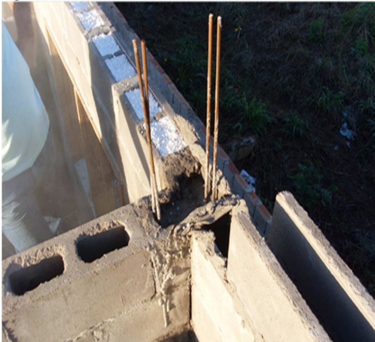
Figura 25 - Assentamento dos blocos estruturais com isolamento térmico
