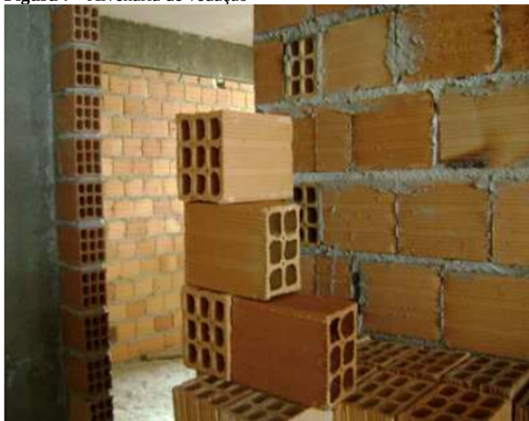
Figura 7 - Alvenaria de vedação
