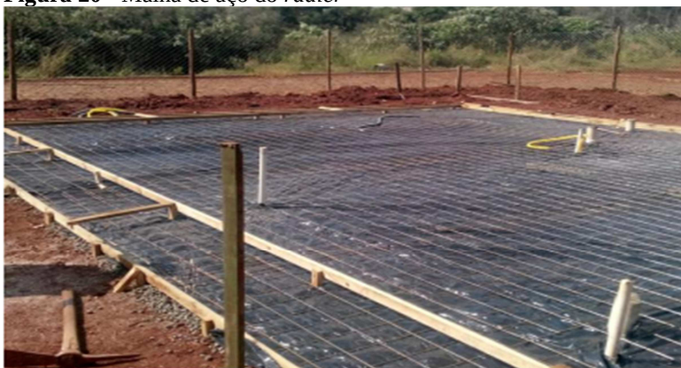
Figura 20 - Malha de aço do radier
