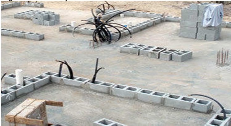
Figura 11 - Instalações elétricas e hidrossanitárias
