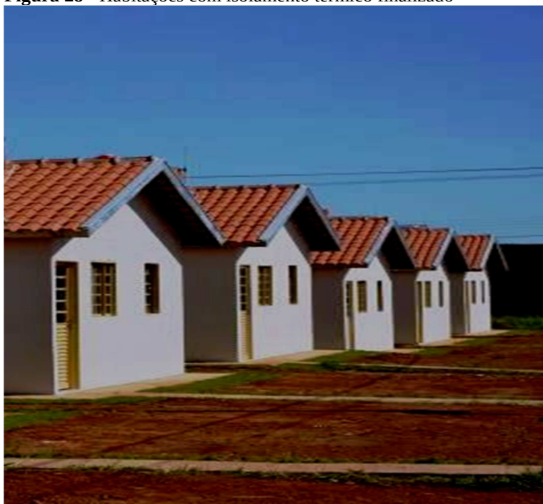
Figura 28 - Habitações com isolamento térmico finalizado
