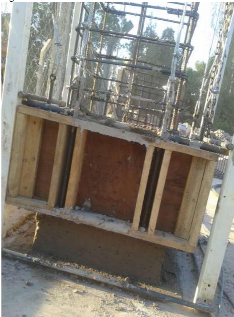
Figura 15 - Primeiro deslizamento da fôrma.
