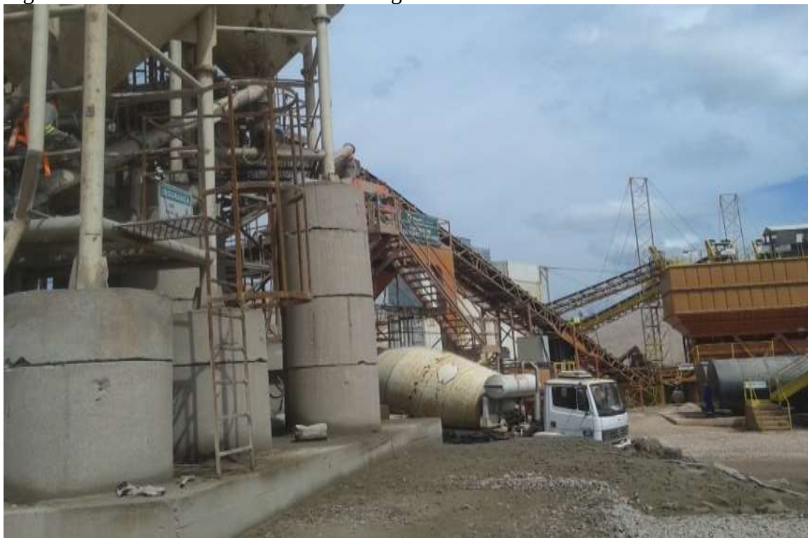
Figura 5 - Caminhão betoneira sendo carregado.
