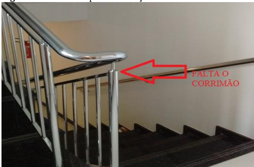
Figura 53: Guarda corpo da edificação.
