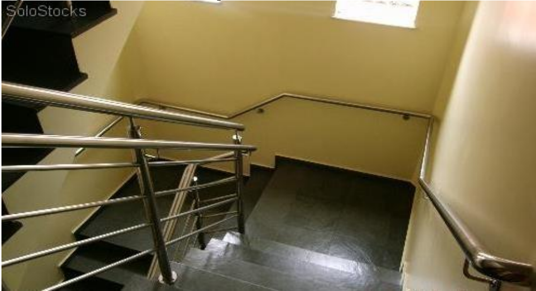
Figura 31: Modelo de Guarda-corpo e corrimão em escadaria.
