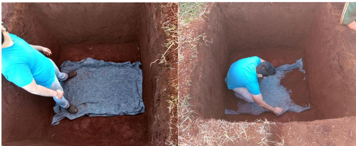
Figura 11 – Aplicação Manta Geotêxtil Tecido
