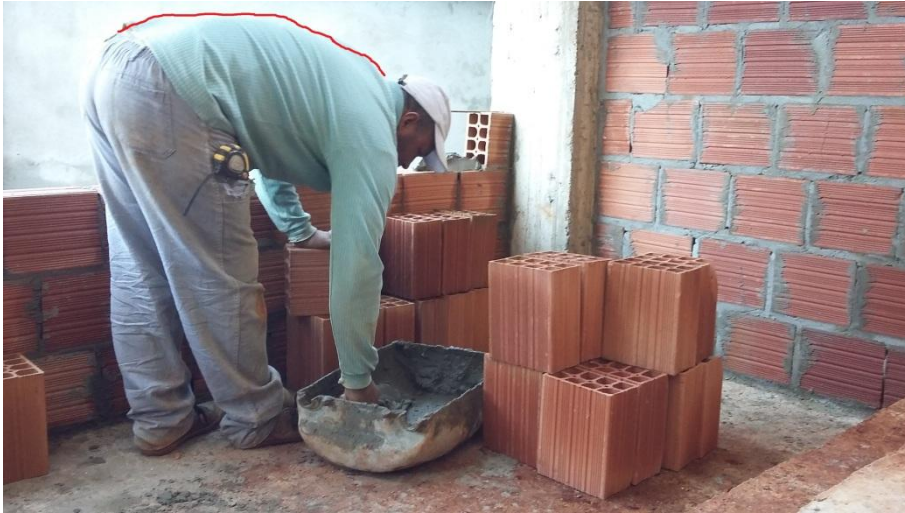
Figura 1: Pedreiro passando massa no tijolo
