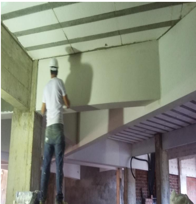
Figura 6: Pedreiro revestindo de gesso
