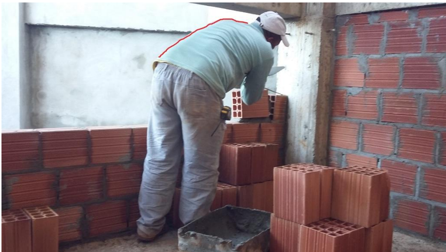
Figura 2: Pedreiro colocando o tijolo na fiada
