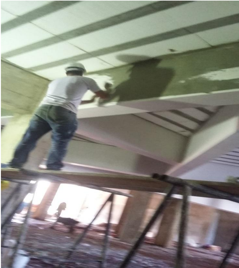
Figura 5: Pedreiro revestindo de gesso
