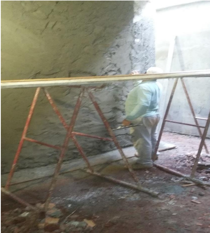
Figura 4: Pedreiro fazendo reboco
