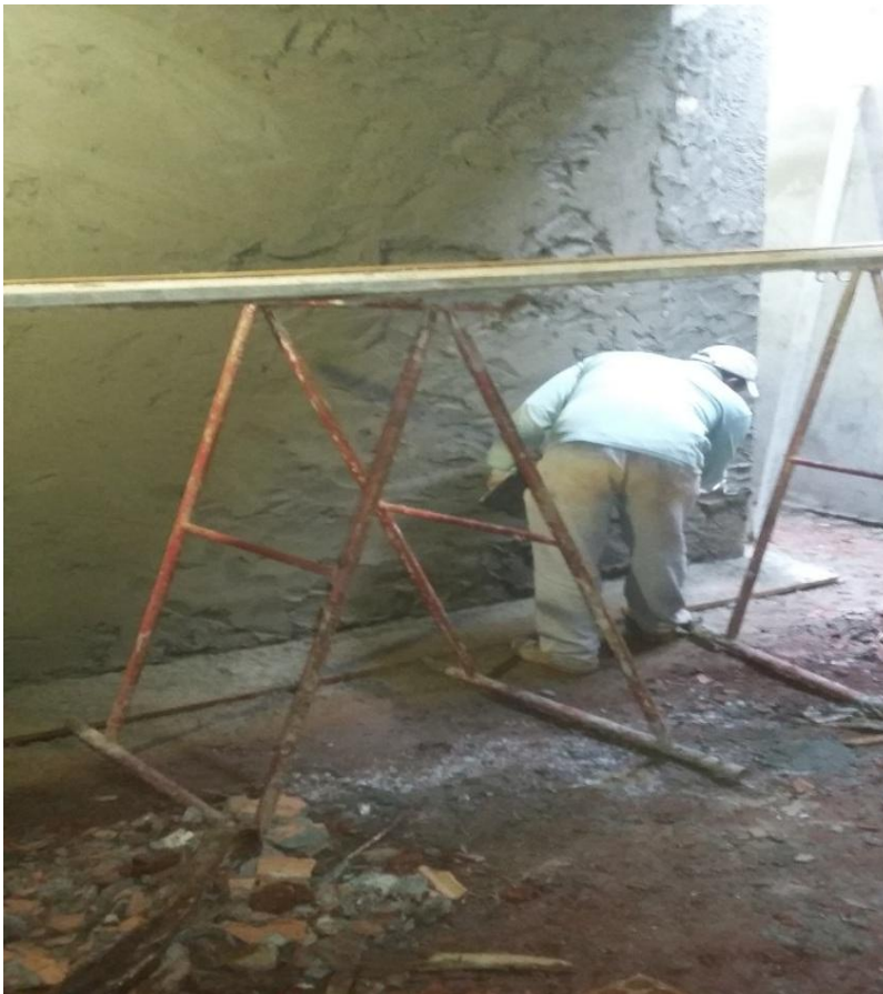
Figura 3: Pedreiro espalhando argamassa
