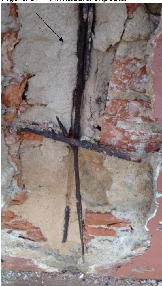
Figura 37 – Armadura exposta
