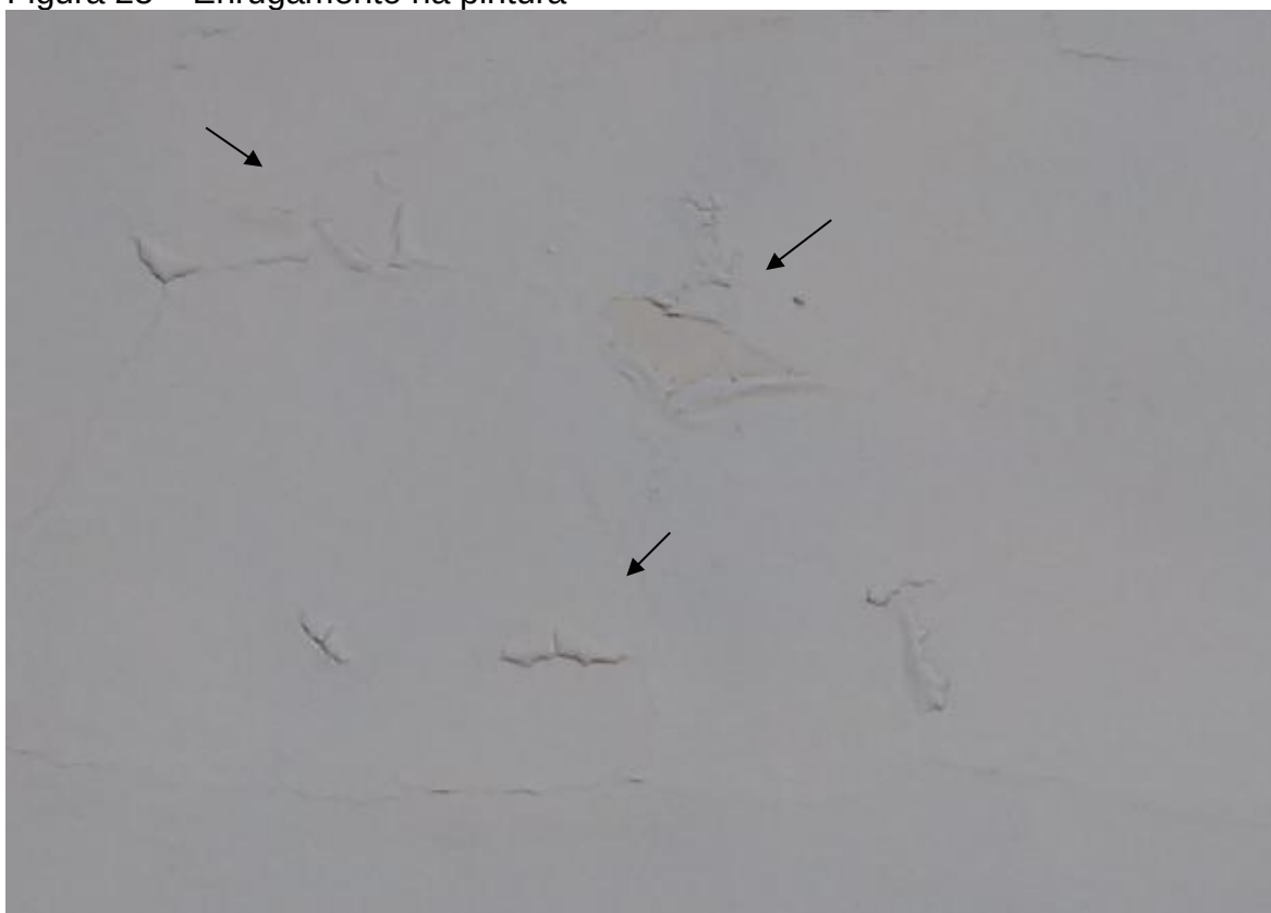
Figura 25 – Enrugamento na pintura
