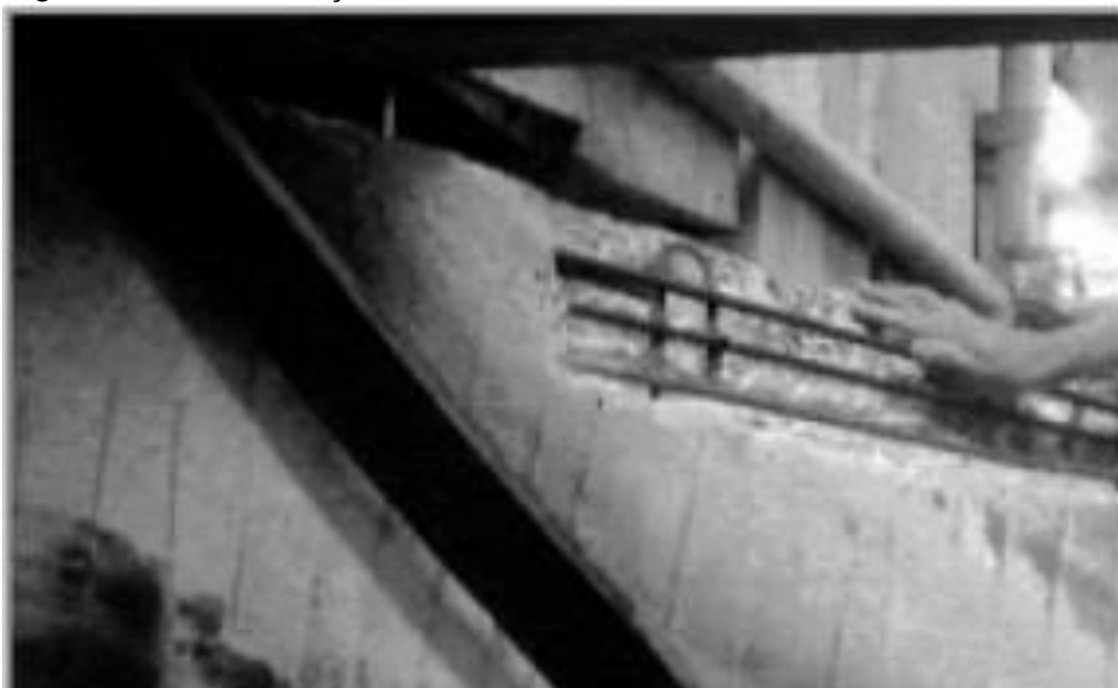
Figura 39 – Substituição da armadura
