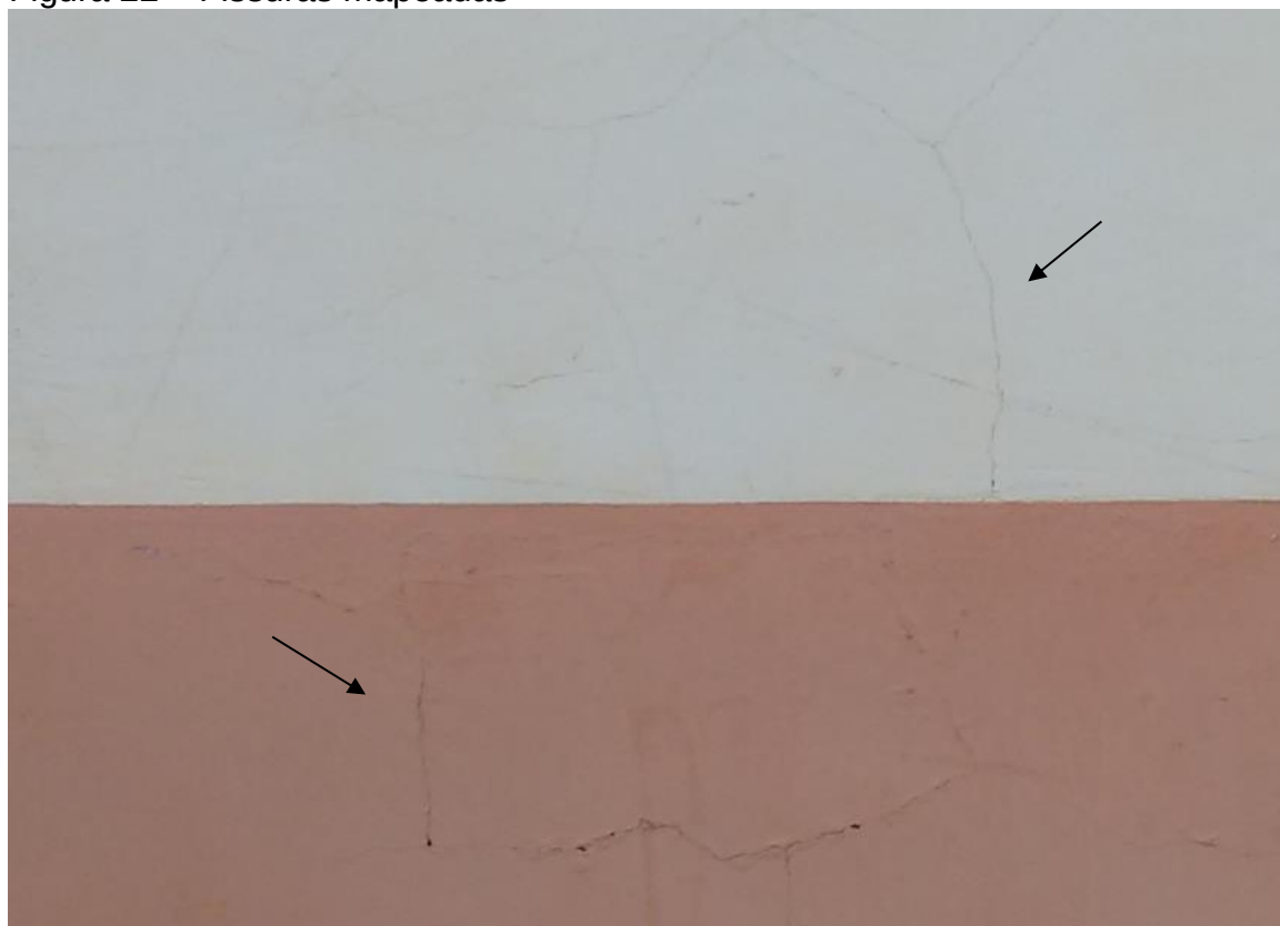
Figura 22 – Fissuras mapeadas
