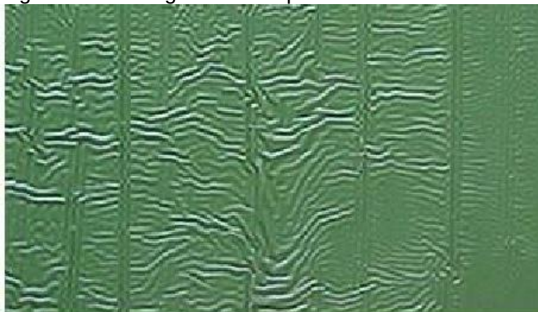
Figura 10 – Enrugamento na pintura
