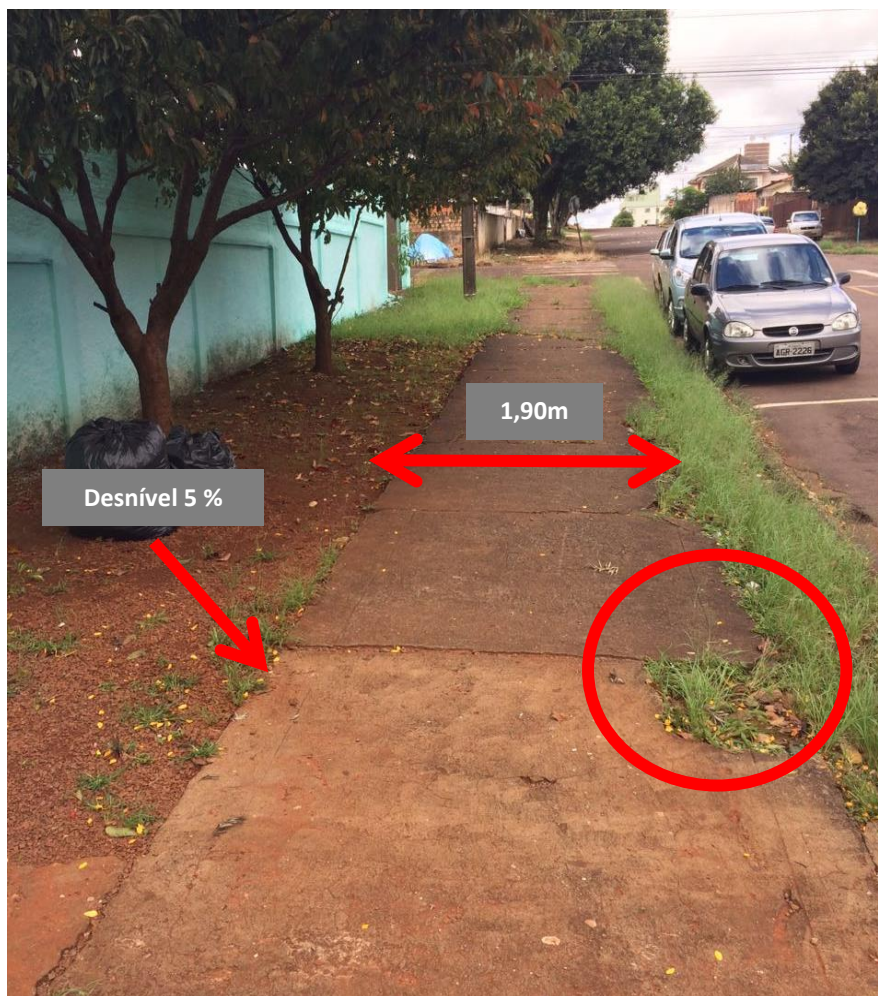
Figura 25: Calçada parte externa
