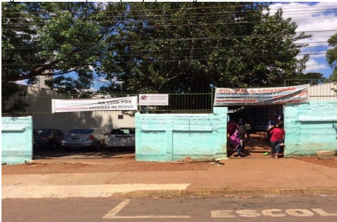
Figura 01: Fachada (acesso principal) do Colégio Estadual São Cristóvão
