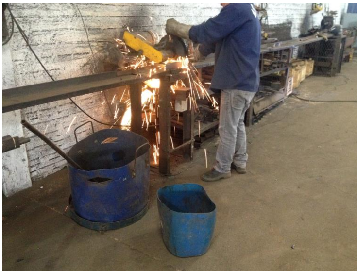
Figura 06: Recipientes de depósito das sobras.
