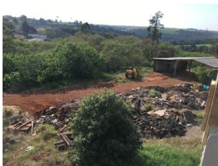
Imagem 3 – Vista do Local
