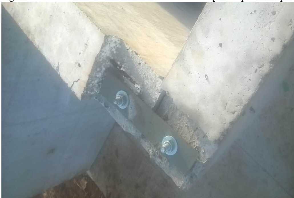
Figura 36 – Fixadores metálicos definitivos instalados na parte superior dos painéis.
