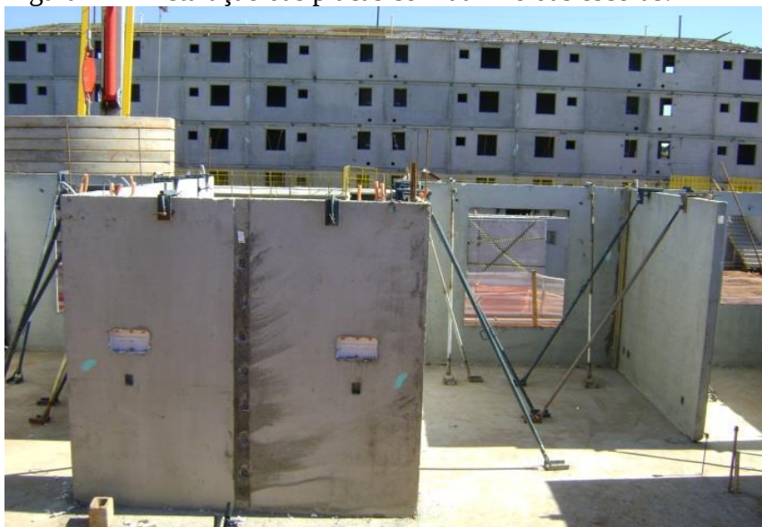
Figura 12 – Instalação das placas com auxílio das escoras.
