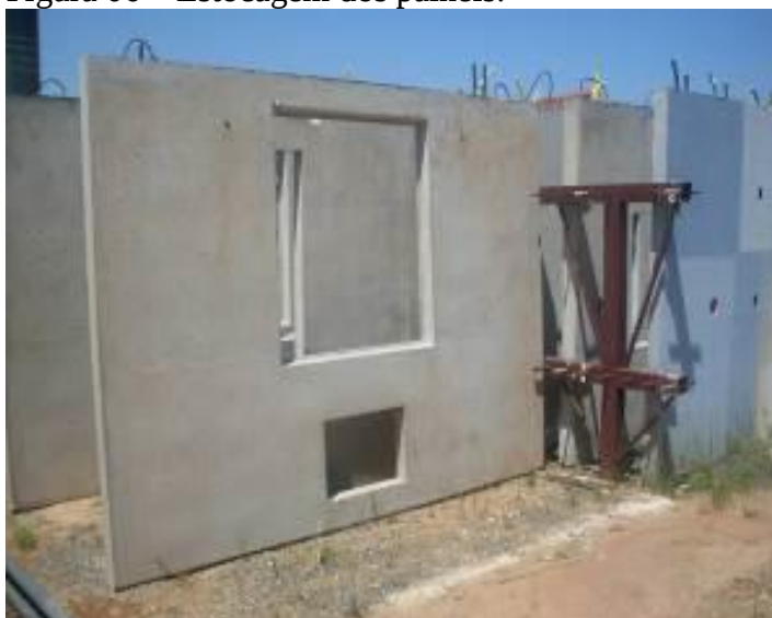
Figura 06 – Estocagem dos painéis.
