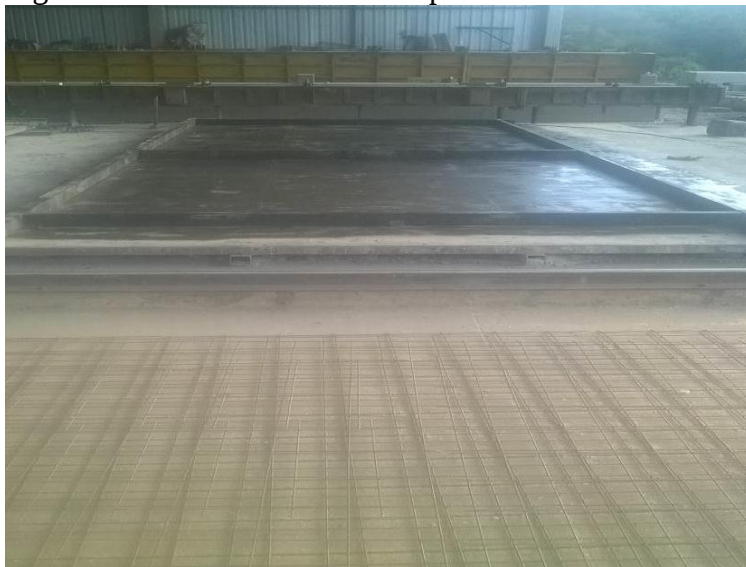
Figura 25 – Fôrma horizontal de painel com desmoldante aplicado nas instalações da fábrica.
