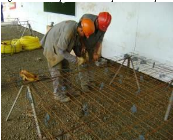
Figura 03 – Execução da armadura para a fabricação dos painéis.
