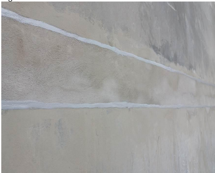
Figura 46 – Junta horizontal finalizada.
