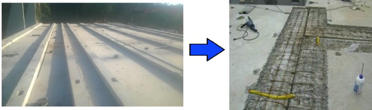
Figura 50 – Comparação da instalação das lajes executadas e instalações aprovadas pela DATec N°007-A.
