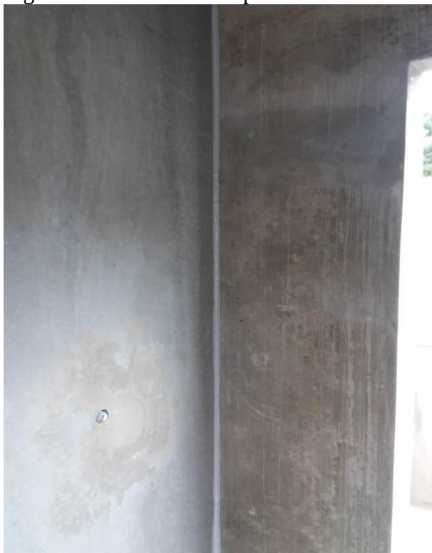
Figura 43 – Junta vertical posicionada no canto finalizada.
