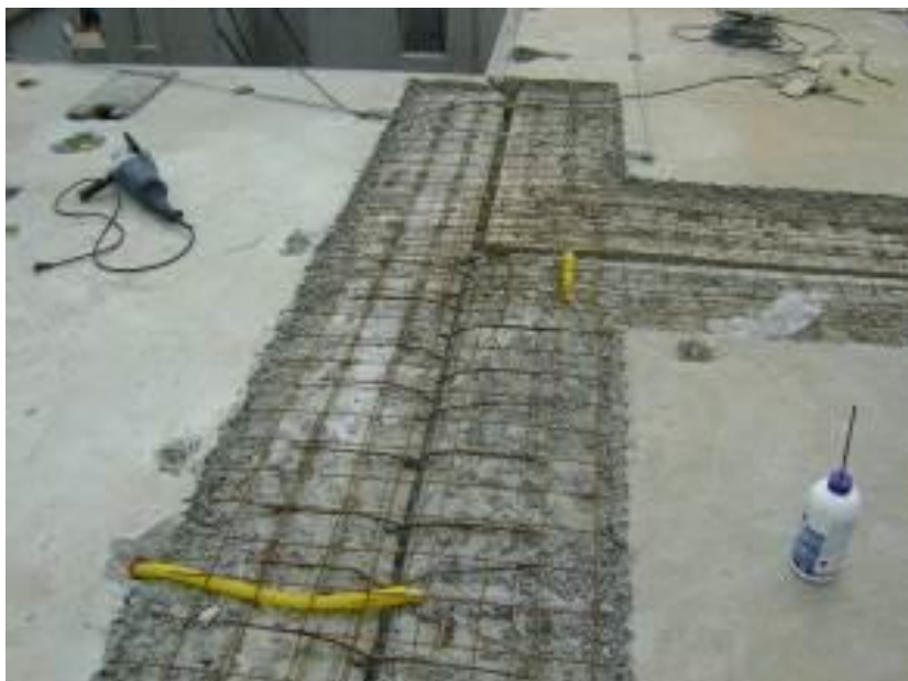
Figura 16 – Rebaixo das lajes com armadura negativa posicionada.
