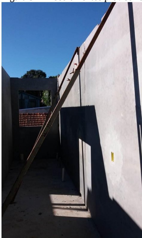
Figura 34 – Escoramentos provisórios.
