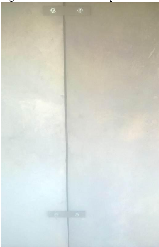
Figura 35 – Travas metálicas provisórias.
