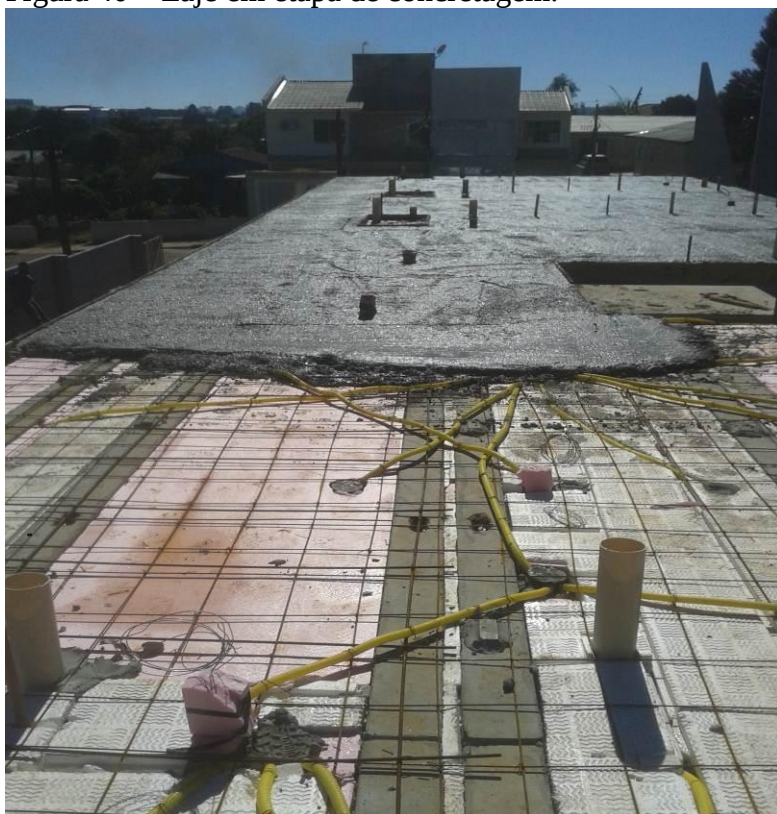
Figura 40 – Laje em etapa de concretagem.
