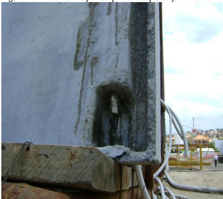
Figura 14 – Rebaixo nos painéis para execução da junta horizontal.
