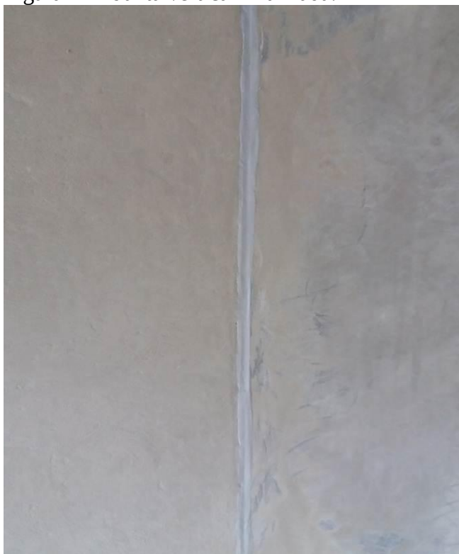
Figura 44 – Junta vertical finalizada.
