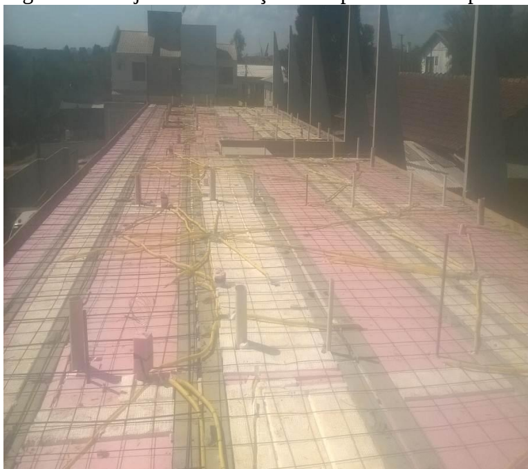
Figura 39 – Laje com instalações complementares e preenchimentos executados.
