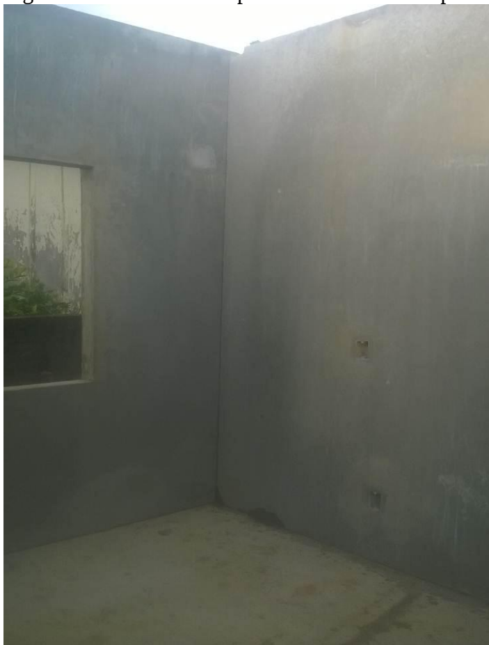
Figura 42 – Junta vertical posicionada no canto após instalação dos painéis.
