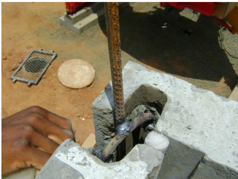
Figura 13 – Solda das juntas horizontais entre painéis.
