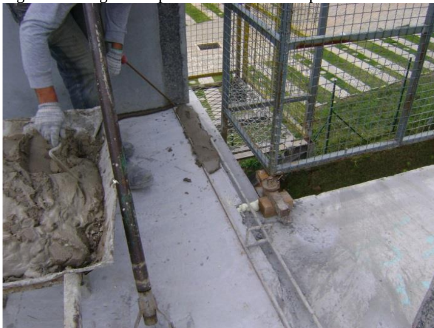
Figura 11 – Argamassa para assentamento dos painéis.
