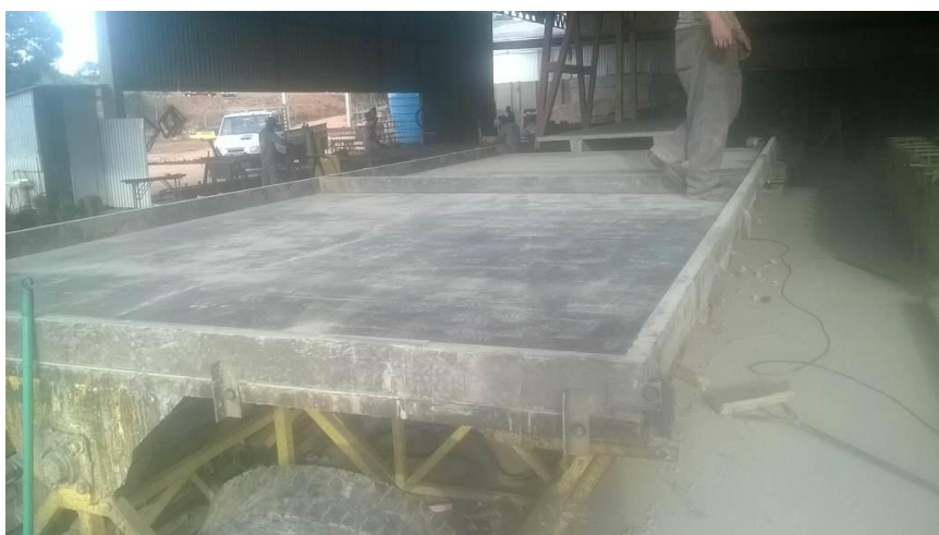
Figura 24 – Fôrma horizontal de painel nas instalações da fábrica.
