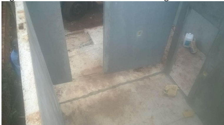
Figura 32 – Painel sendo instalado sobre argamassa.
