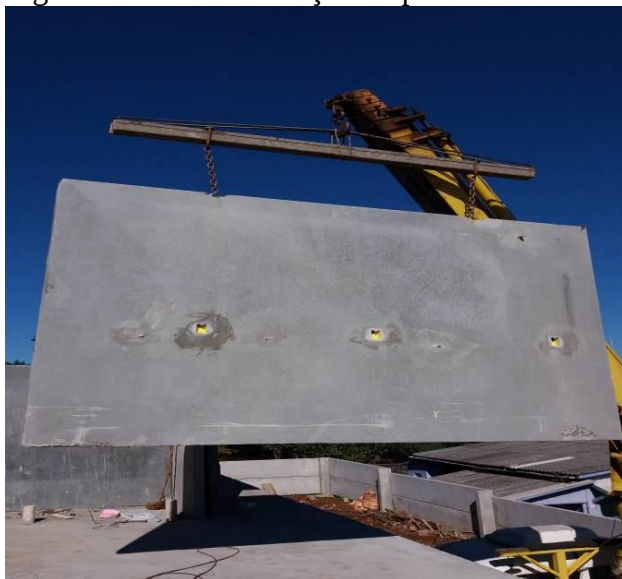
Figura 31 – Movimentação do painel na fase de instalação.
