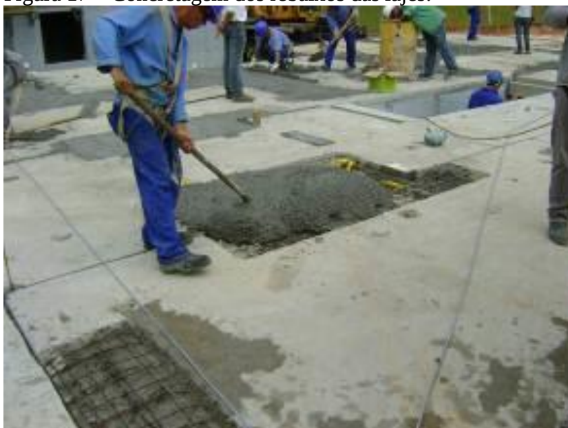
Figura 17 – Concretagem dos rebaixos das lajes.
