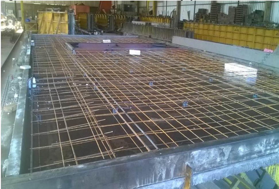
Figura 27 – Fôrma horizontal com armadura e espaçadores instalados.
