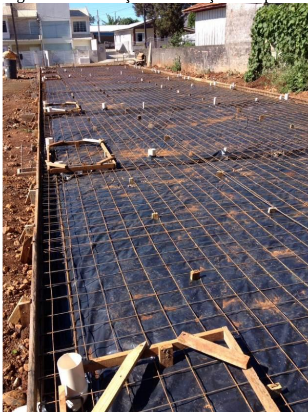
Figura 18 – Execução da fundação do tipo radier na obra.
