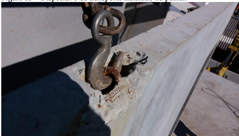
Figura 29 – Dispositivo de transporte instalado no painel.
