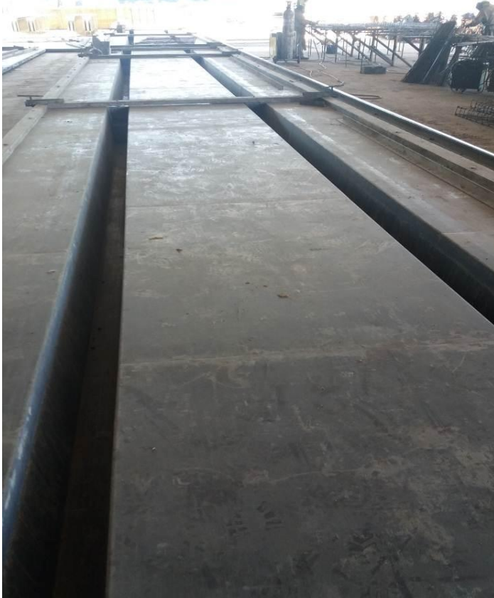
Figura 26 – Fôrma para fabricação de lajes maciças nas instalações da fábrica.
