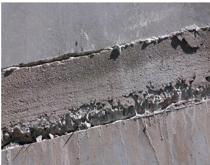
Figura 45 – Junta horizontal, após instalação dos painéis e lajes.
