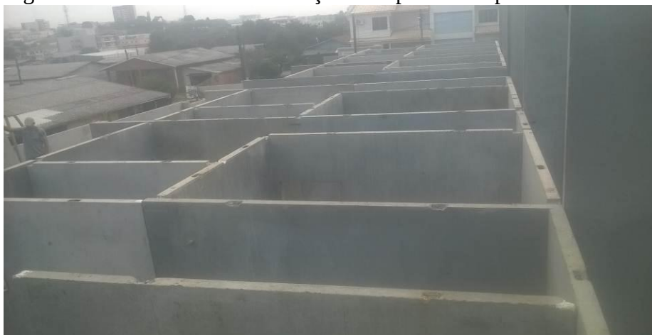
Figura 37 – Conclusão das instalações dos painéis no pavimento térreo.
