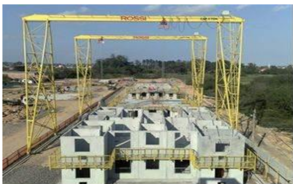
Figura 01 – Execução de edificação residencial.
