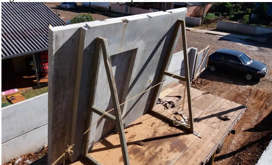
Figura 30 – Painel em fase de transporte.
