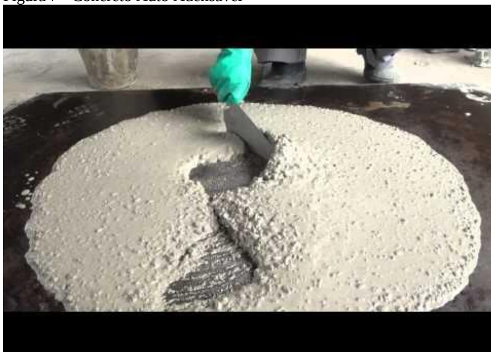
Figura 7 - Concreto Auto Adensável
