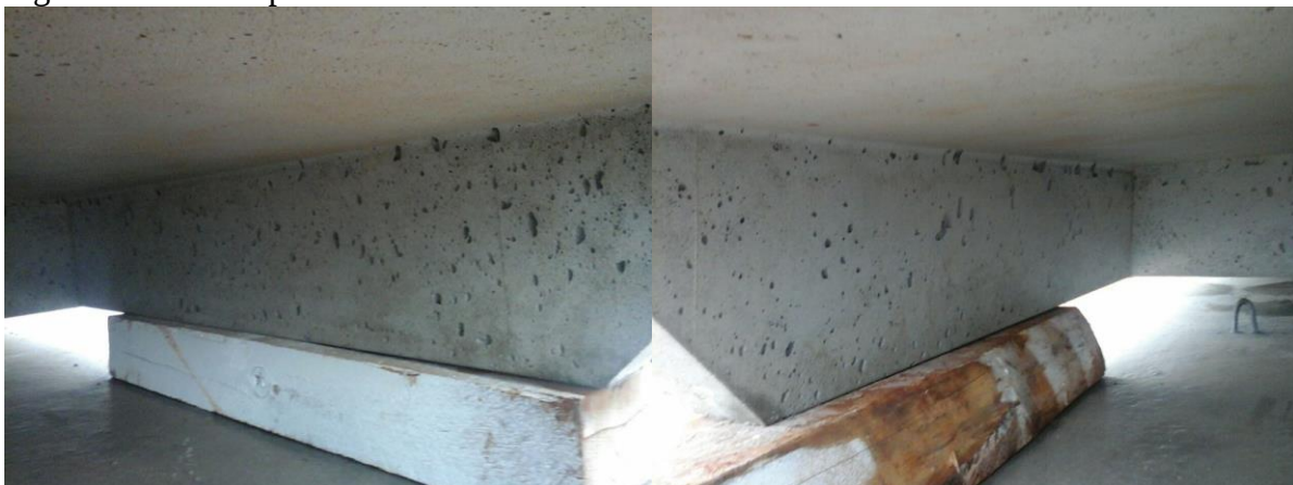
Figura 102 - Placa pré-moldada concretada com concreto auto adensável
