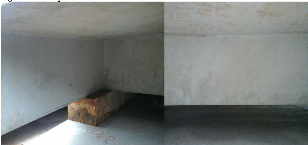
Figura 9 – Placa pré-moldada concretada com concreto auto adensável
