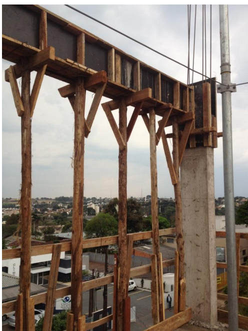
Figura 1: Sistema convencional de concreto armado
