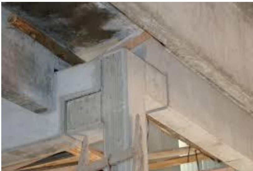
Figura 5: Dente de gerber
