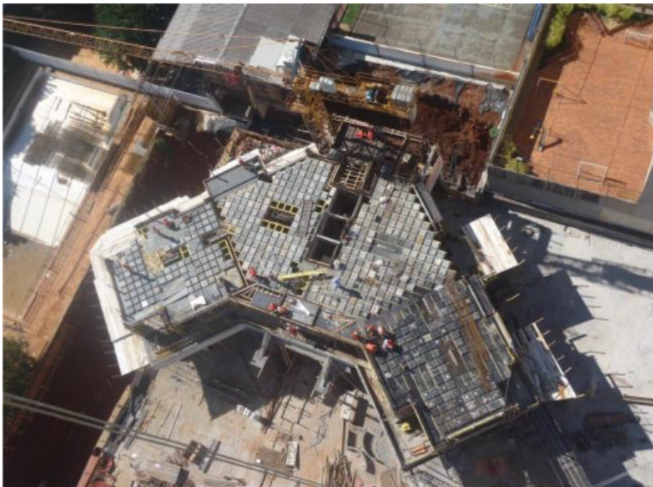
Figura 8: Pré-vigas sendo montadas na obra
