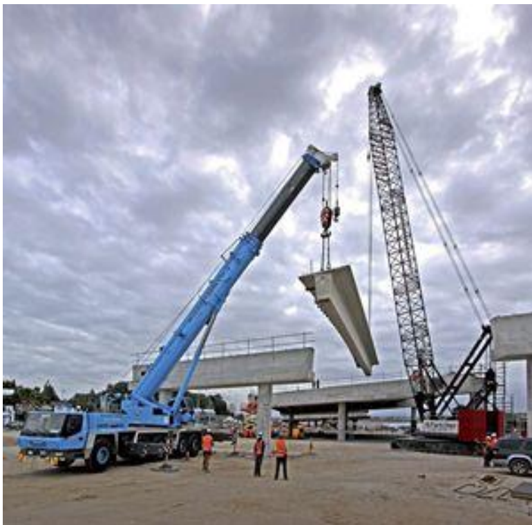
Figura 6: Pré-vigas içadas
