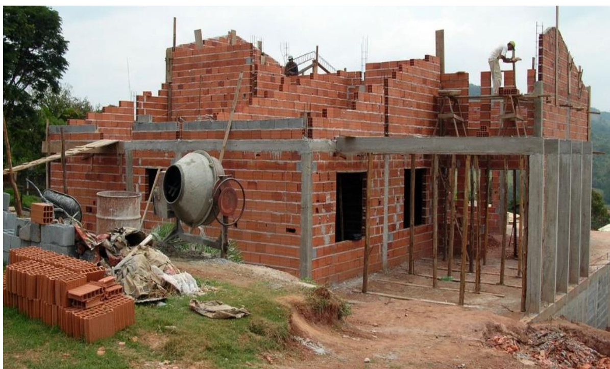
Figura 01: Construção de residência pelo método convencional.
