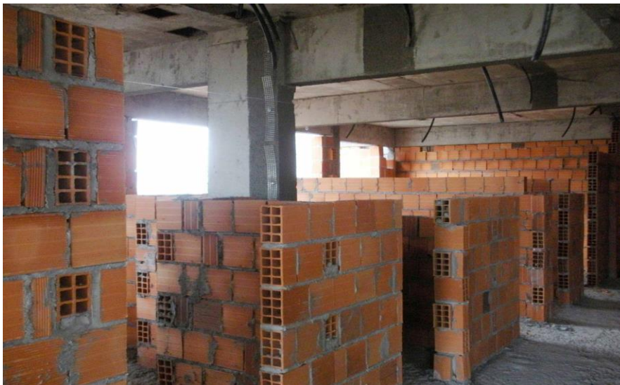
Figura 05: Alvenaria de vedação.
