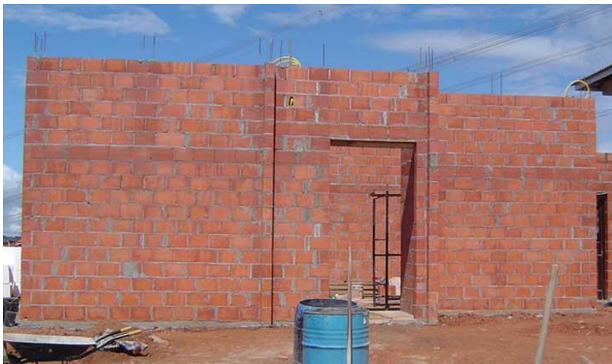
Figura 02: Construção de residência em alvenaria estrutural.
