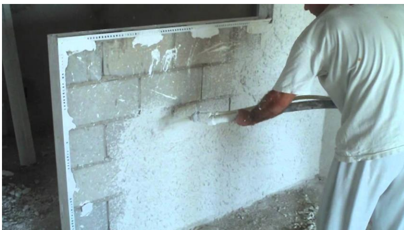
Figura 08: Aplicação de gesso em alvenaria estrutural.
