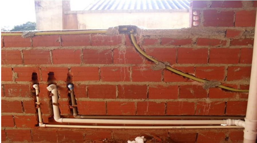
Figura 9: Ilustração do processo executivo do Método Convencional.
