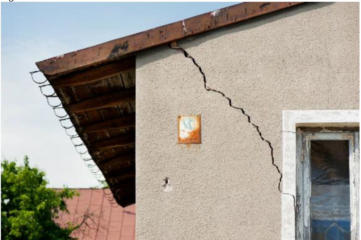
Figura 6 - Rachadura Residência
