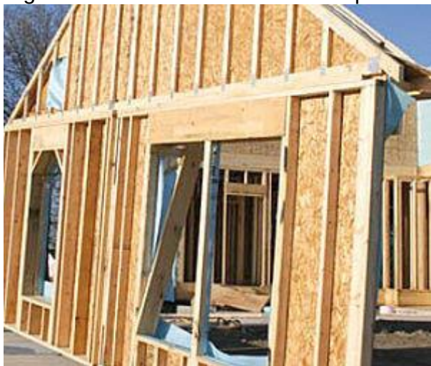
Figura 13: Perfis de madeira e chapas OSB.
