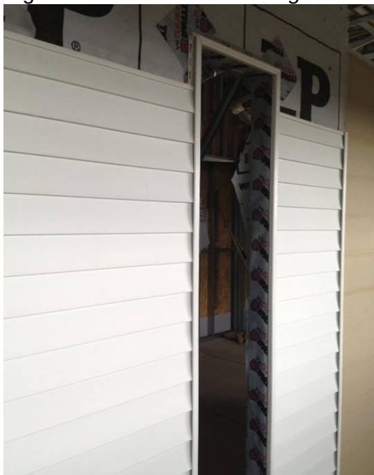
Figura 6: Revestimento Siding .
