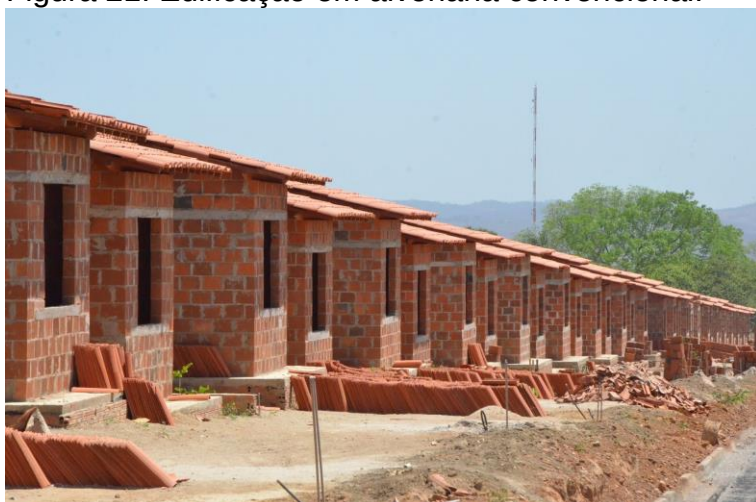
Figura 21: Edificação em alvenaria convencional.
