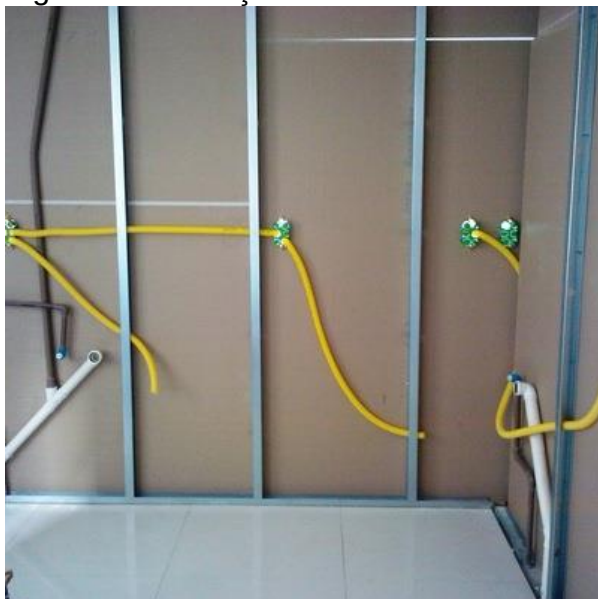
Figura 9: Instalações elétrica.
