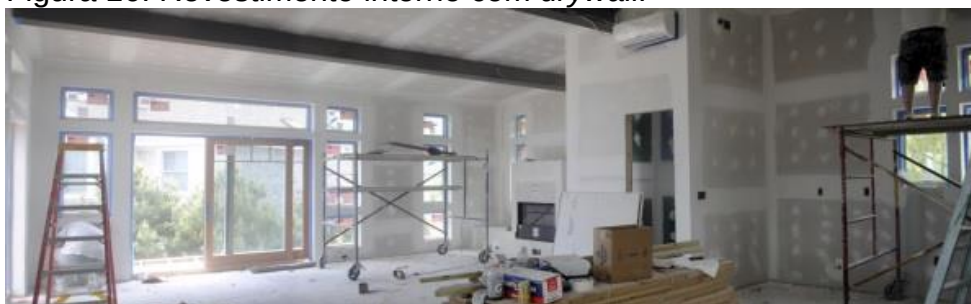
Figura 16: Revestimento interno com drywall .
