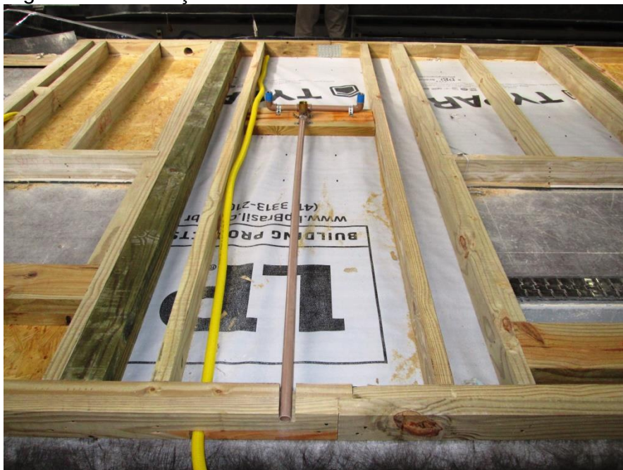
Figura 18: Instalações elétricas e hidráulicas.
