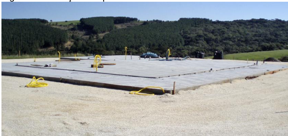
Figura 1: Fundação do tipo radier .
