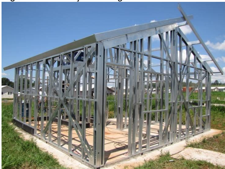
Figura 3: Edificação em Light Steel Frame .
