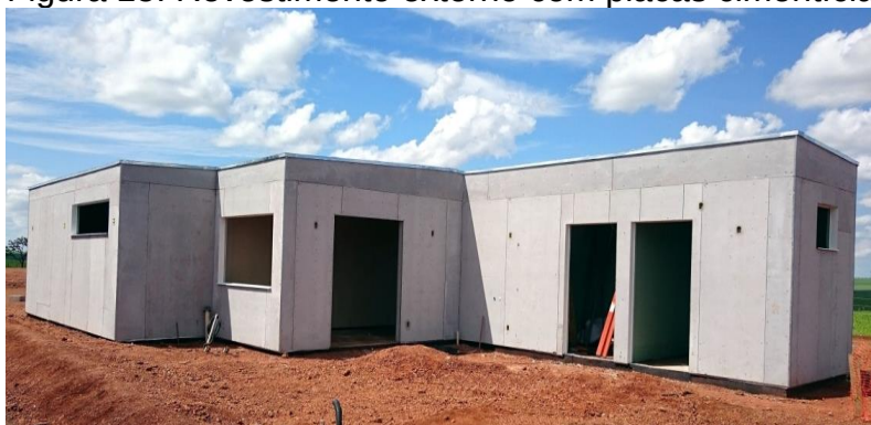
Figura 15: Revestimento externo com placas cimentícias.
